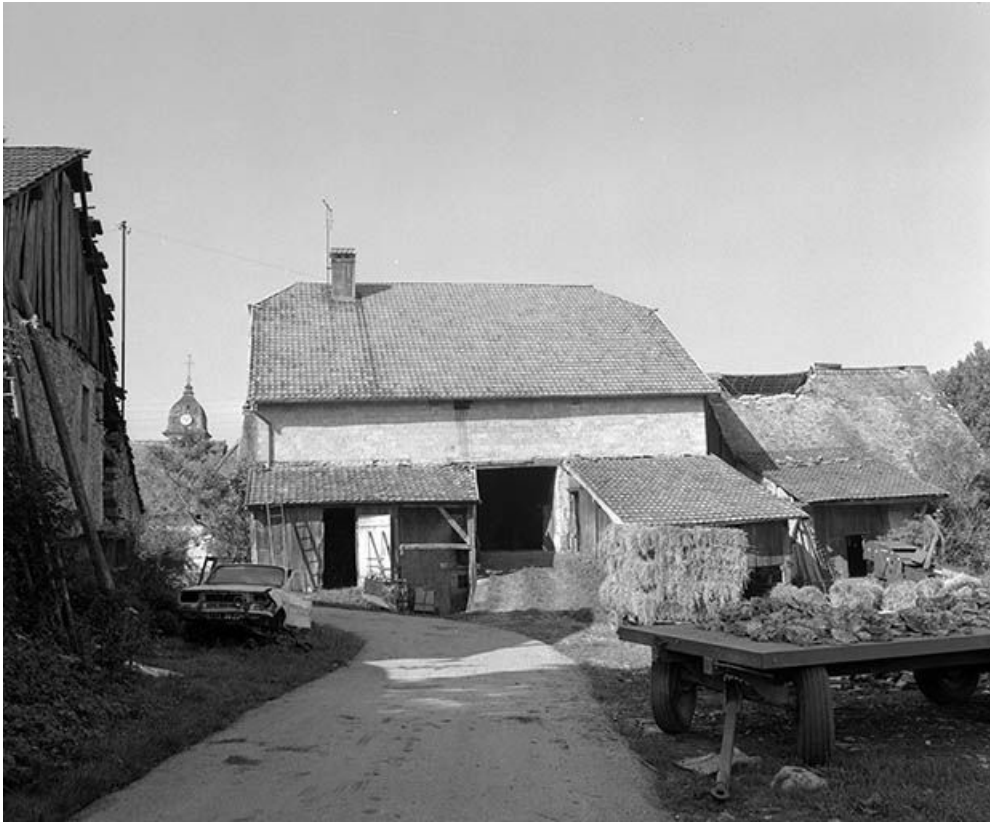
Face latérale : l'entrée de grange.
