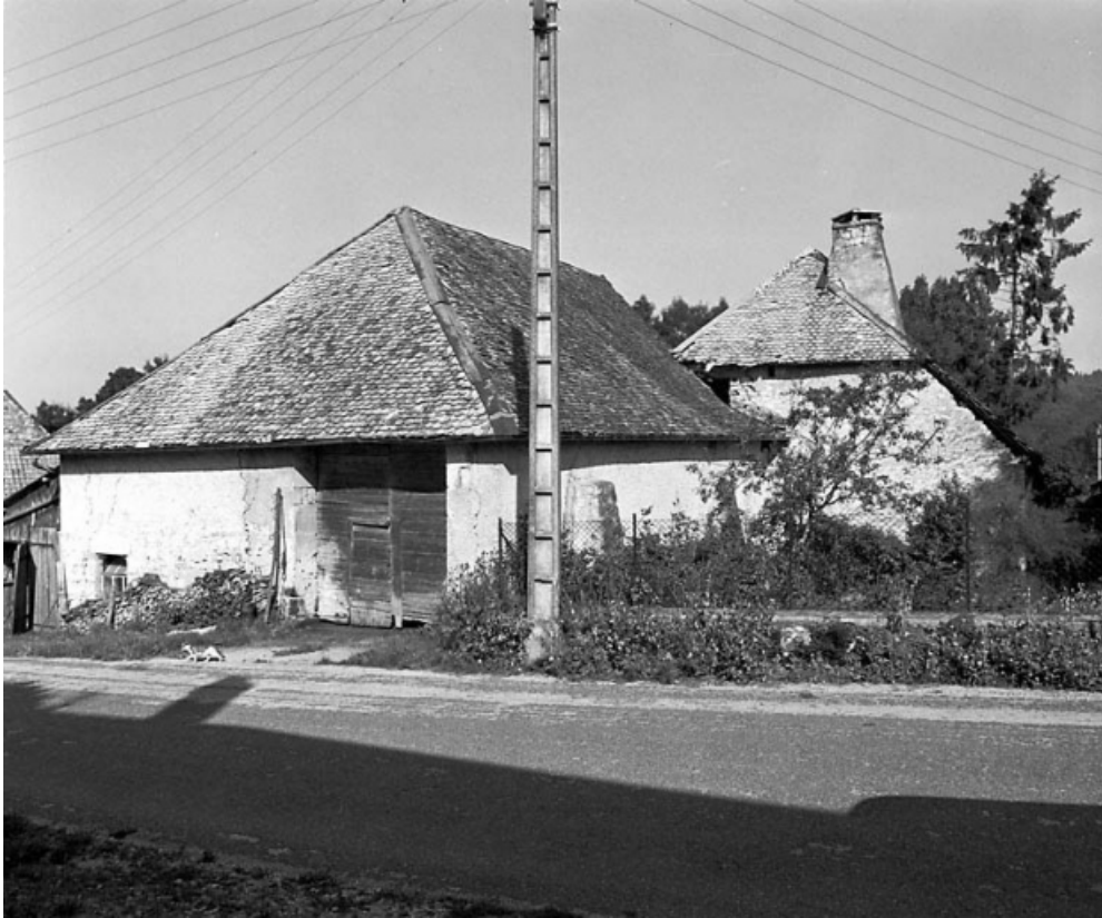
Vue d'ensemble depuis la rue. 25, Trépot
