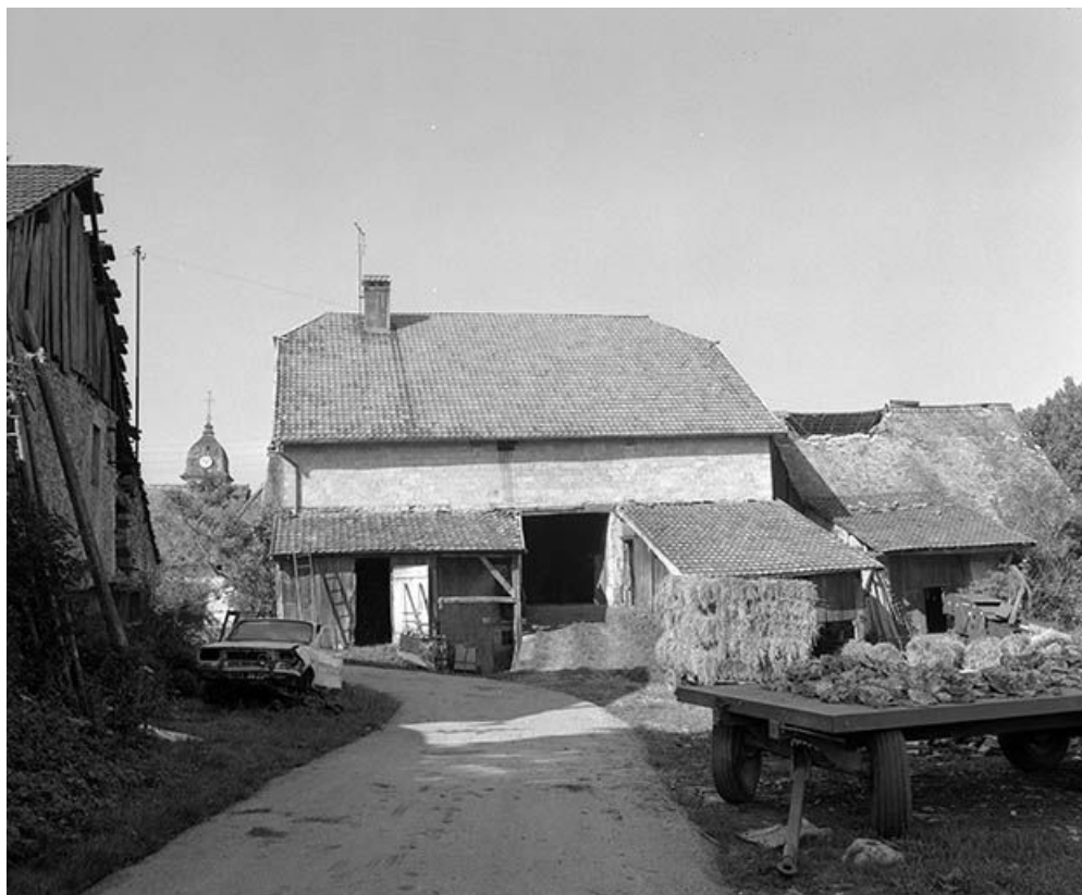
Face latérale : l'entrée de grange.
