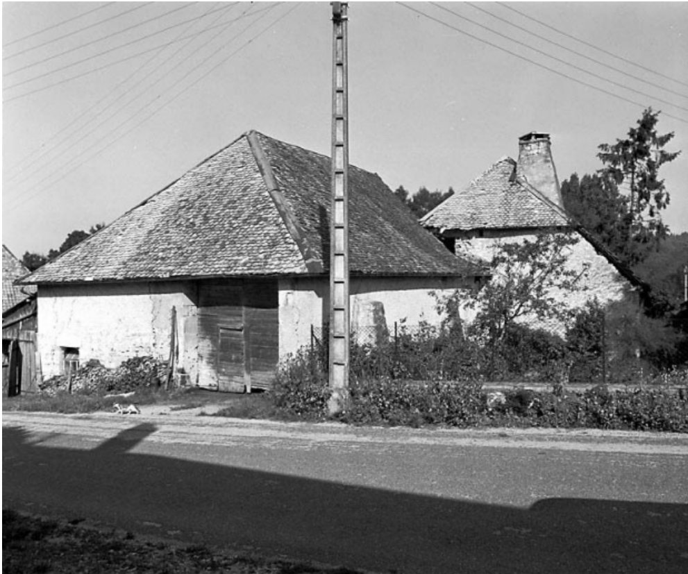
Vue d'ensemble depuis la rue. 25, Trépot
