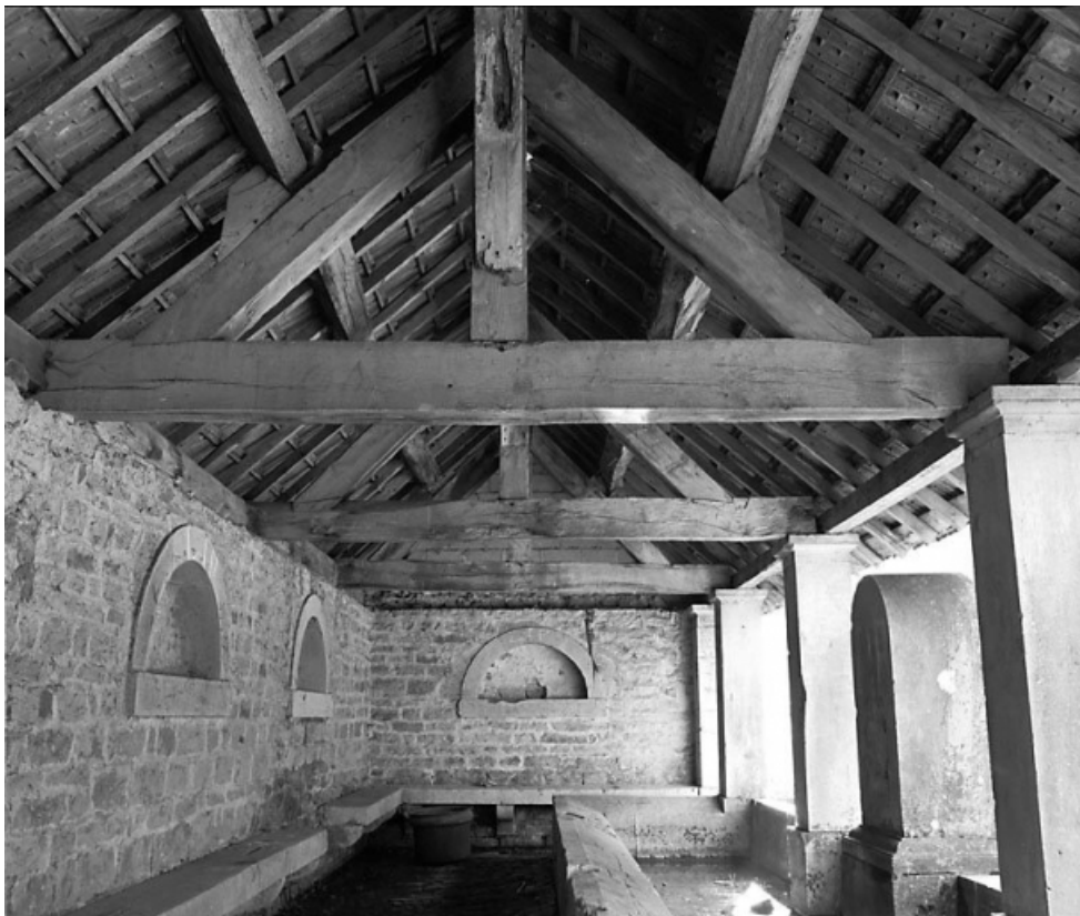
Intérieur : vue de trois quarts droit.
