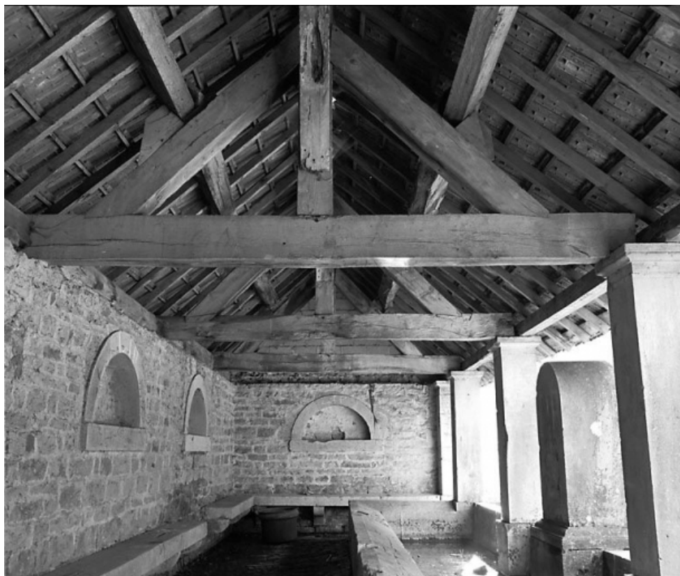
Intérieur : vue de trois quarts droit.
