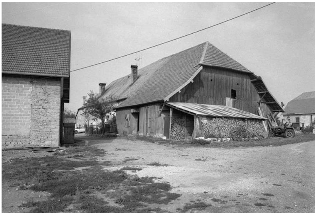
Ferme située rue du Château (?), cadastrée 1972 AB 185 : façade antérieure, vue trois quarts droit. 25, Trépot
