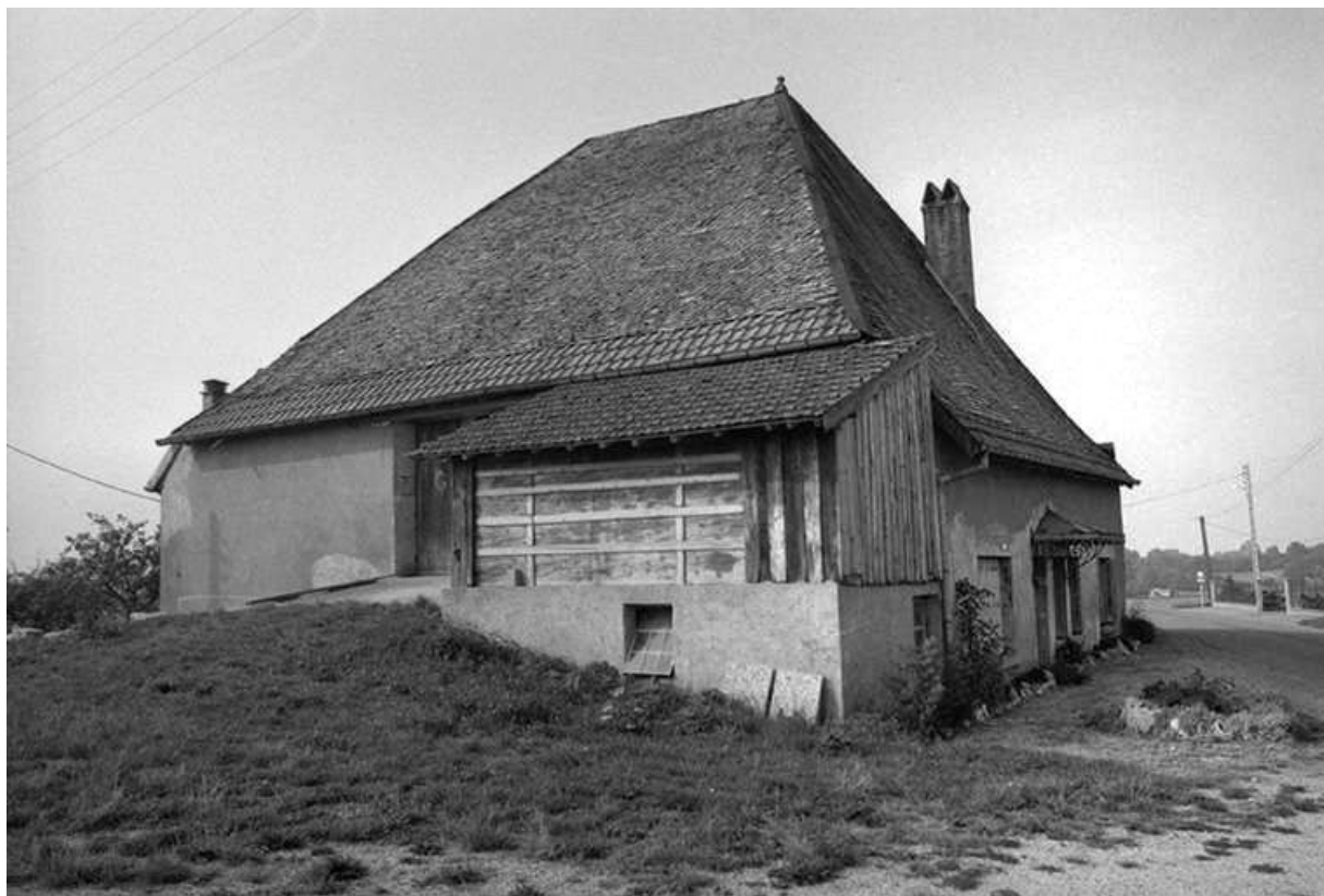
Ferme cadastrée 1972 ZA 84 : façade antérieure et façade latérale gauche. 25, Trépot
