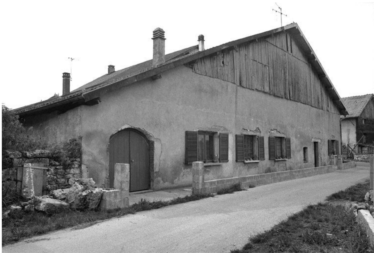
Ferme située 10 rue du Chalet : façade antérieure. 25, Trépot
