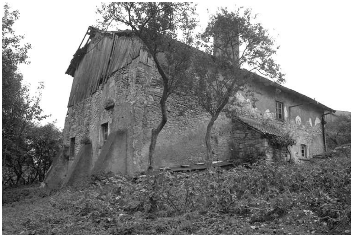
Ferme cadastrée 1972 AB 87, détruite après 1976 : façade postérieure et façade latérale gauche. 25, Trépot
