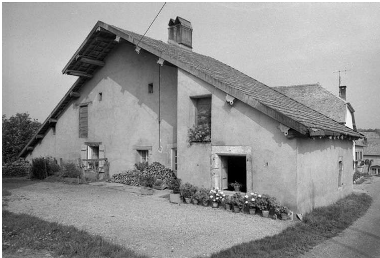
Ferme située rue du Château, cadastrée 1972 AB 76 : façade antérieure, trois quarts droit. 25, Trépot
