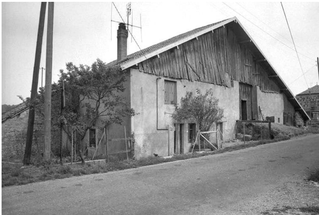
Ferme située rue des Vergers, cadastrée 1972 AB 62 : façade antérieure, vue de trois quarts gauche. 25, Trépot
