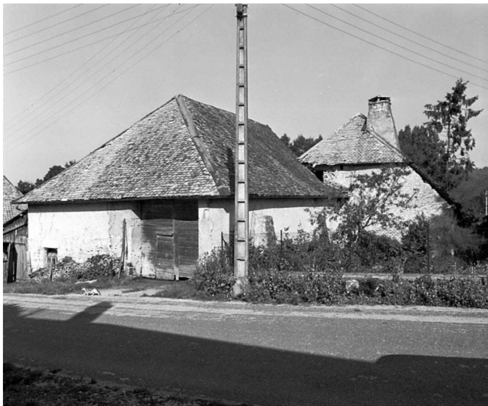
Vue d'ensemble depuis la rue. 25, Trépot
