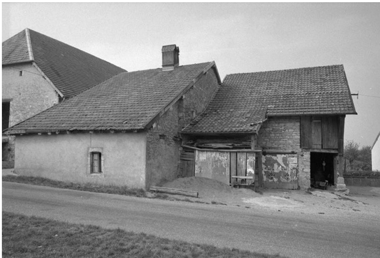
Ferme située rue du Château, cadastrée 1972 AB 76 : façade latérale droite. 25, Trépot
