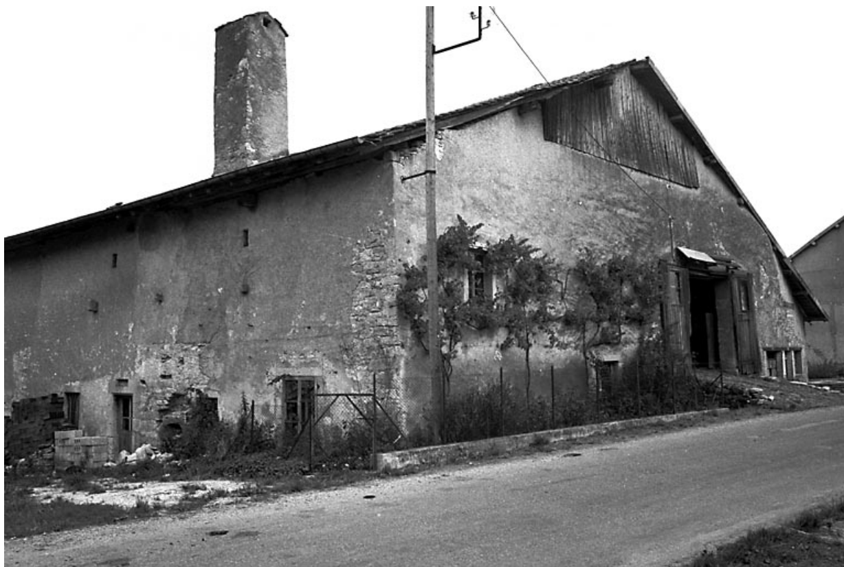
Façade antérieure et face latérale gauche. 25, Trépot
