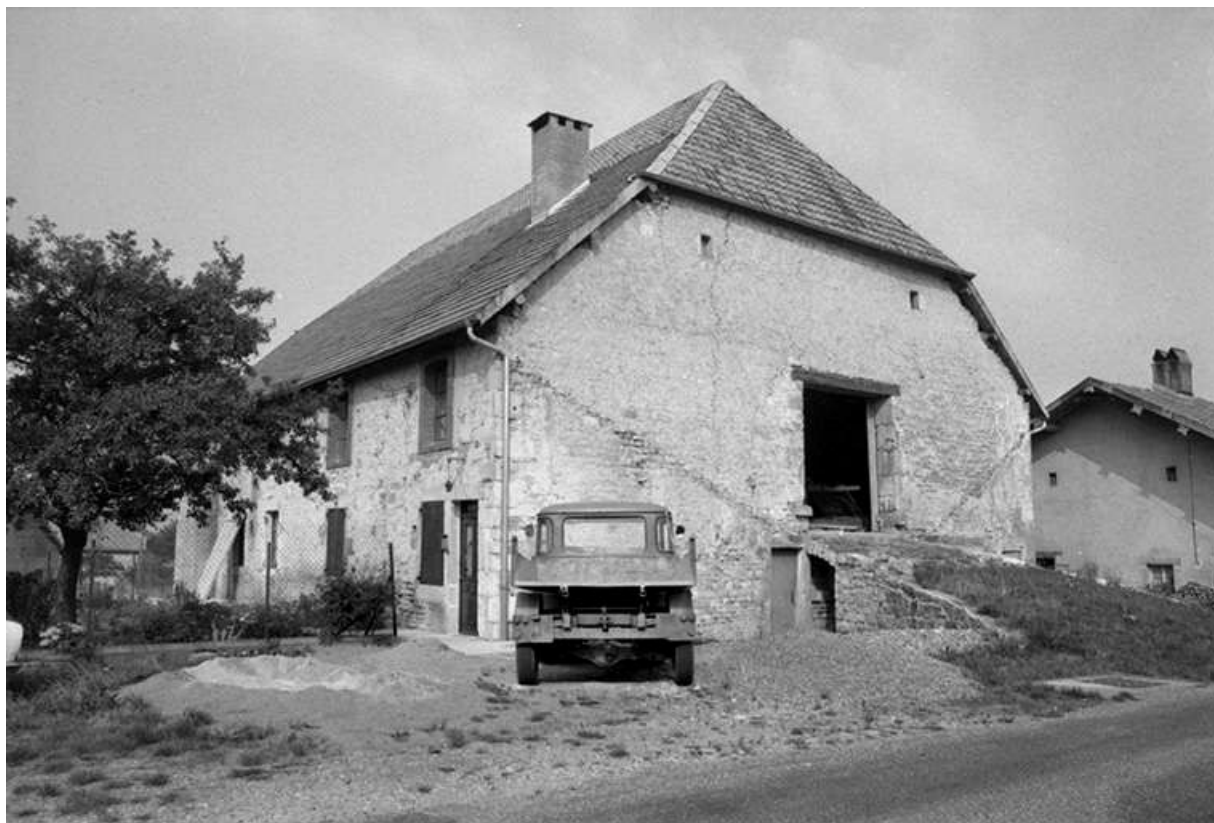
Ferme située 18 rue du Château : vue depuis la rue. 25, Trépot
