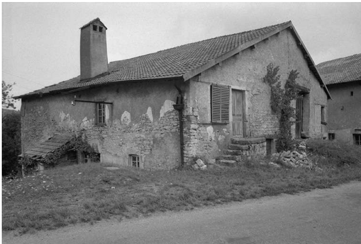
Ferme cadastrée 1972 AB 87, détruite après 1976 : façade antérieure et façade latérale gauche. 25, Trépot
