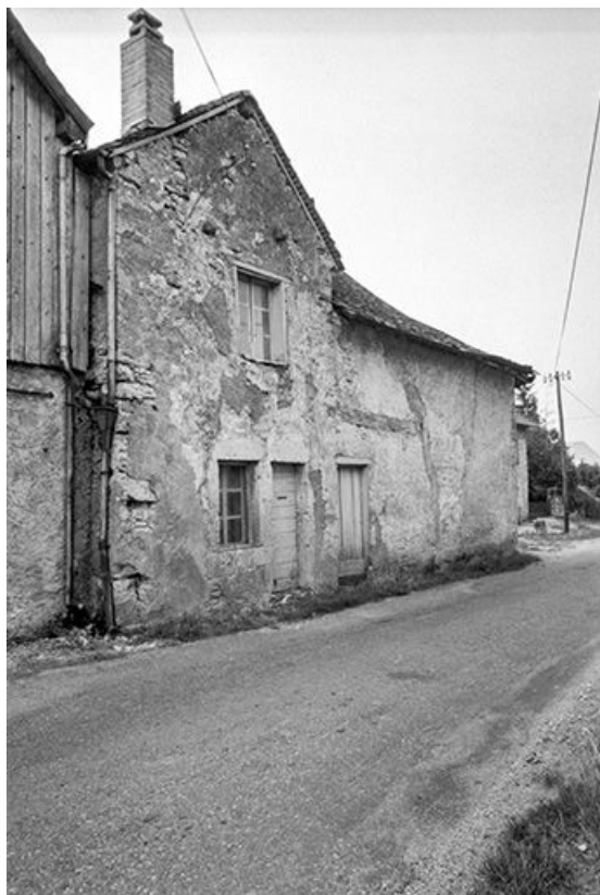
Ferme cadastrée 1972 AB 80 : façade antérieure. 25, Trépot
