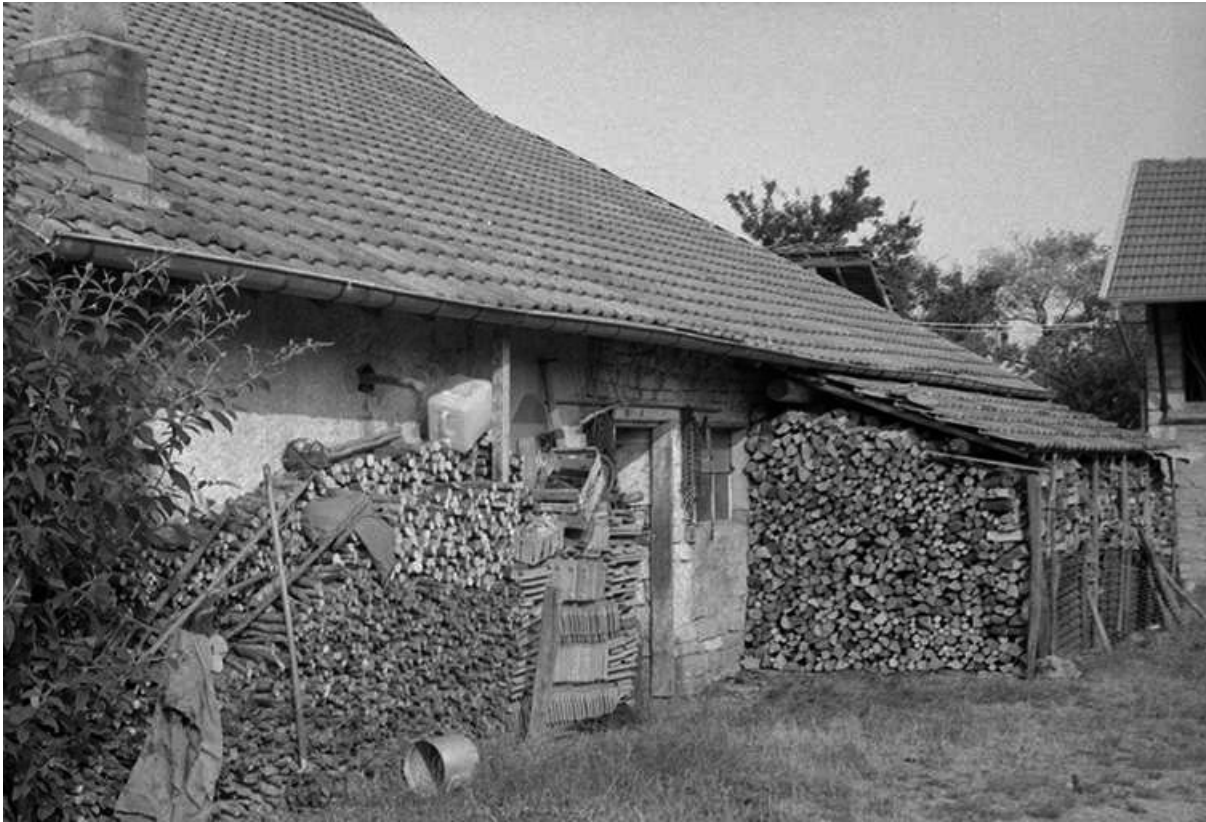
Façade latérale droite. 25, Tarcenay Grande Rue
