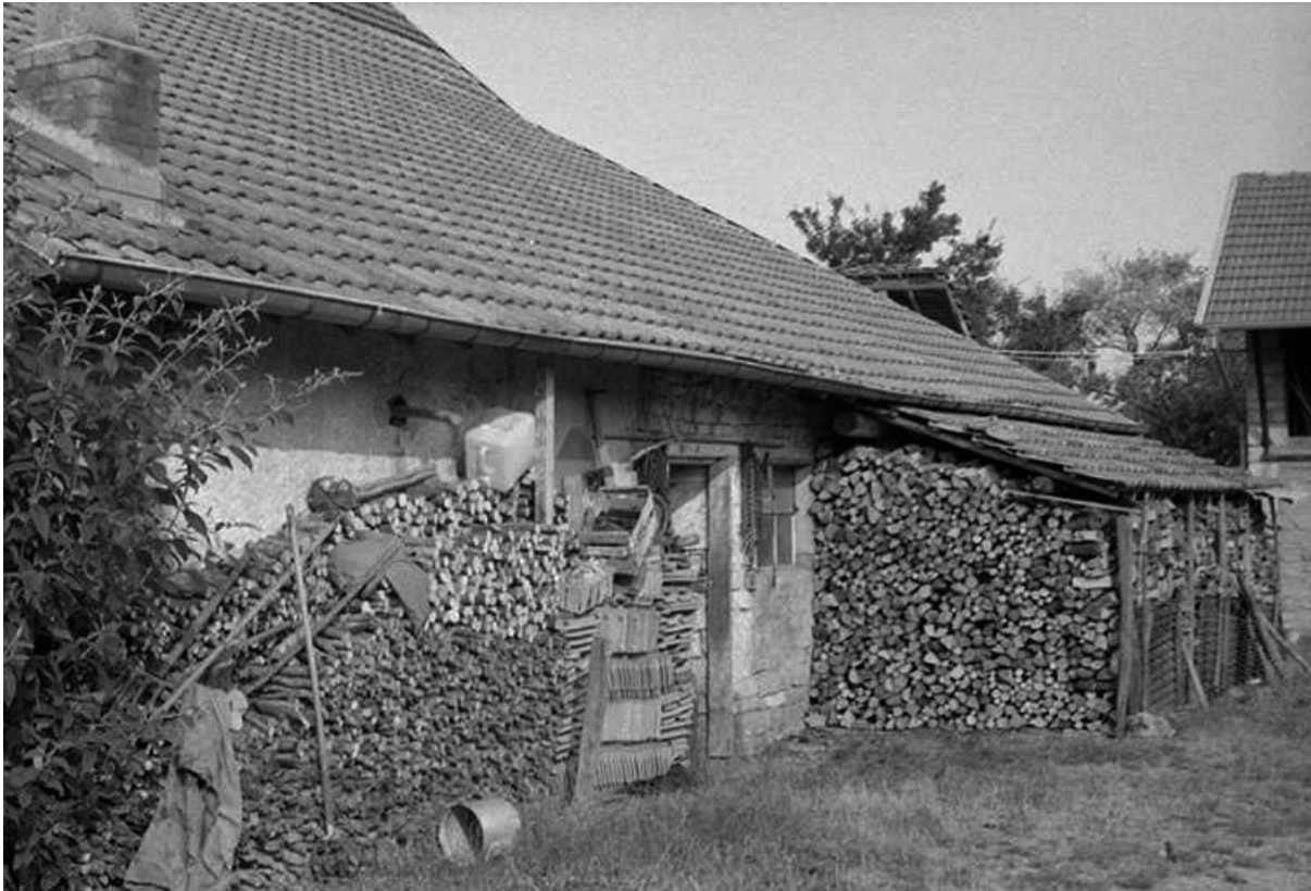
Façade latérale droite. 25, Tarcenay Grande Rue
