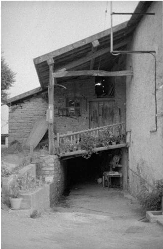
Façade latérale gauche : le pont de grange. 25, Tarcenay Grande Rue
