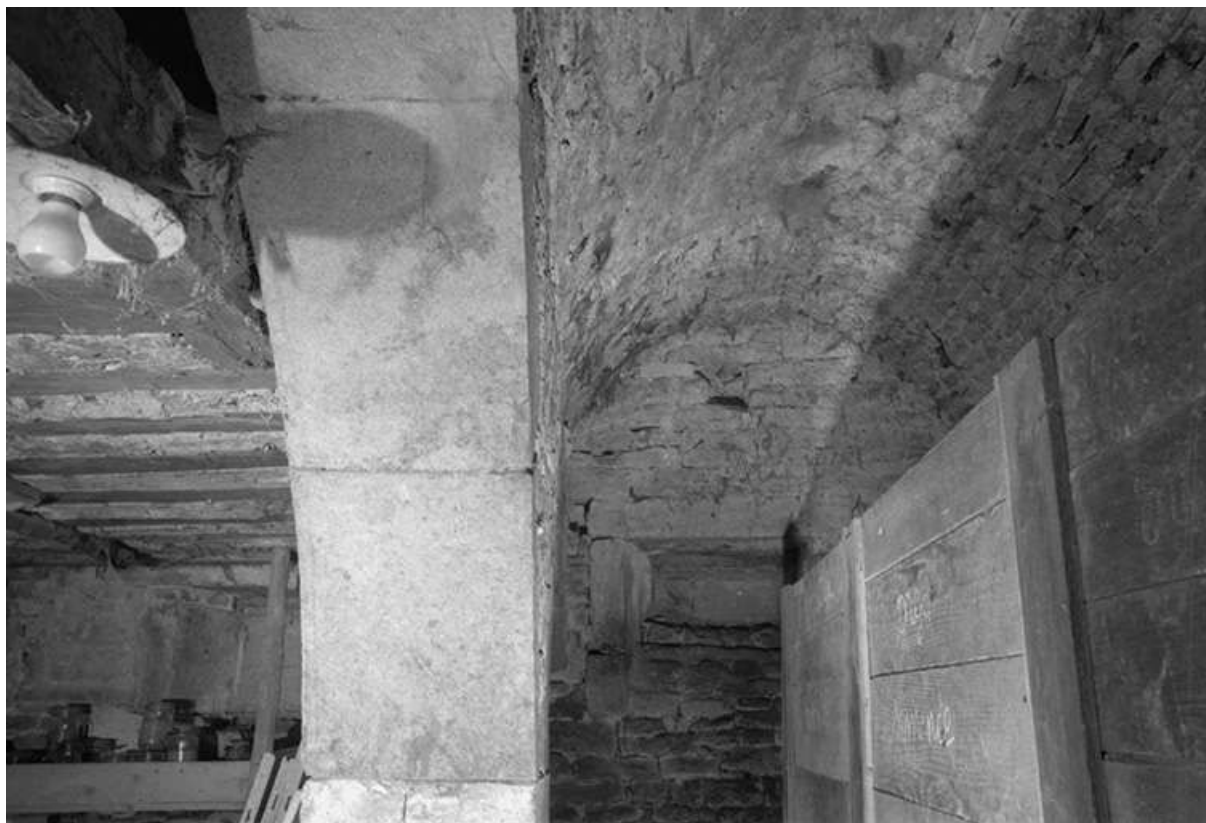
Intérieur : voûte de la cave.
