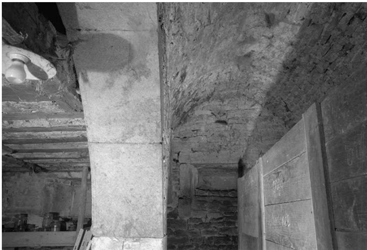
Intérieur : voûte de la cave.
