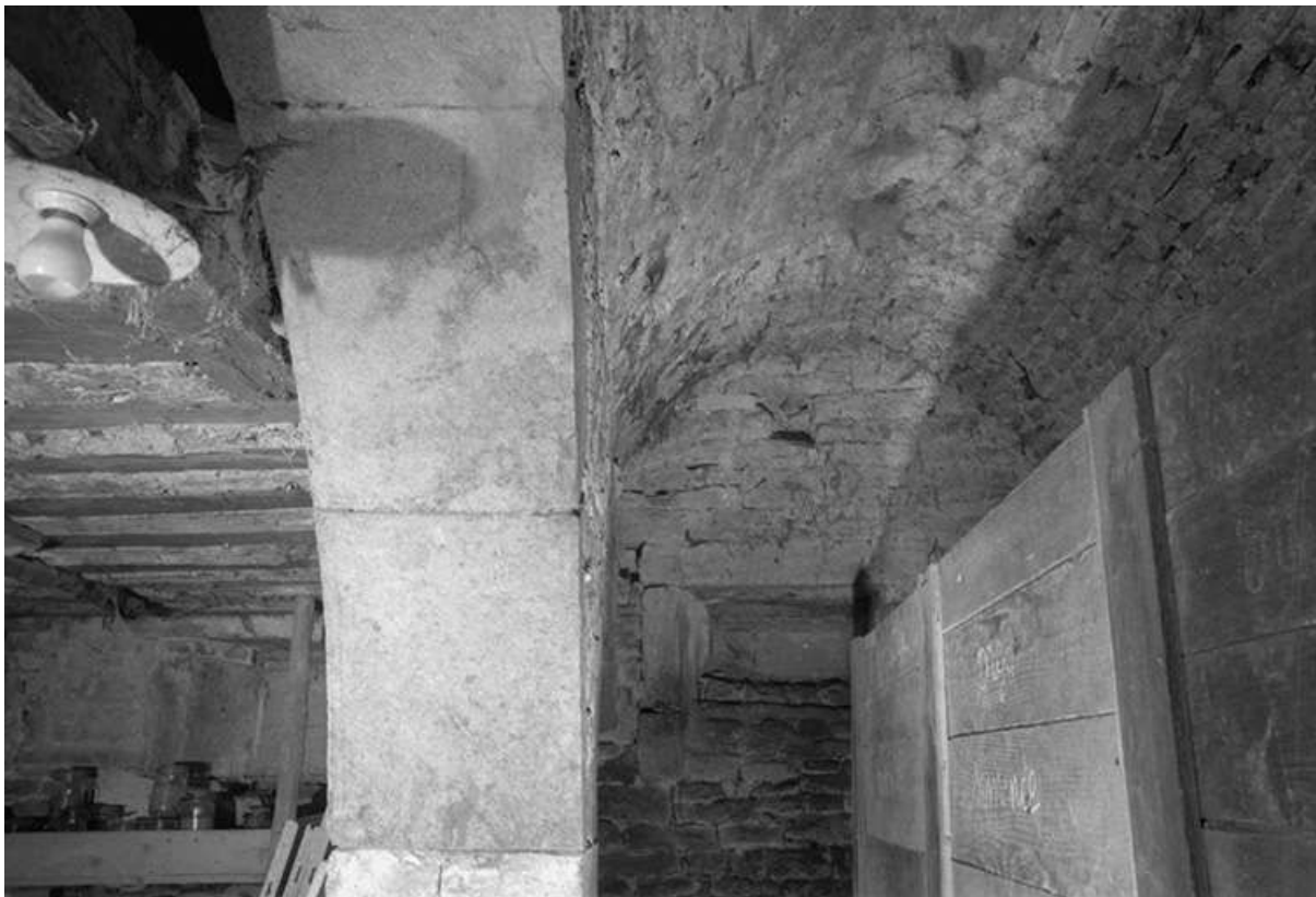
Intérieur : voûte de la cave. 25, Tarcenay Grande Rue
