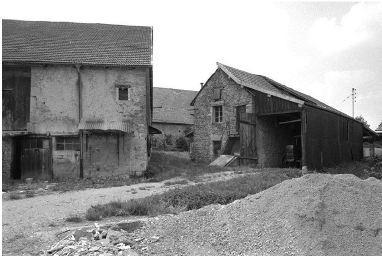
Ferme cadastrée 1965 ZM 102 : vue d'ensemble. 25, Tarcenay
