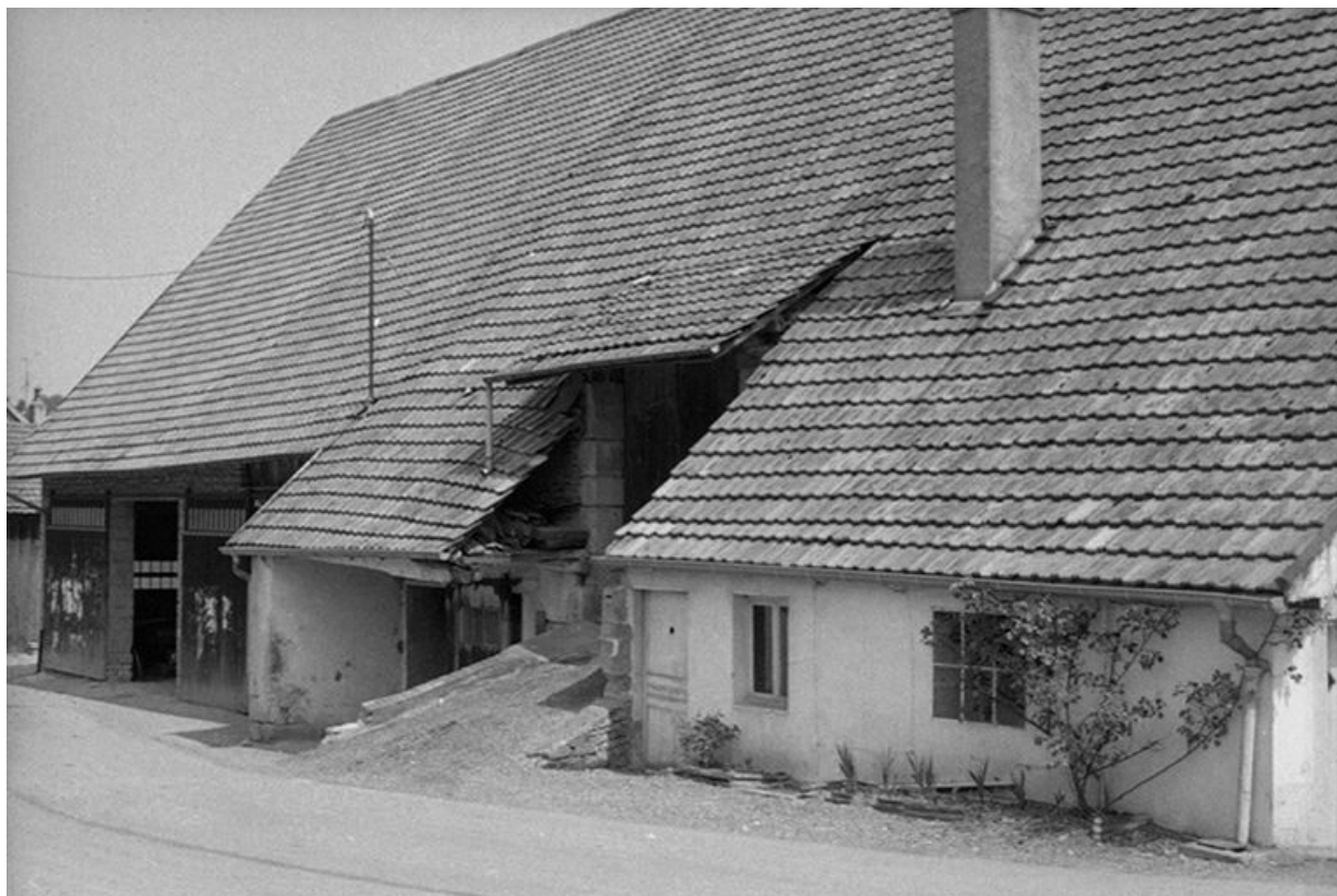
Ferme située à l'angle de la rue du Chalet et de la Grande Rue : façade donnant sur la rue du Chalet 25, Tarcenay
