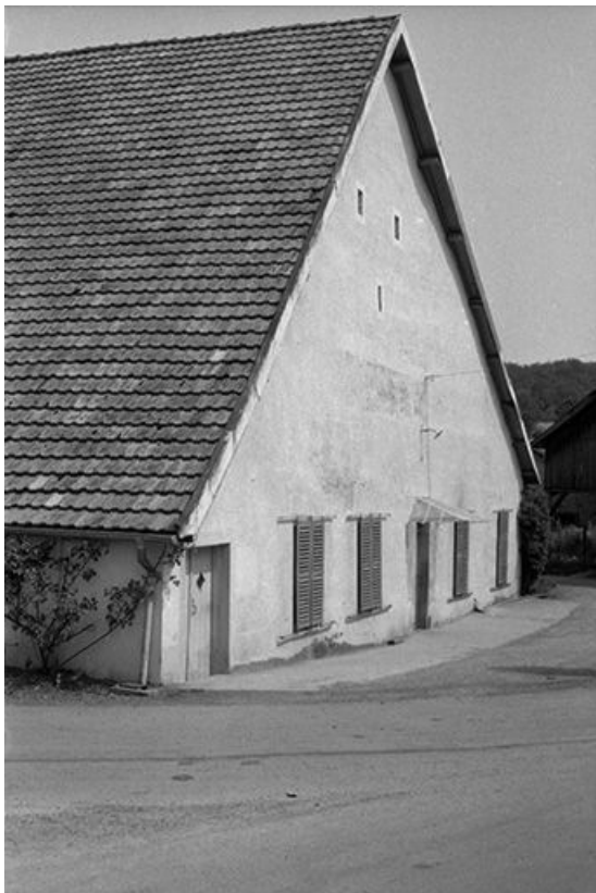
Ferme située à l'angle de la rue du Chalet et de la Grande Rue : façade donnant sur la Grande Rue. 25, Tarcenay
