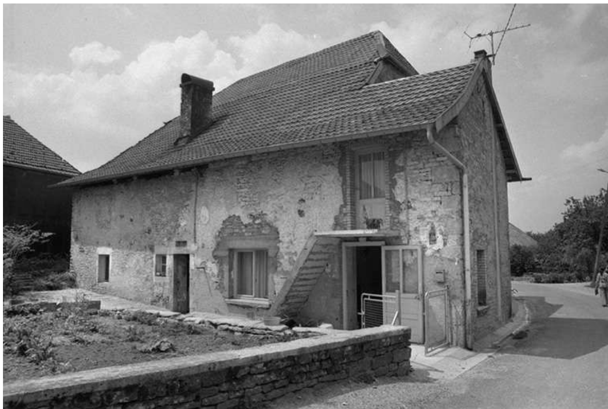
Ferme cadastrée 1965 ZM 103 : vue générale. 25, Tarcenay
