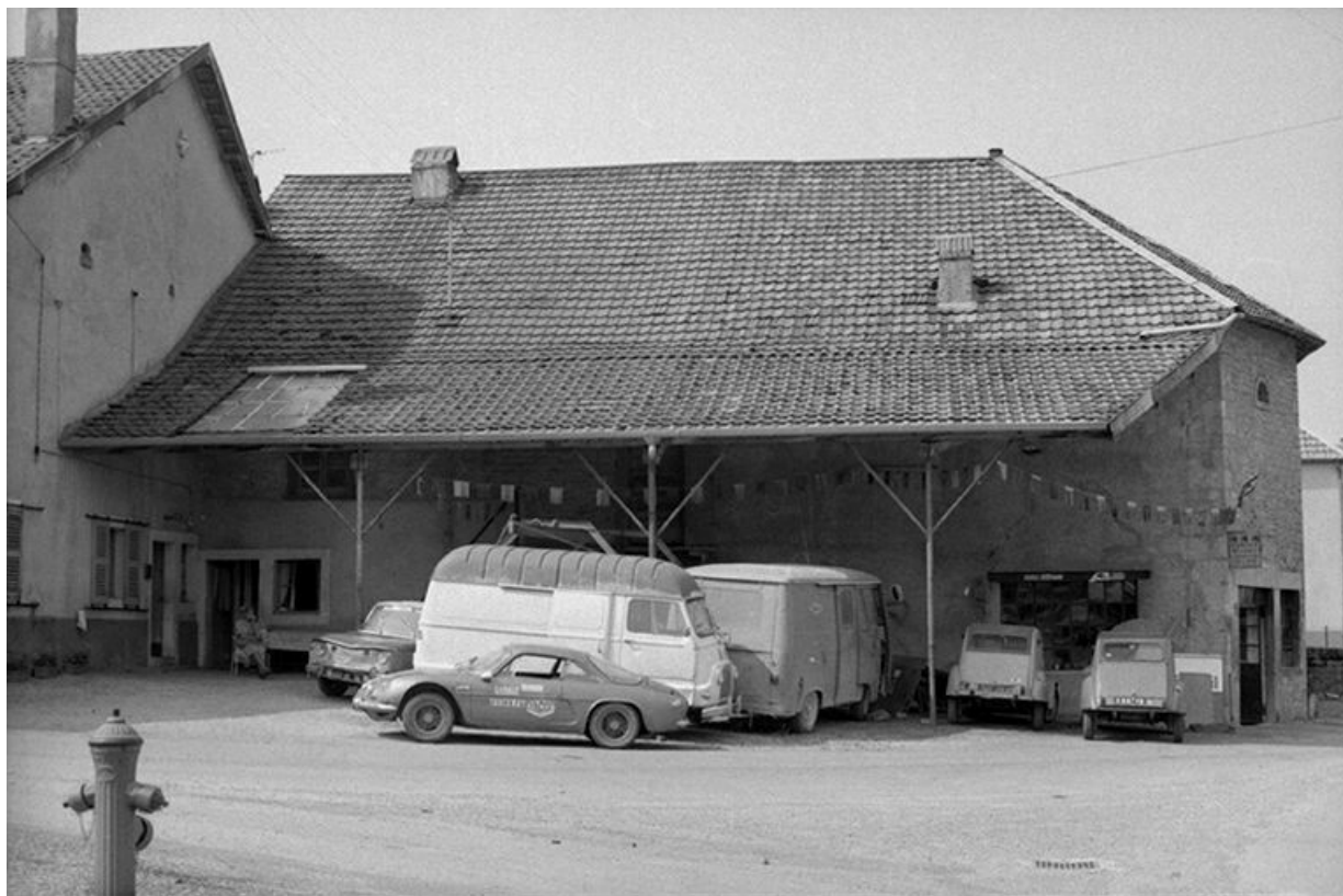
Ferme située 2 rue du Tilleul : façade antérieure. 25, Tarcenay
