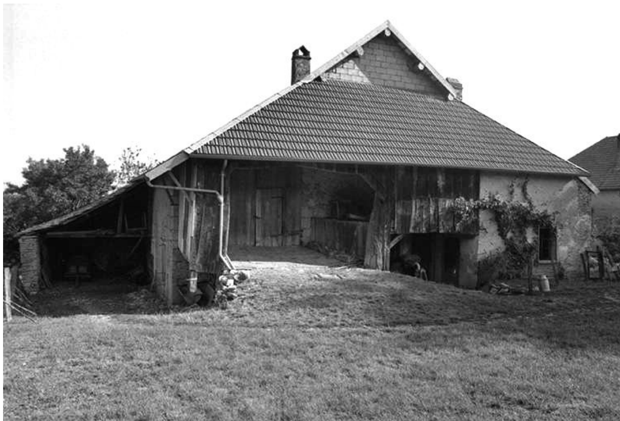
Ferme située au lieudit Les Rubis : façade antérieure. 25, Tarcenay
