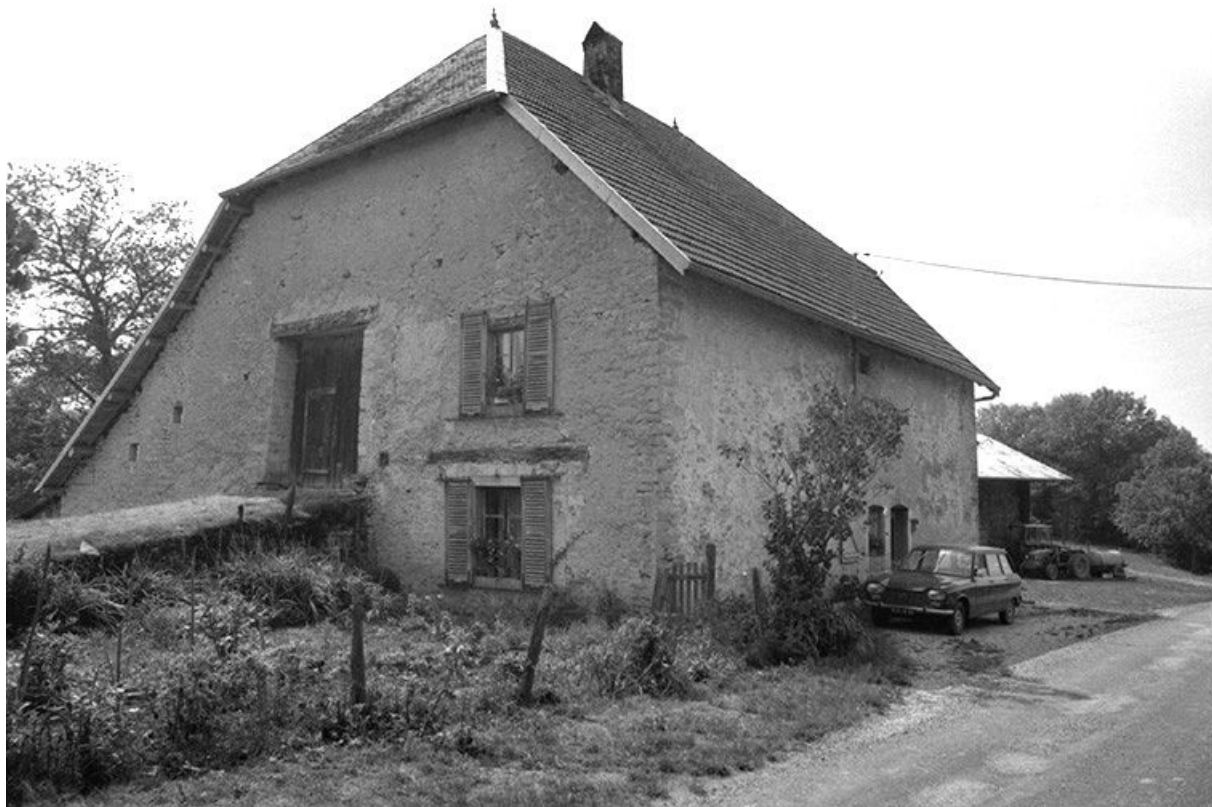
Ferme située au lieudit Les Cloutiers : façades antérieure et latérale droite. 25, Tarcenay
