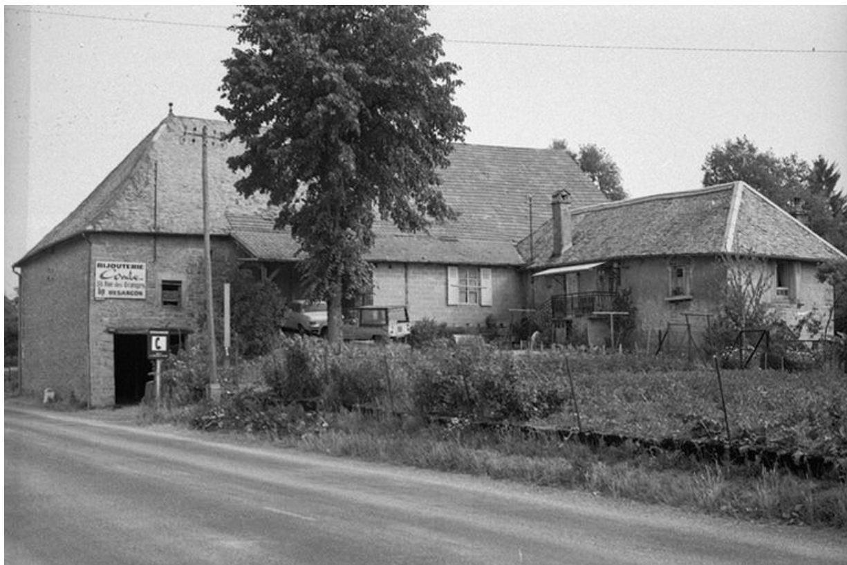
Ferme cadastrée 1965 ZM 2, située au lieudit Chez Barraguet (?) : vue générale. 25, Tarcenay
