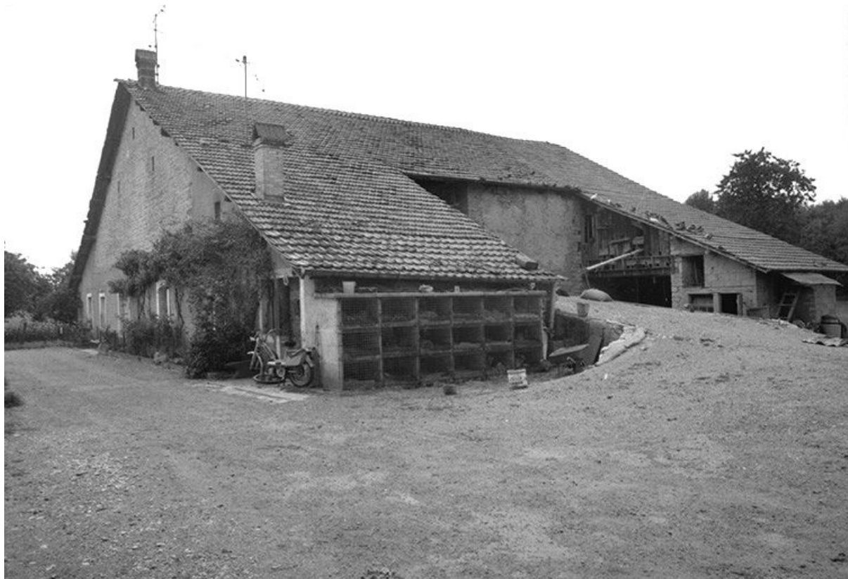
Ferme cadastrée 1965 ZK 176, située au lieu-dit les Fougères : vue générale. 25, Tarcenay
