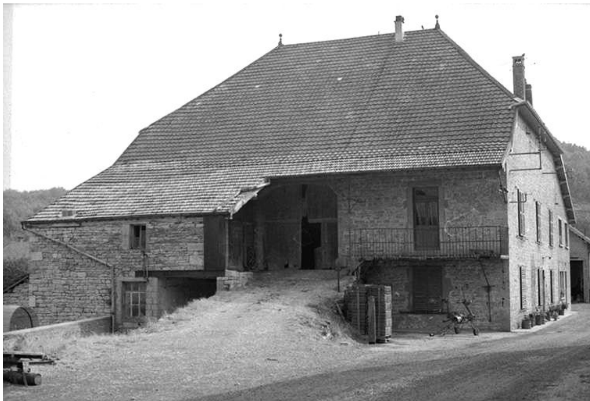
Ferme cadastrée 1965 ZM 14, située rue du Tilleul : façade latérale gauche. 25, Tarcenay
