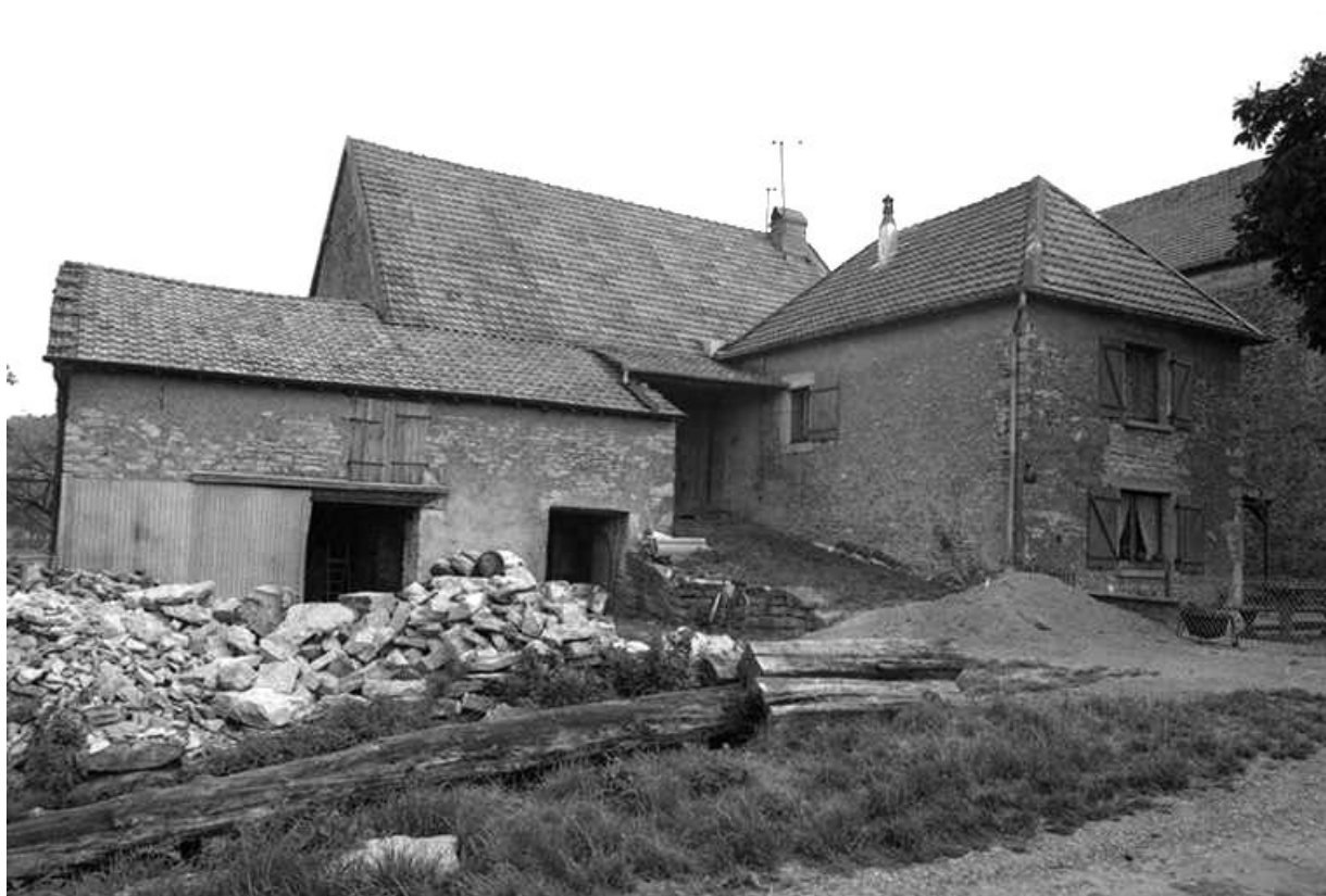
Ferme située 6 rue de Sous Velles : vue d'ensemble. 25, Tarcenay
