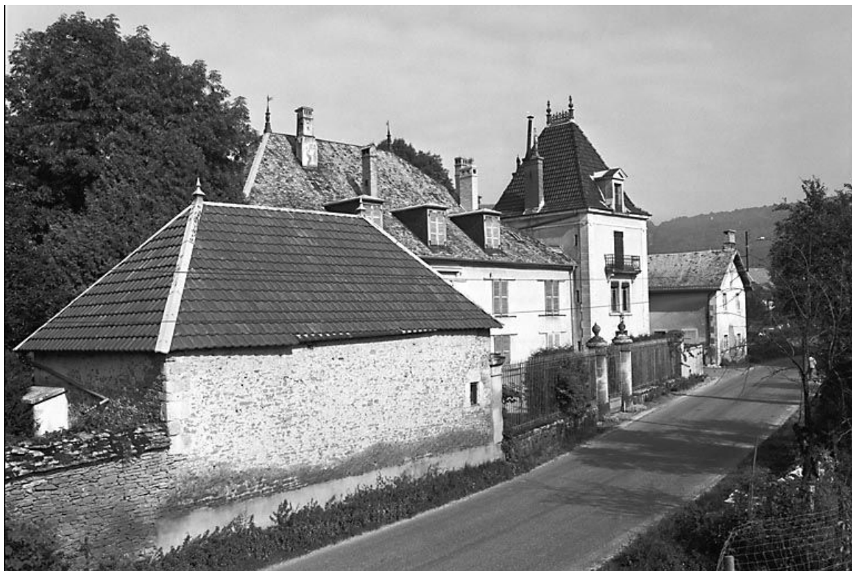
Vue d'ensemble. 25, Scey-Maisières
