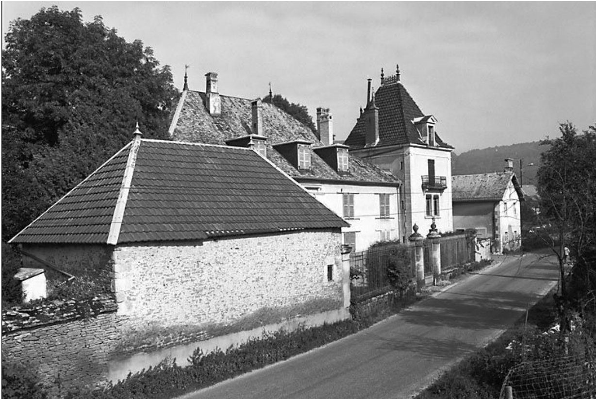
Vue d'ensemble. 25, Scey-Maisières
