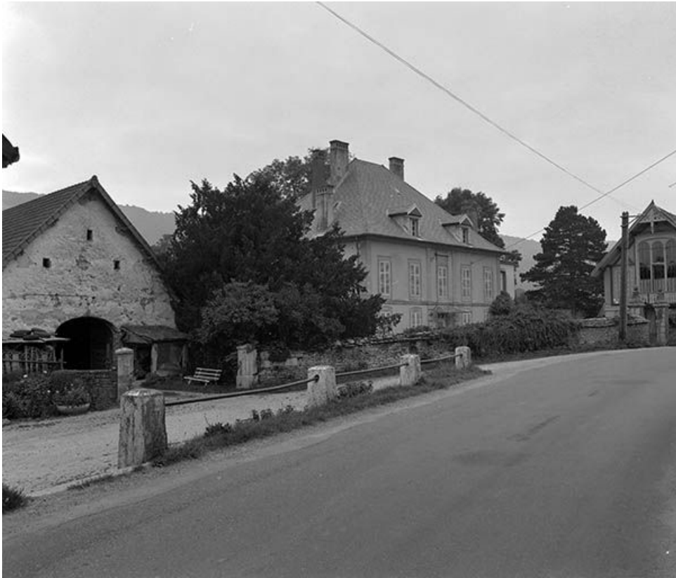
Vue d'ensemble depuis la rue. 25, Scey-Maisières
