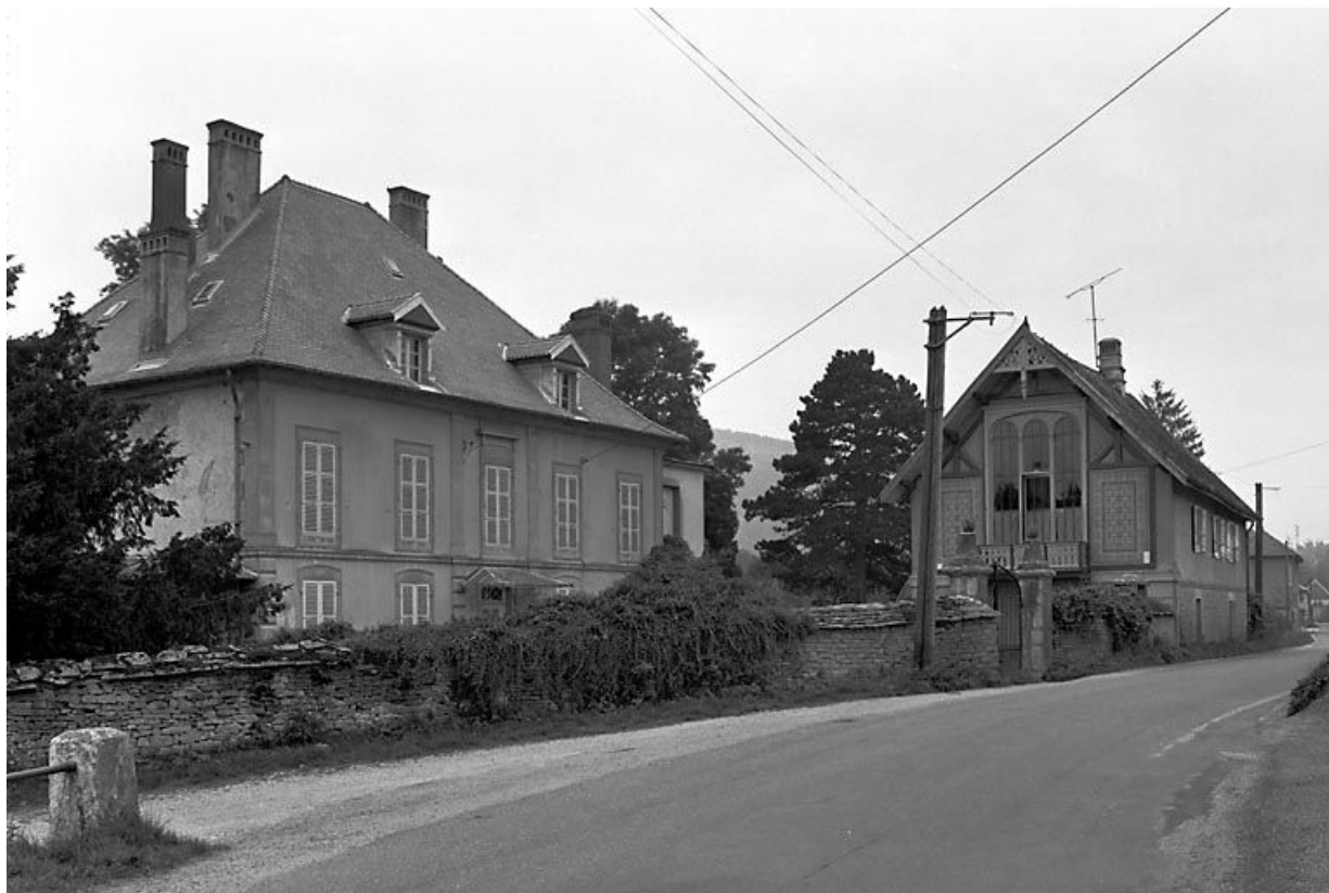
Façade antérieure vue de trois quarts gauche. 25, Scey-Maisières, lieudit : Maisières-Notre-Dame
