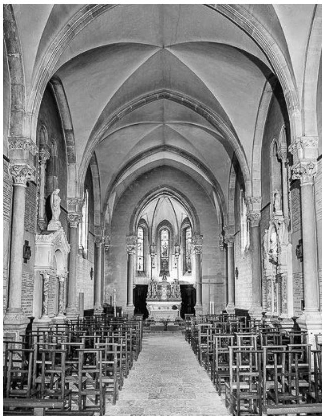
Nef vue depuis l'entrée.
