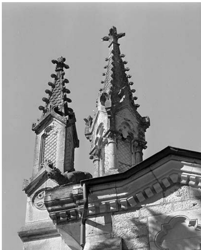
Façade antérieure, détail : les clochetons.
