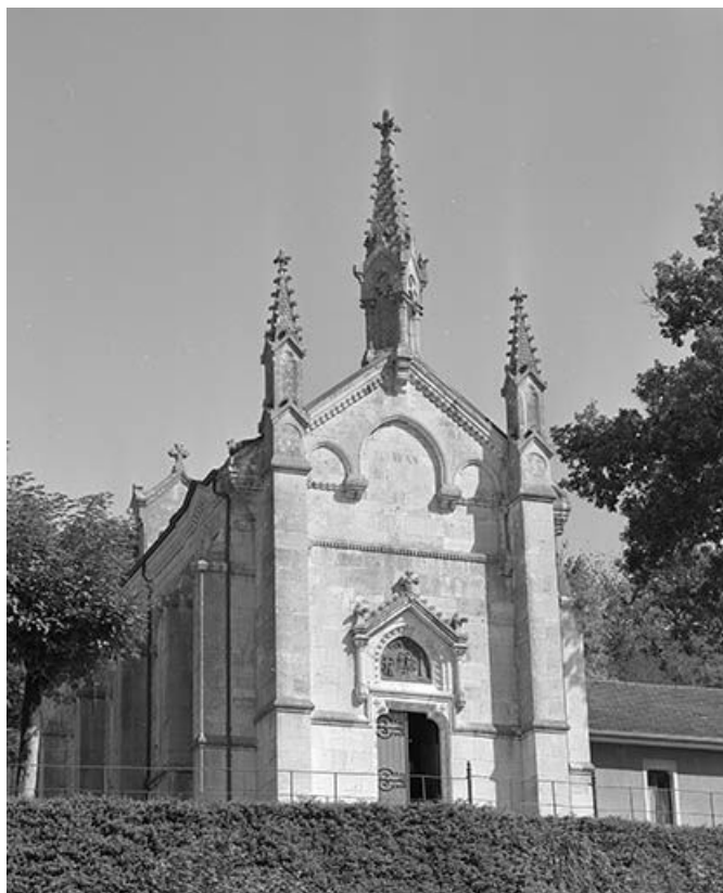
Façade antérieure vue de trois quarts gauche. 25, Scey-Maisières, lieudit : Maisières-Notre-Dame
