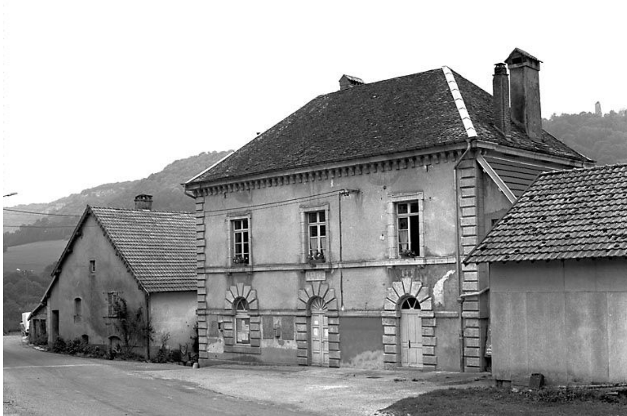
Façade antérieure. 25, Scey-Maisières
