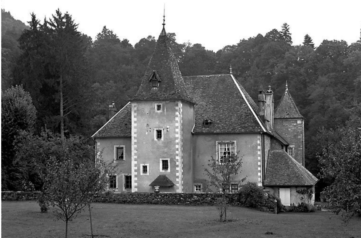
Façade antérieure. 25, Scey-Maisières
