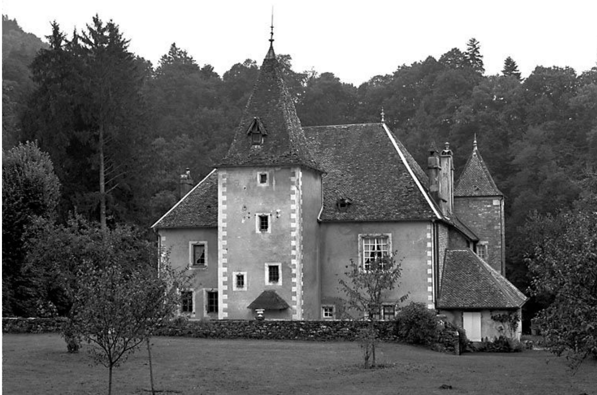
Façade antérieure. 25, Scey-Maisières
