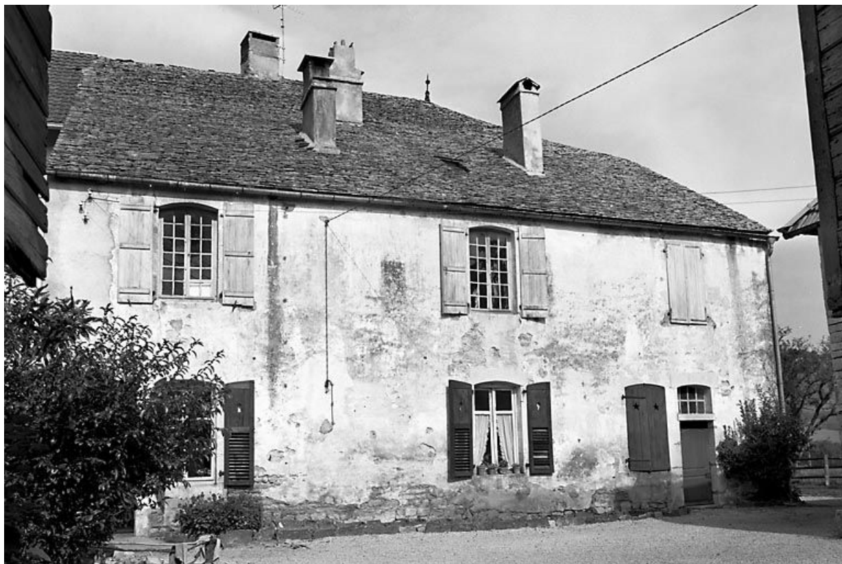
Façade antérieure. 25, Scey-Maisières
