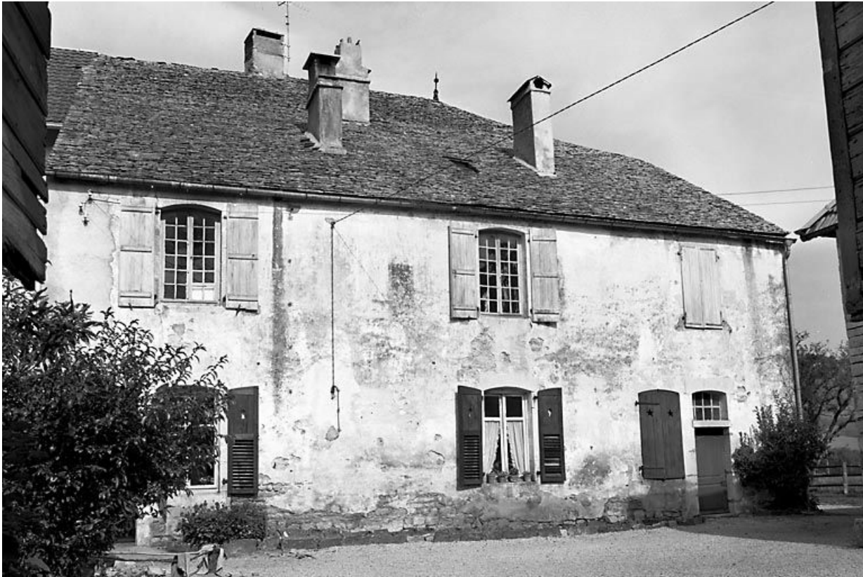
Façade antérieure. 25, Scey-Maisières
