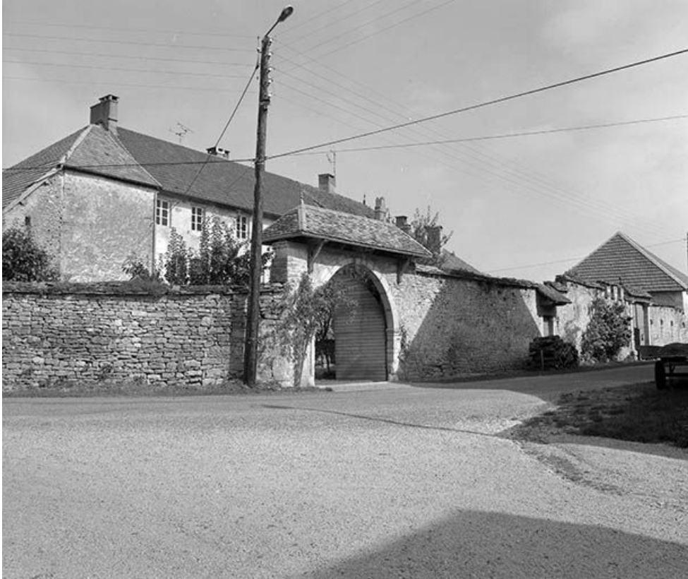
Vue d'ensemble. 25, Scey-Maisières
