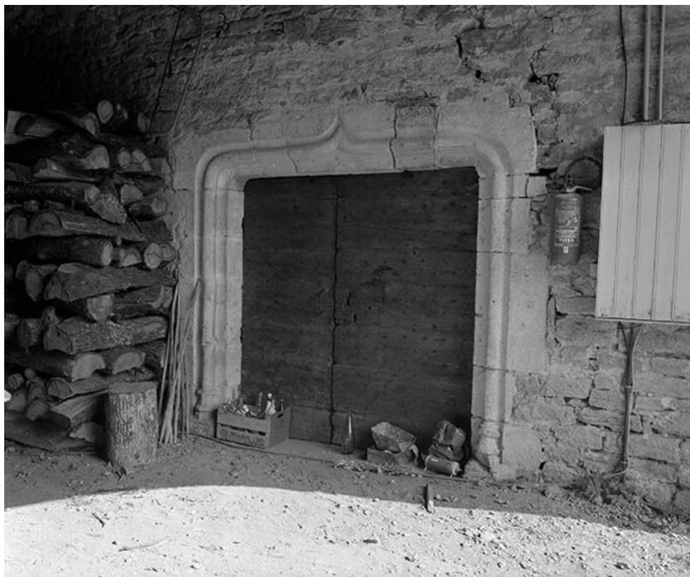
L'entrée du sous-sol sous le passage voûté.
