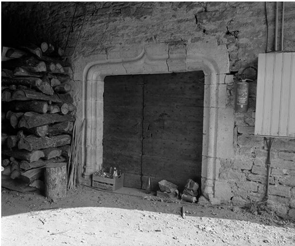
L'entrée du sous-sol sous le passage voûté.
