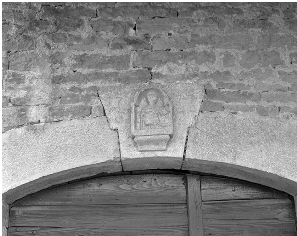
Façade antérieure : linteau de la porte conduisant à l'écurie.
