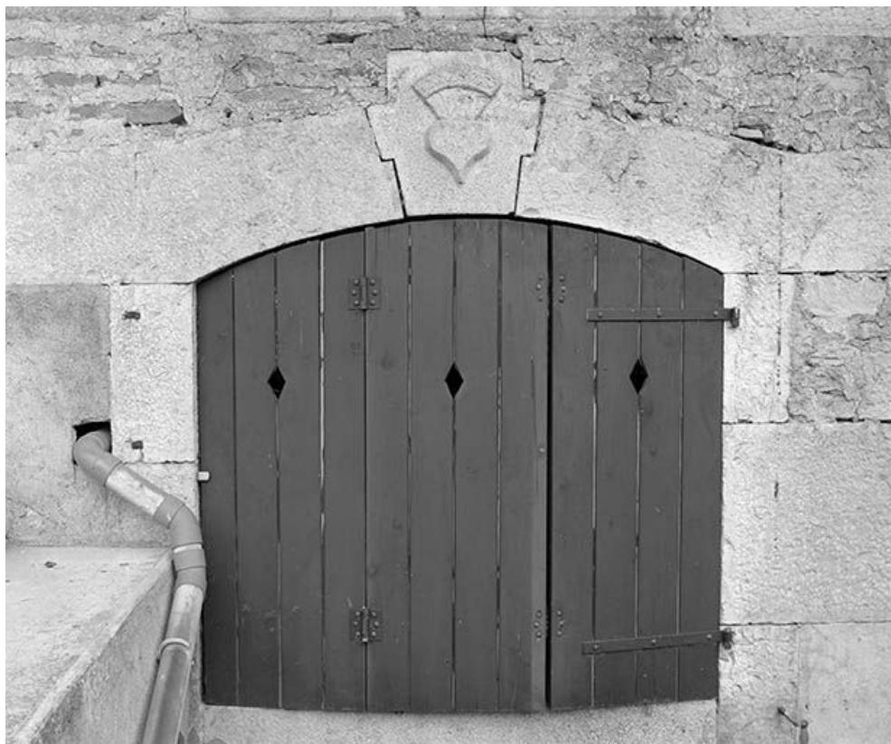
Façade antérieure, détail : linteau de la baie éclairant le sous-sol.
