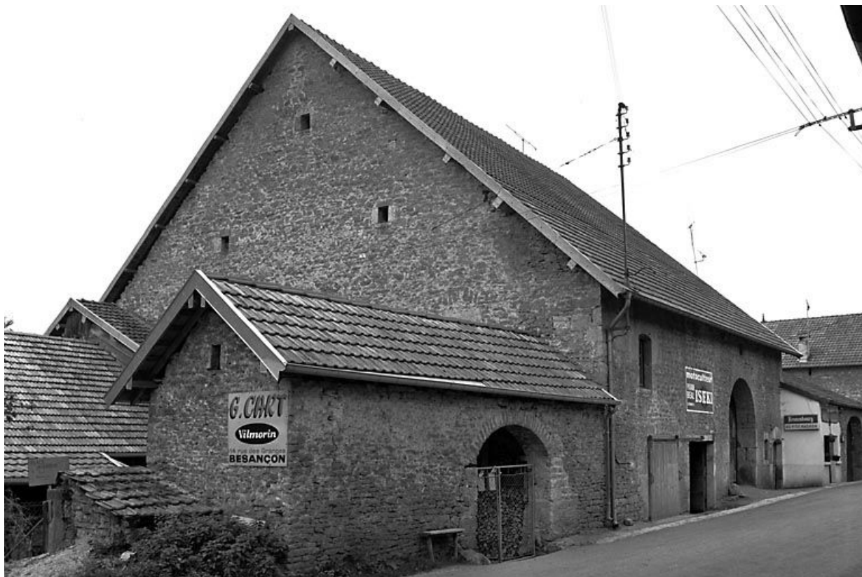
Façade antérieure vue de trois quarts gauche. 25, Scey-Maisières
