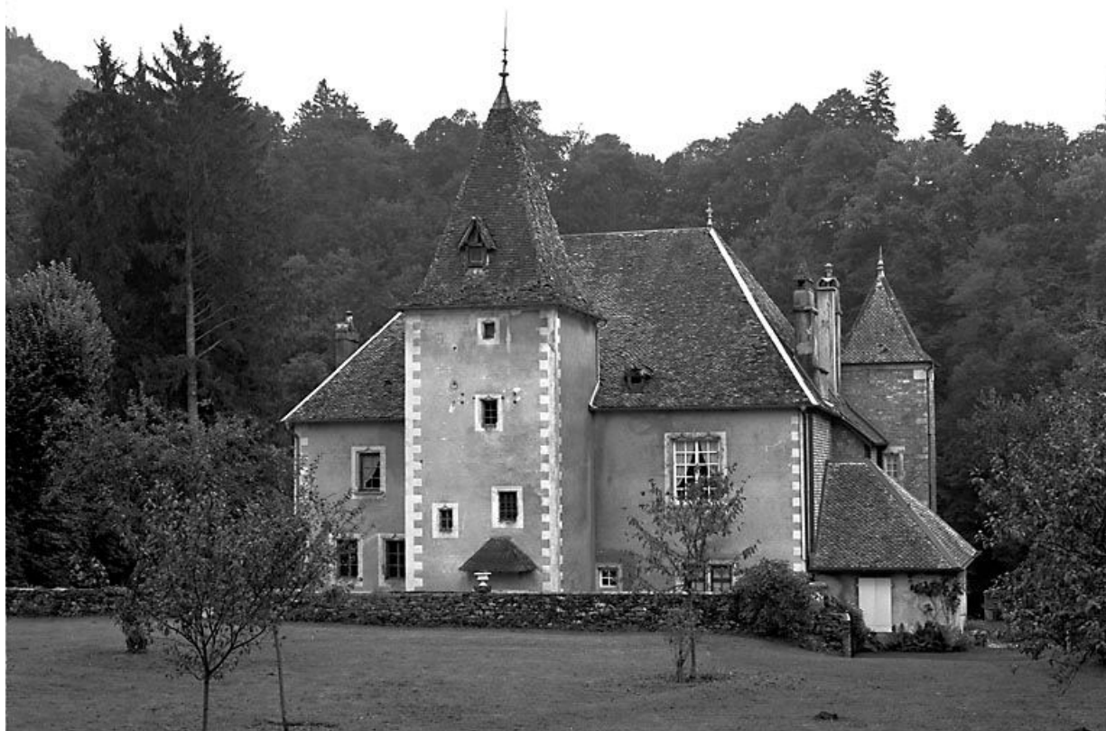
Façade antérieure. 25, Scey-Maisières
