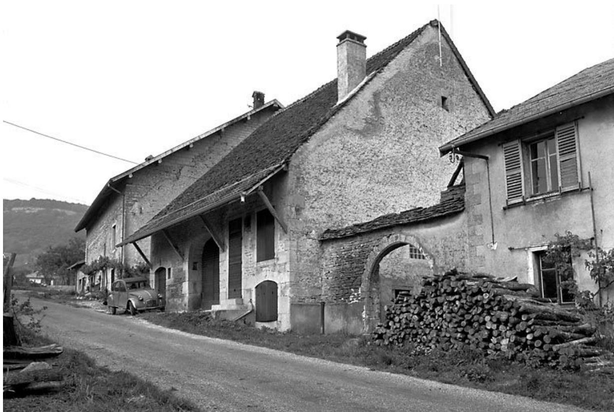
Façade antérieure vue de trois quart droit. 25, Scey-Maisières
