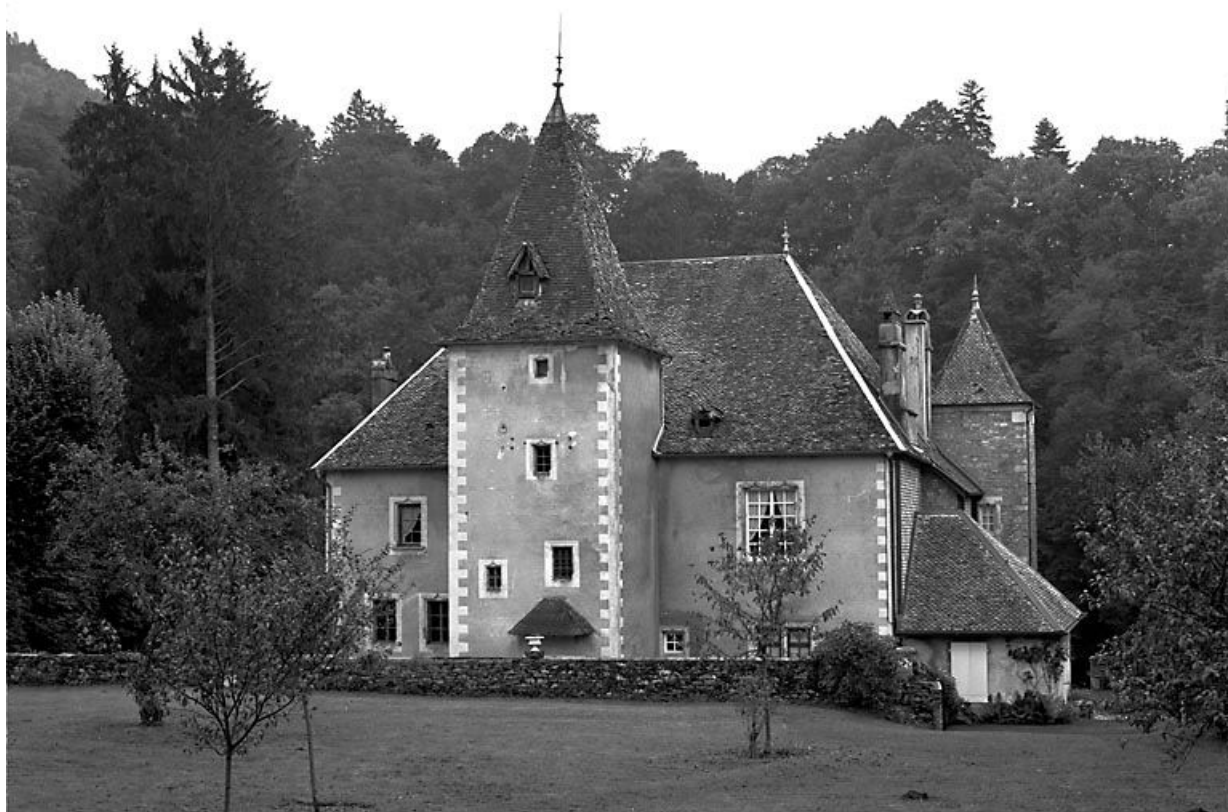
Façade antérieure. 25, Scey-Maisières
