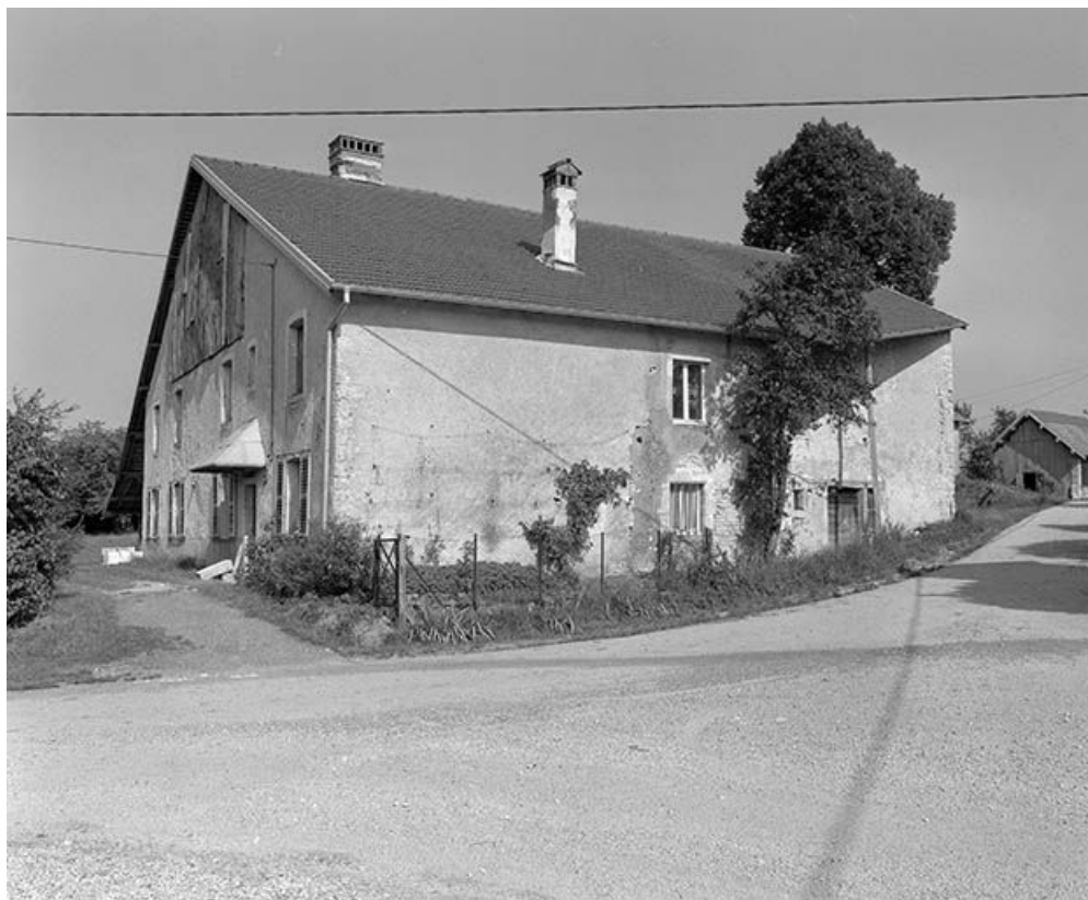
Façade antérieure et face latérale droite.
