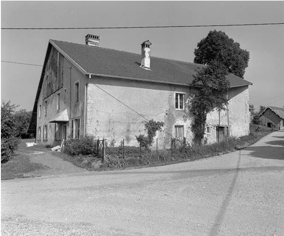
Façade antérieure et face latérale droite.
