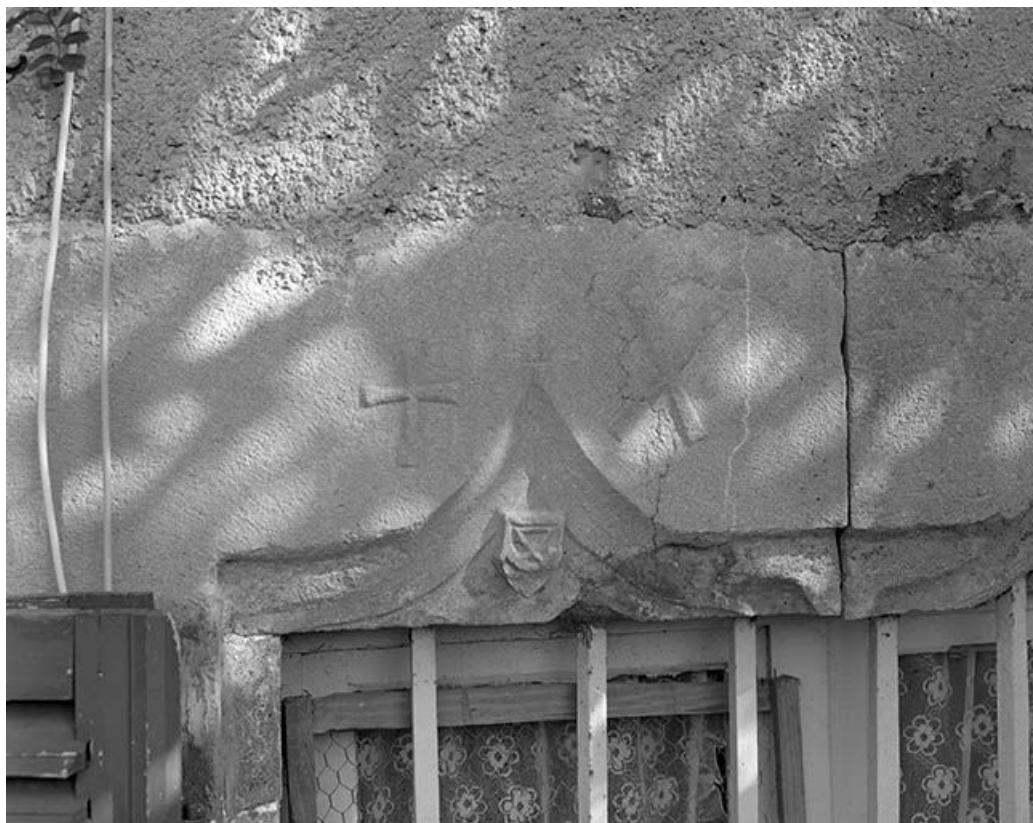
Façade postérieure : linteau de la baie du rez-de-chaussée.
