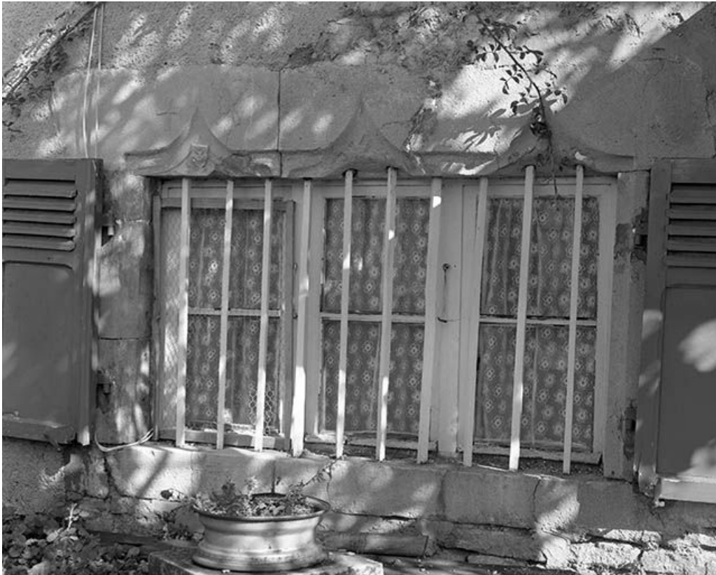
Façade postérieure : baie du rez-de-chaussée. 25, Saules Grande Rue
