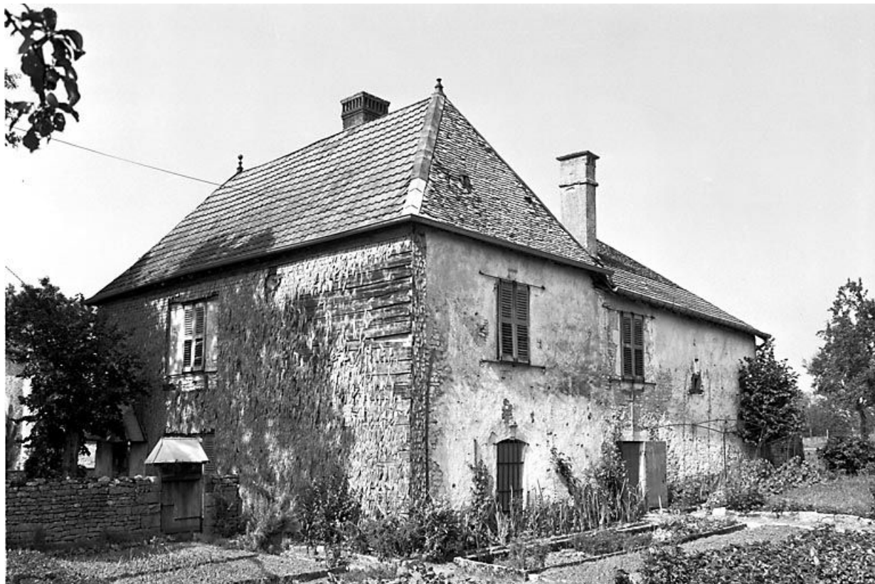
Façade antérieure et face latérale droite. 25, Saules
