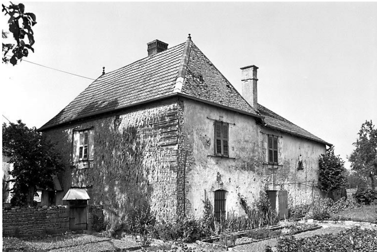
Façade antérieure et face latérale droite. 25, Saules
