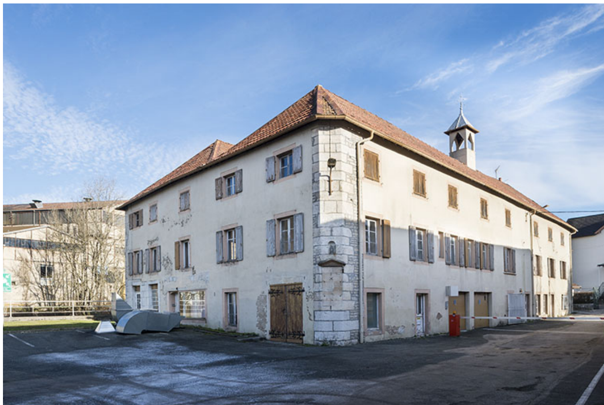
Bâtiment du moulin. Vue de trois quarts depuis l'ouest.
