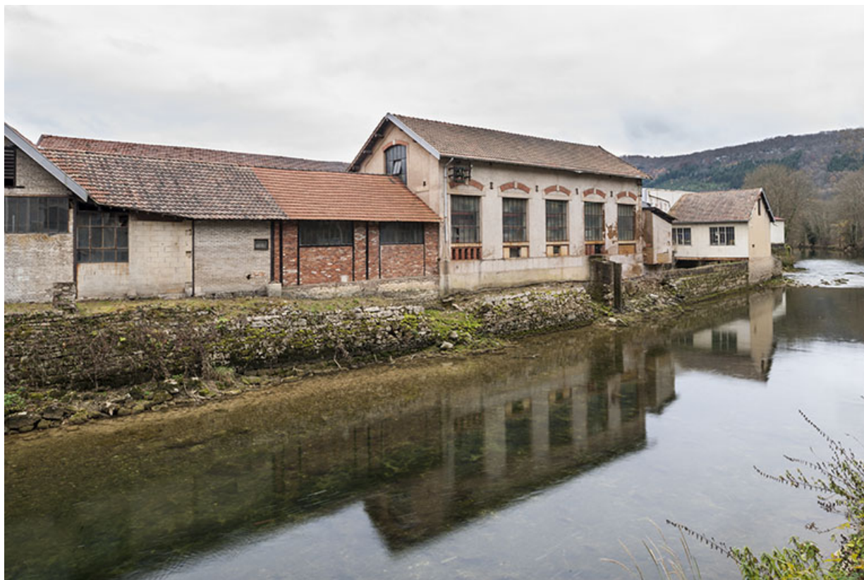
Atelier, bâtiment d'eau et conciergerie sur la Loue.
