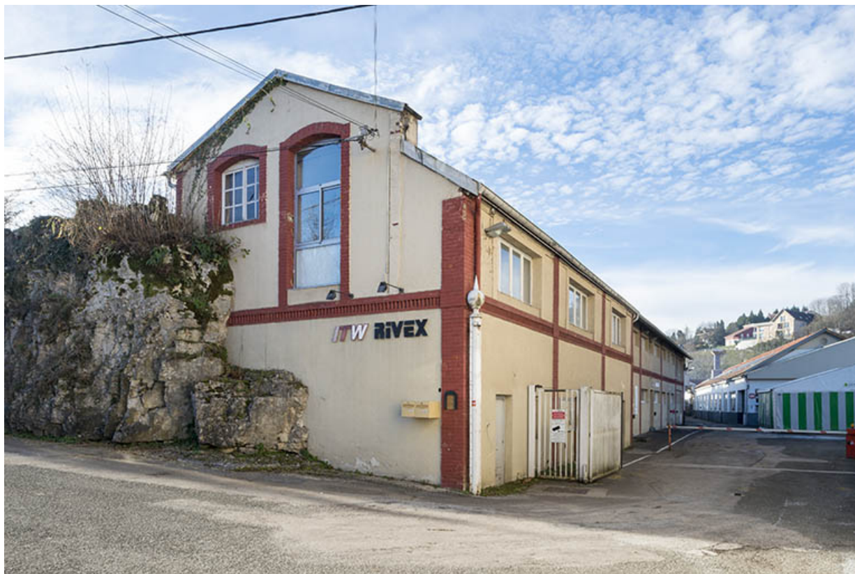
Bâtiment d'accueil de l'ancienne entrée (bureaux).
