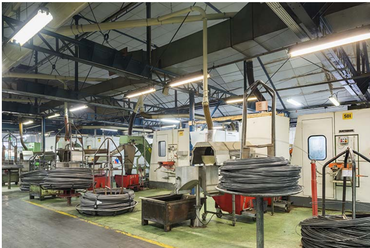
Atelier de fabrication (début 20e siècle) et sa charpente métallique.
