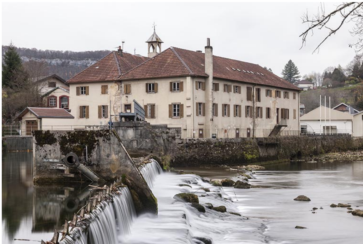
Le bâtiment du moulin depuis la rive droite du barrage.
