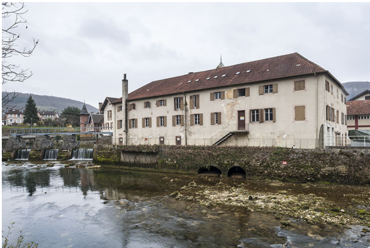
Façade nord du bâtiment du moulin.
