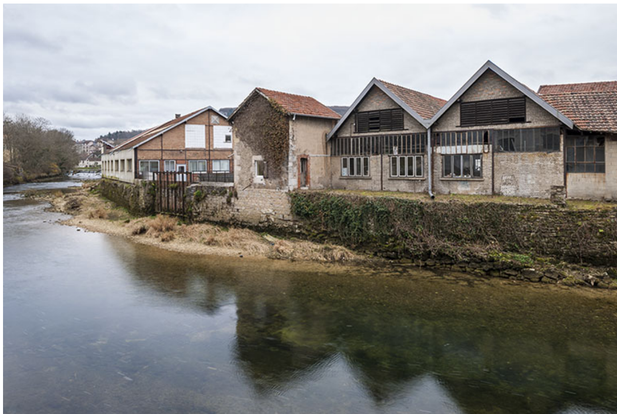
Ateliers et conciergerie bordant la Loue à l'ouest.
