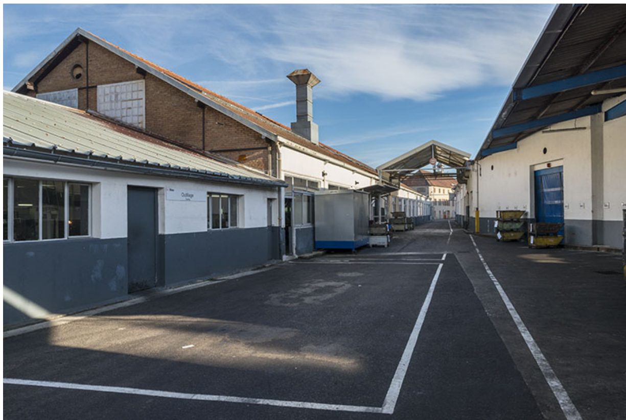
Atelier de fabrication et passage couvert, depuis l'ouest.
