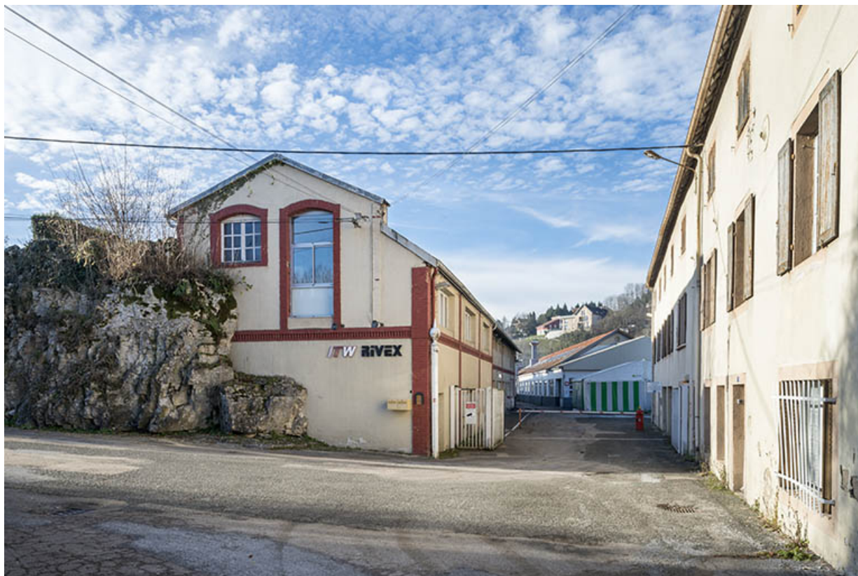
Vue d'ensemble depuis l'ancienne entrée (à l'est).
