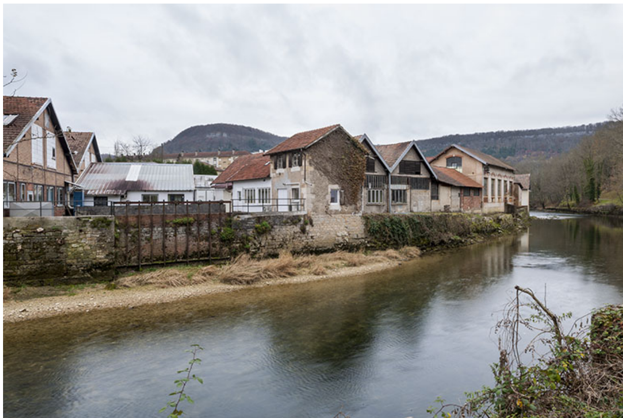
Conciergerie et ateliers de la pointe ouest de l'usine.
