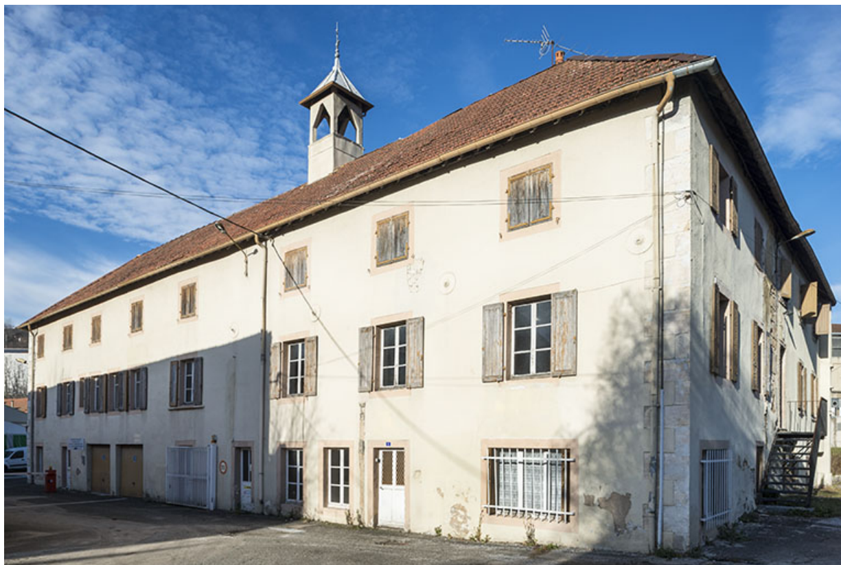
Bâtiment du moulin. Vue de trois quarts depuis l'entrée.
