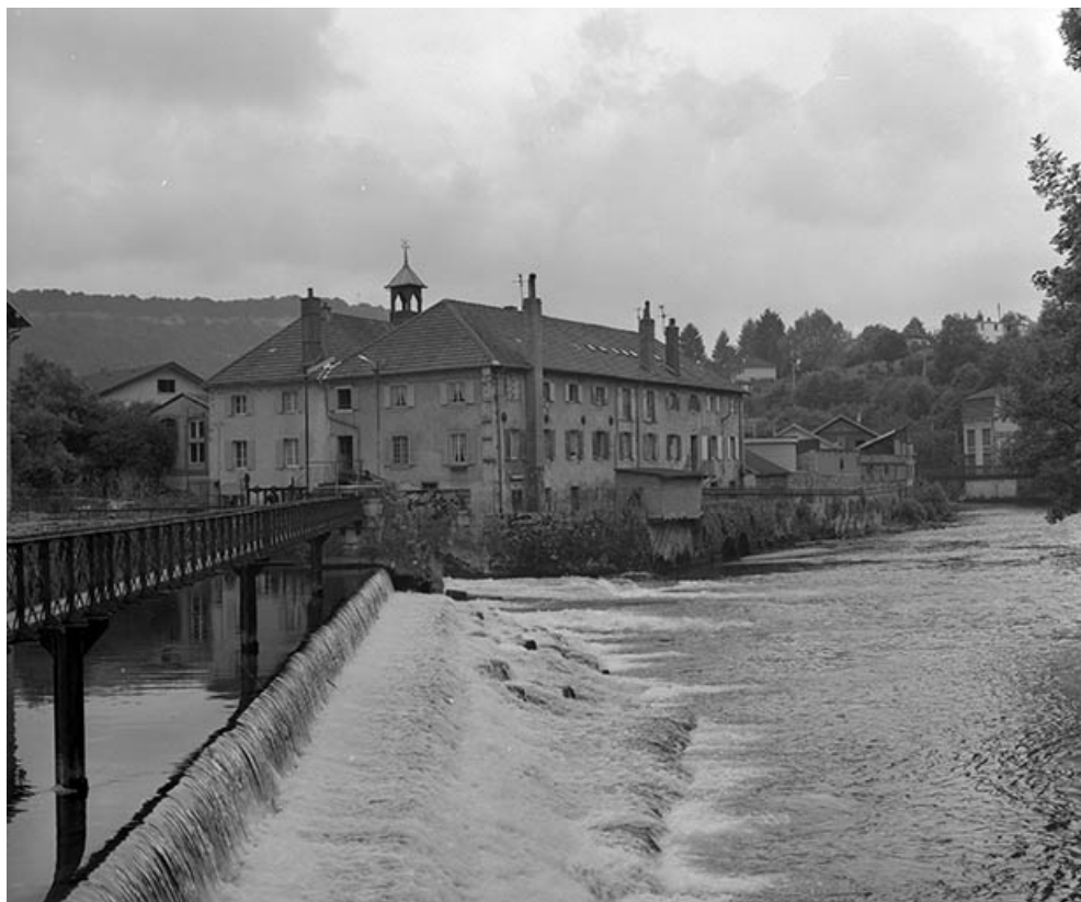
Vue d'ensemble rapprochée côté Loue.
