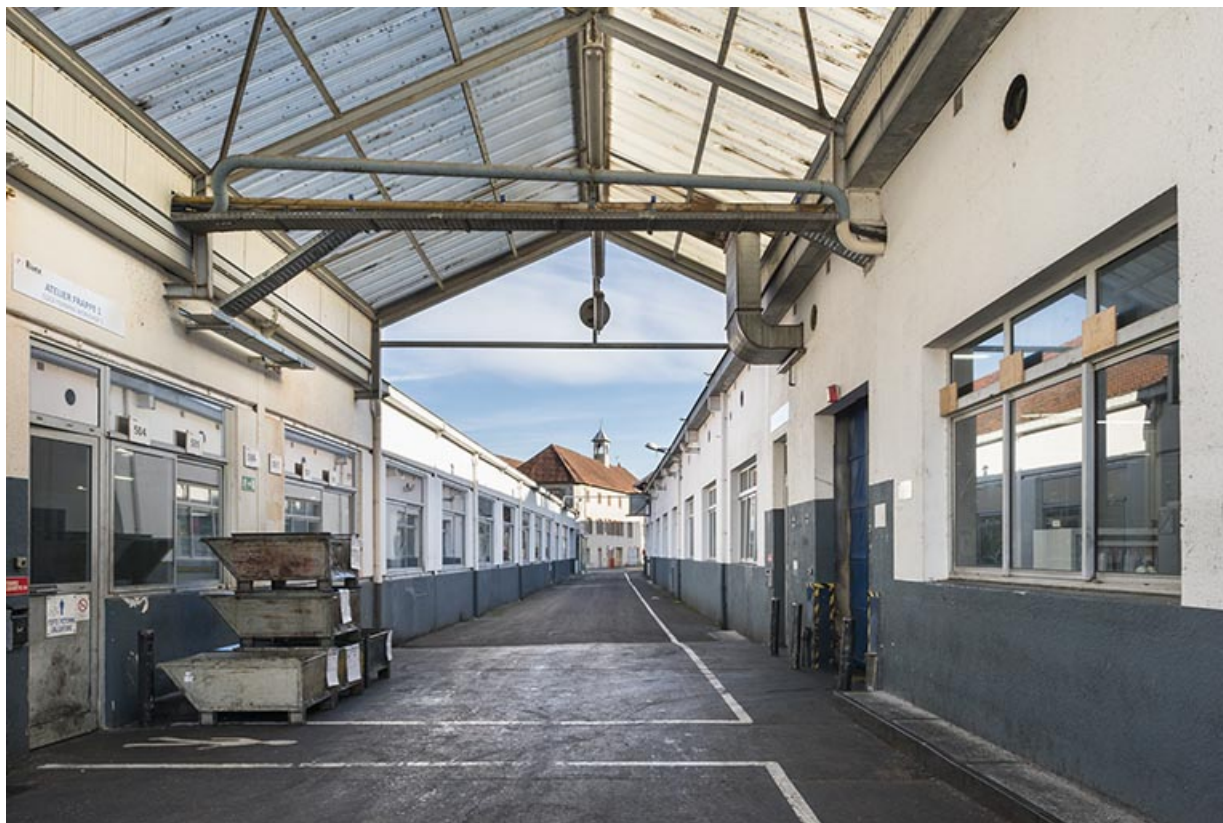
Passage couvert entre deux ateliers.
