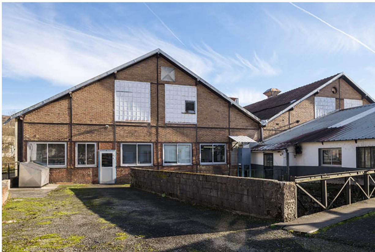
Pignon des ateliers de fabrication le long de la Loue. 25, Ornans route des Usines du Bas
