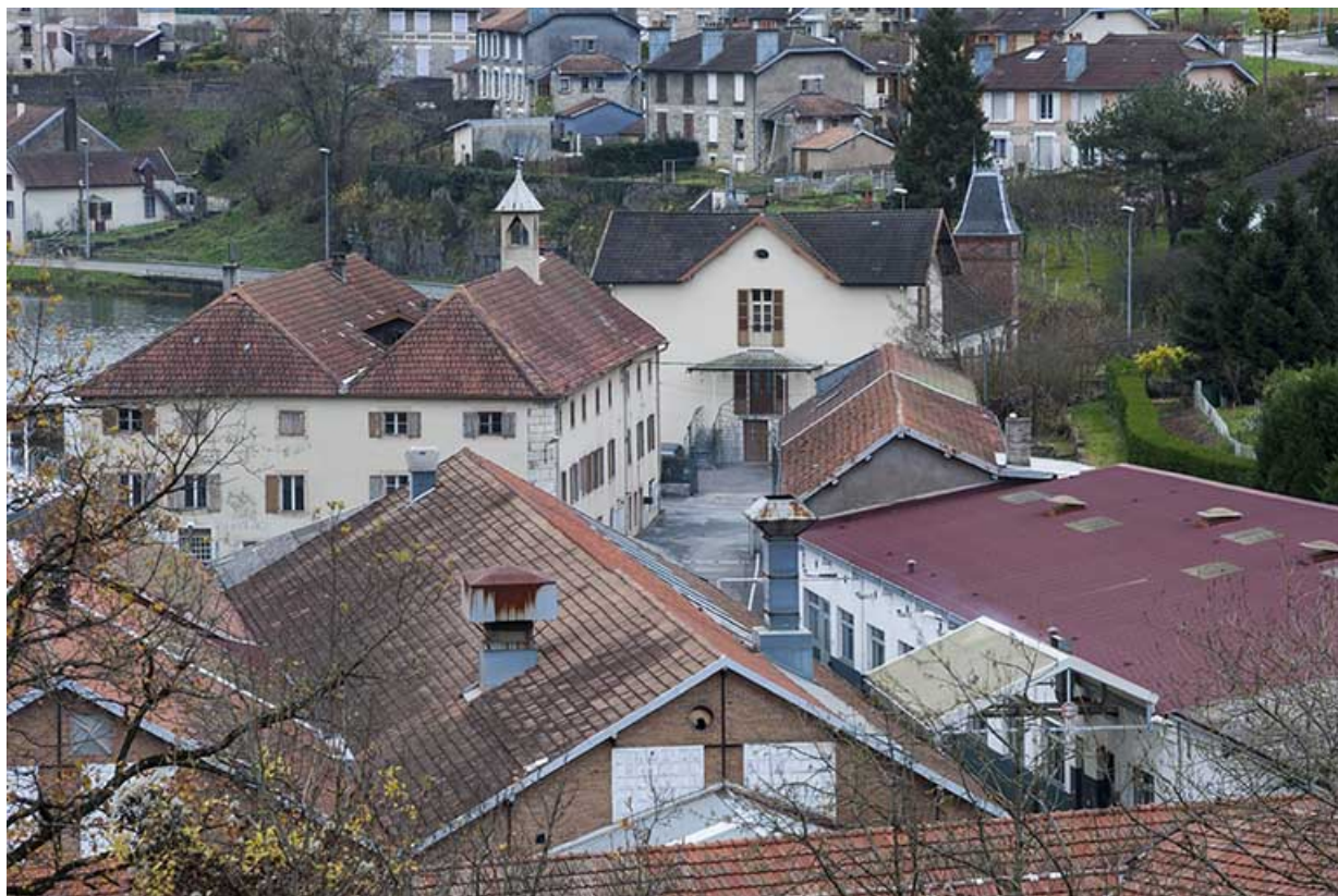
Vue plongeants sur les bâtiments orientaux de l'usine.
