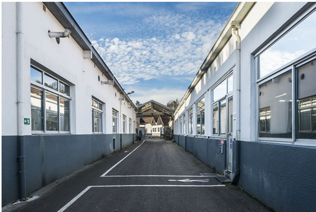
Passage entre deux ateliers. Vue depuis l'ouest.
