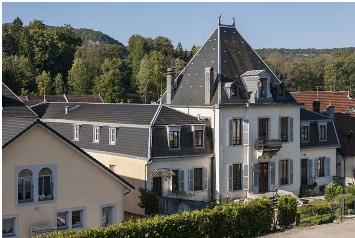
Logement patronal vu de trois quarts arrière. 25, Ornans, 9, 11 rue Eugène Cusenier
