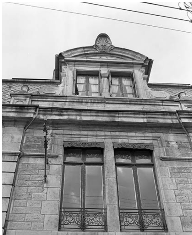
Façade antérieure, détail de la travée centrale.
