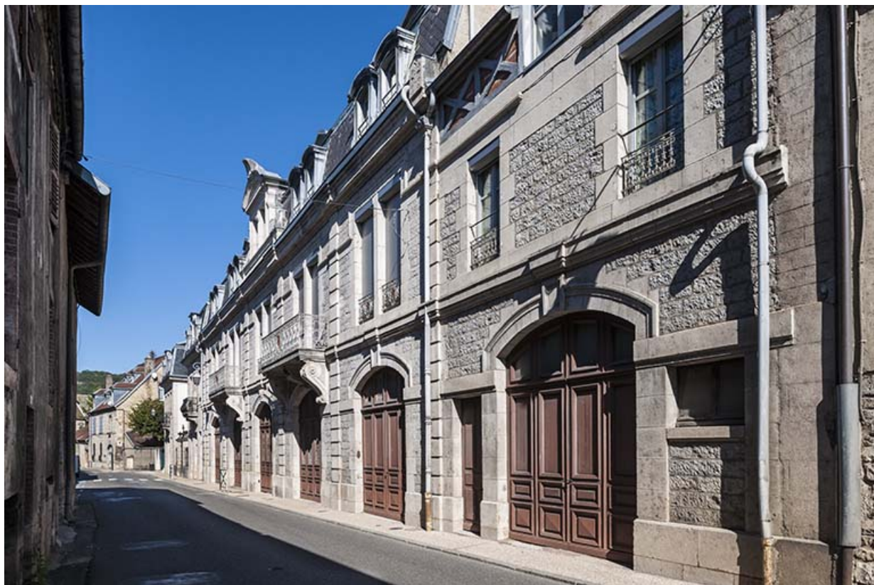
Atelier de fabrication sur la rue Cusenier. Vue de trois quarts droite.
