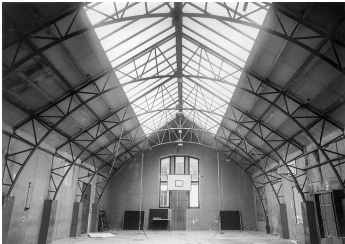
Etage de l'atelier de distillation, dit le laboratoire, en 2000.
