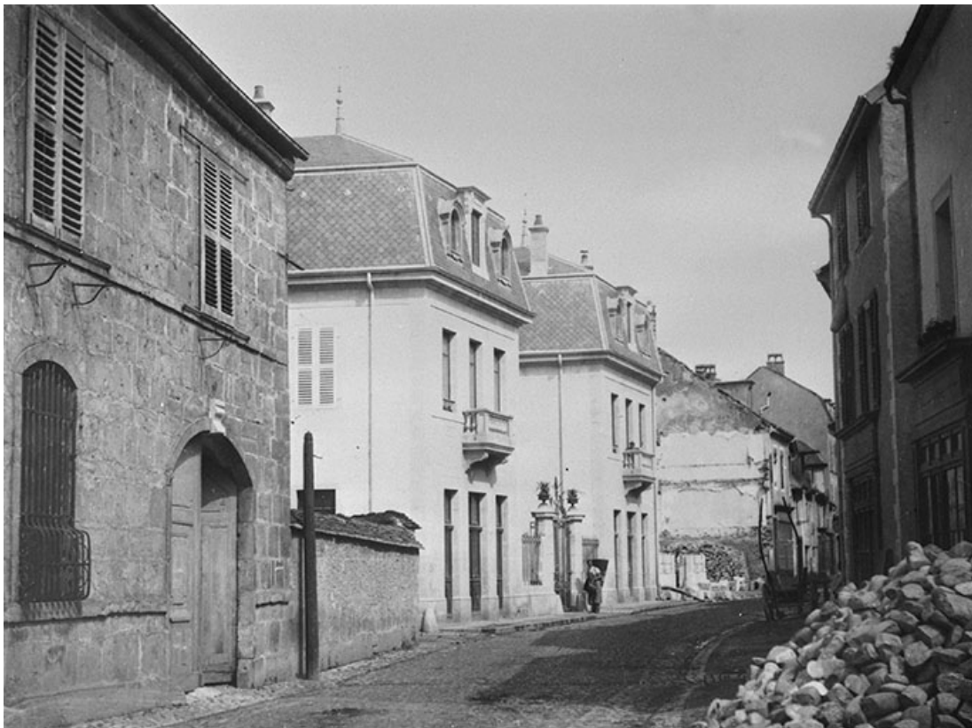
Façade antérieure du logement patronal, vers 1880.
