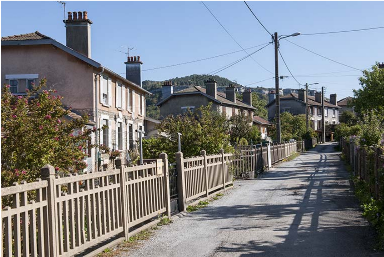
Alignement de maisons à quatre logements. 25, Ornans allée des Cités jardins Oerlikon
