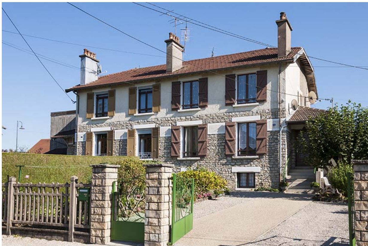
Façade antérieure d'une habitation à quatre logements.
