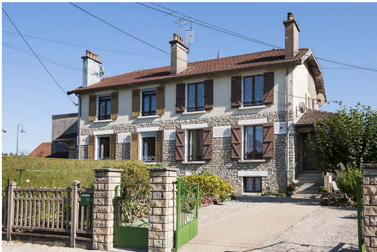
Façade antérieure d'une habitation à quatre logements.
