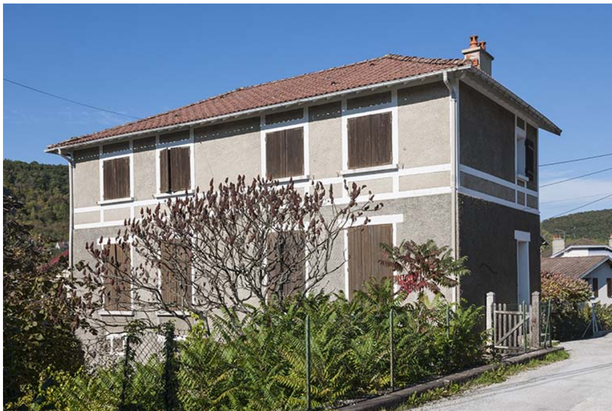
Façade postérieure d'une maison de célibataires.
