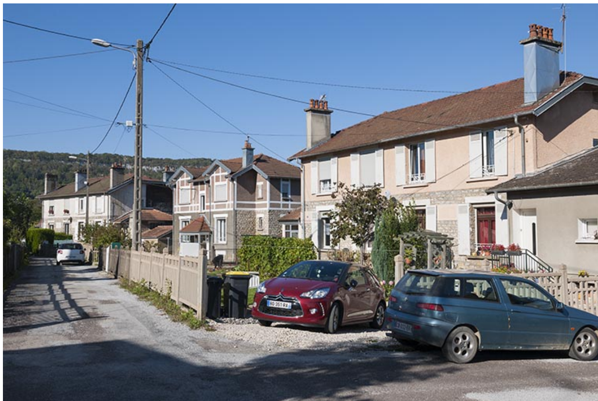
Maison de célibataires entre deux maisons à quatre logements.
