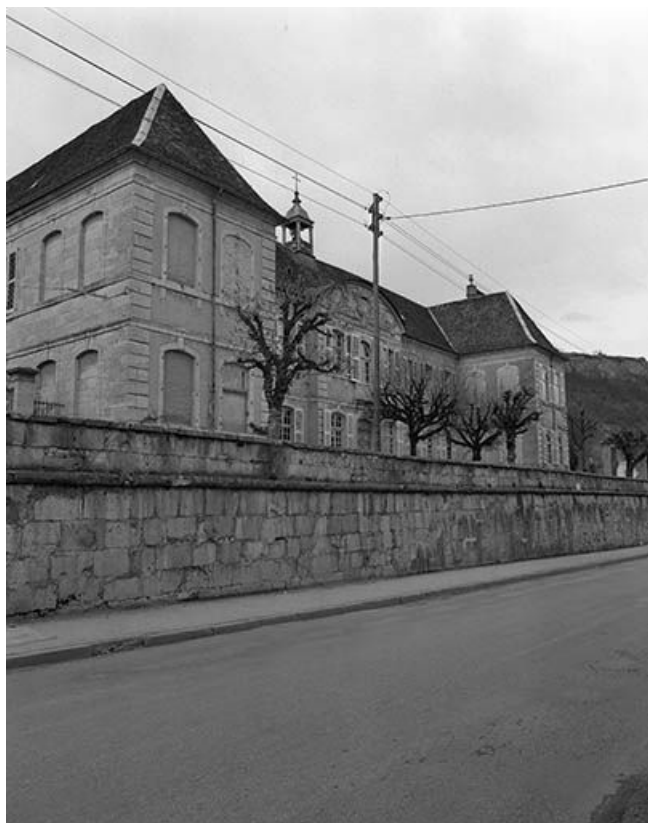
Façade antérieure de trois quarts gauche. 25, Ornans, 10 avenue du Président Wilson
