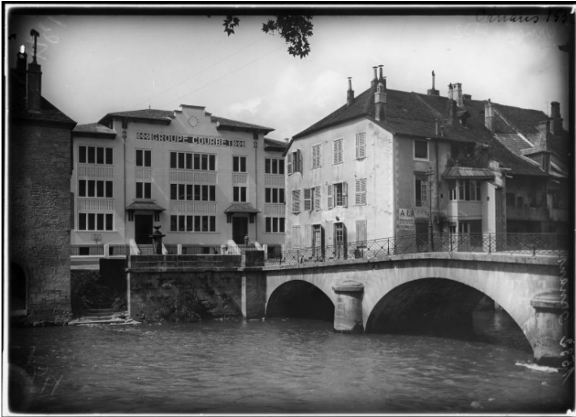
Vue de situation [1re moitié 20e siècle]. 25, Ornans, 1 rue Saint-Laurent
