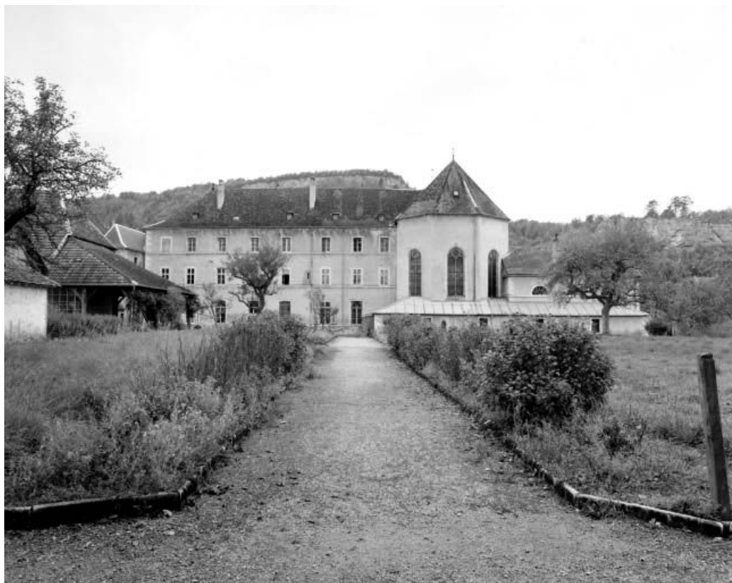
Vue générale depuis le nord.
