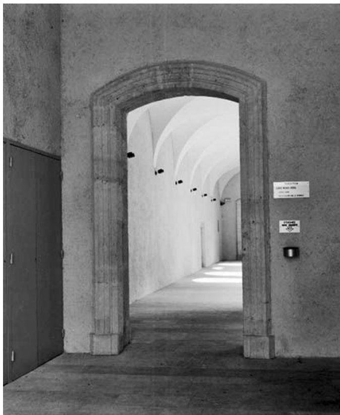
Intérieur : porte conduisant au cloître.
