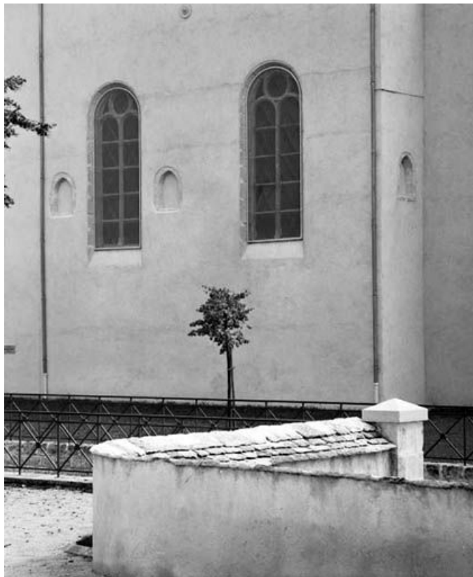
Façade latérale gauche de la chapelle : baies mises à jour lors de la rénovation de 1981-1983. 25, Ornans, 7 rue Edouard Bastide
