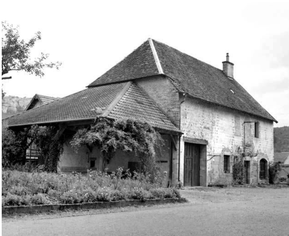
L'ancienne hôtellerie et le préau vus de trois quart gauche.
