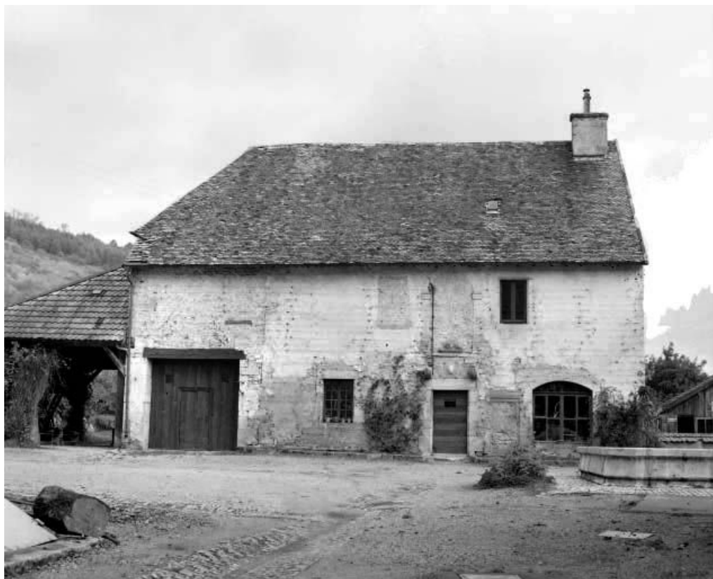
Façade antérieure de l'ancienne hôtellerie.
