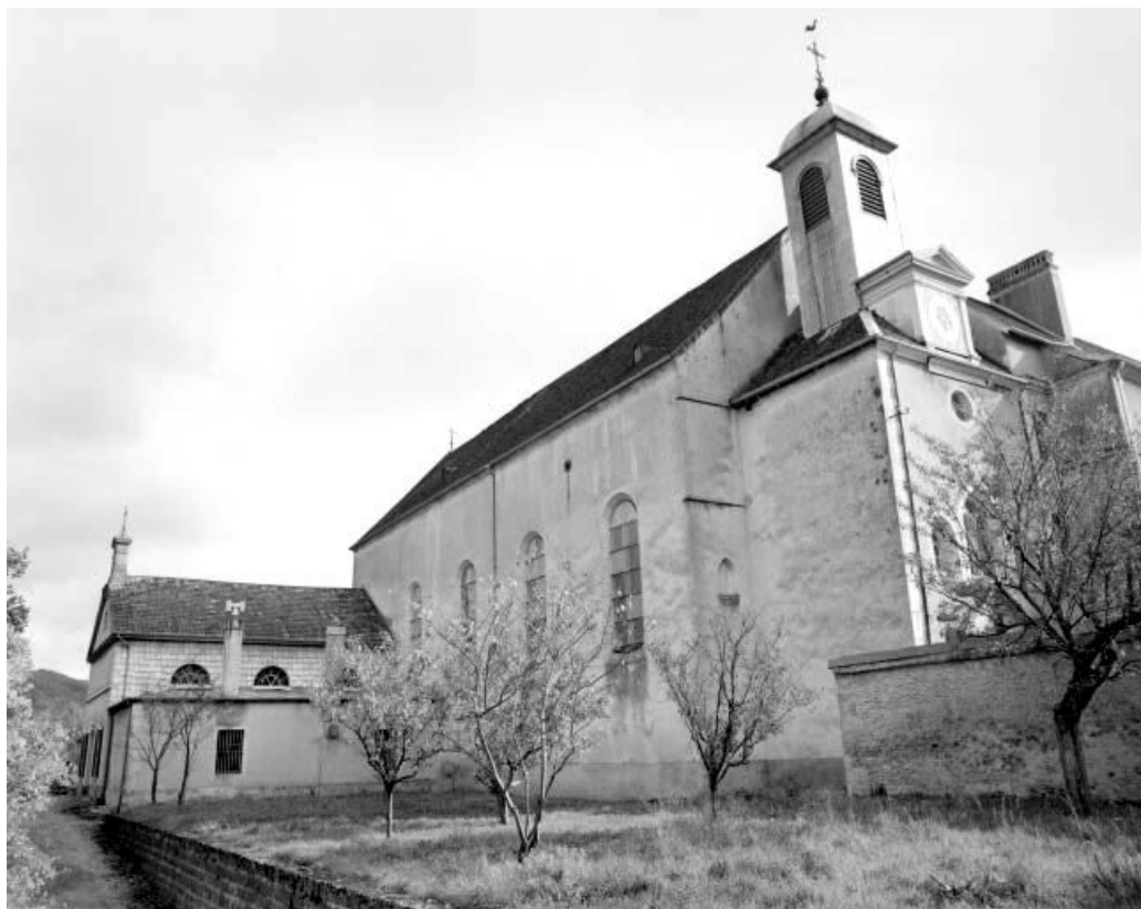
Façade latérale gauche de la chapelle.
