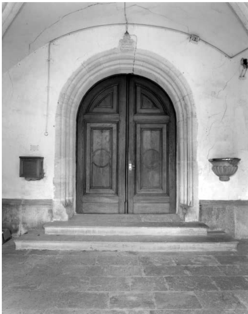
Intérieur : entrée de la chapelle. 25, Ornans, 7 rue Edouard Bastide
