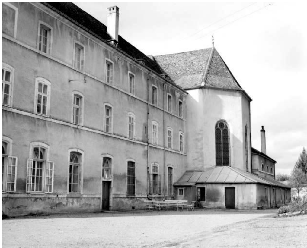
Façade postérieure du couvent, le chevet et le passage conduisant au chœur des religieuses. 25, Ornans, 7 rue Edouard Bastide
