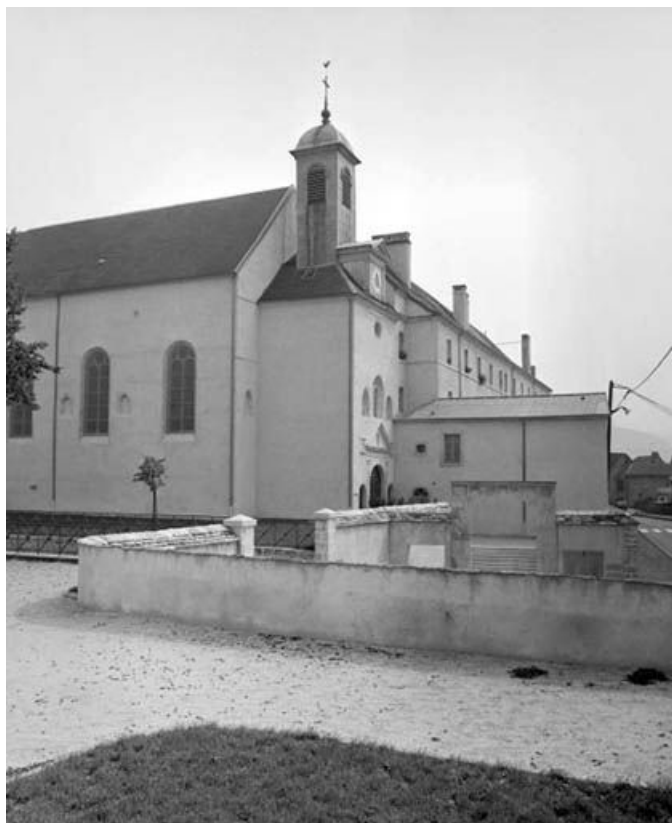
Façade antérieure et façade latérale gauche de la chapelle après la rénovation de 1981-1983. 25, Ornans, 7 rue Edouard Bastide
