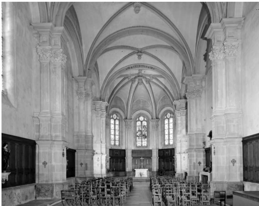
Intérieur : la nef et le chœur.
