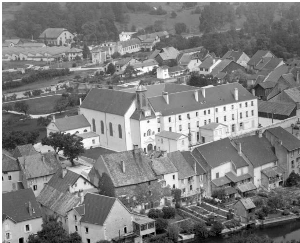
Vue générale après la rénovation de 1981-1983.
