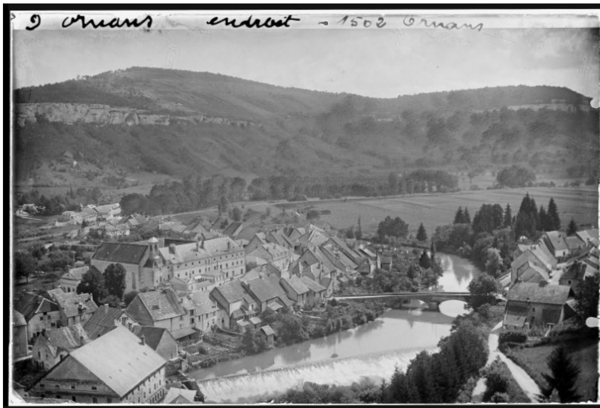
Vue de situation [1re moitié 20e siècle]. 25, Ornans, 7 rue Edouard Bastide
