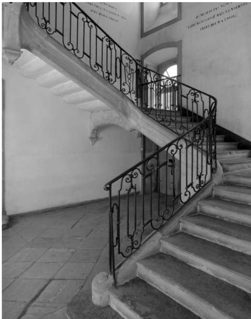
Intérieur : escalier conduisant aux cellules des religieuses.
