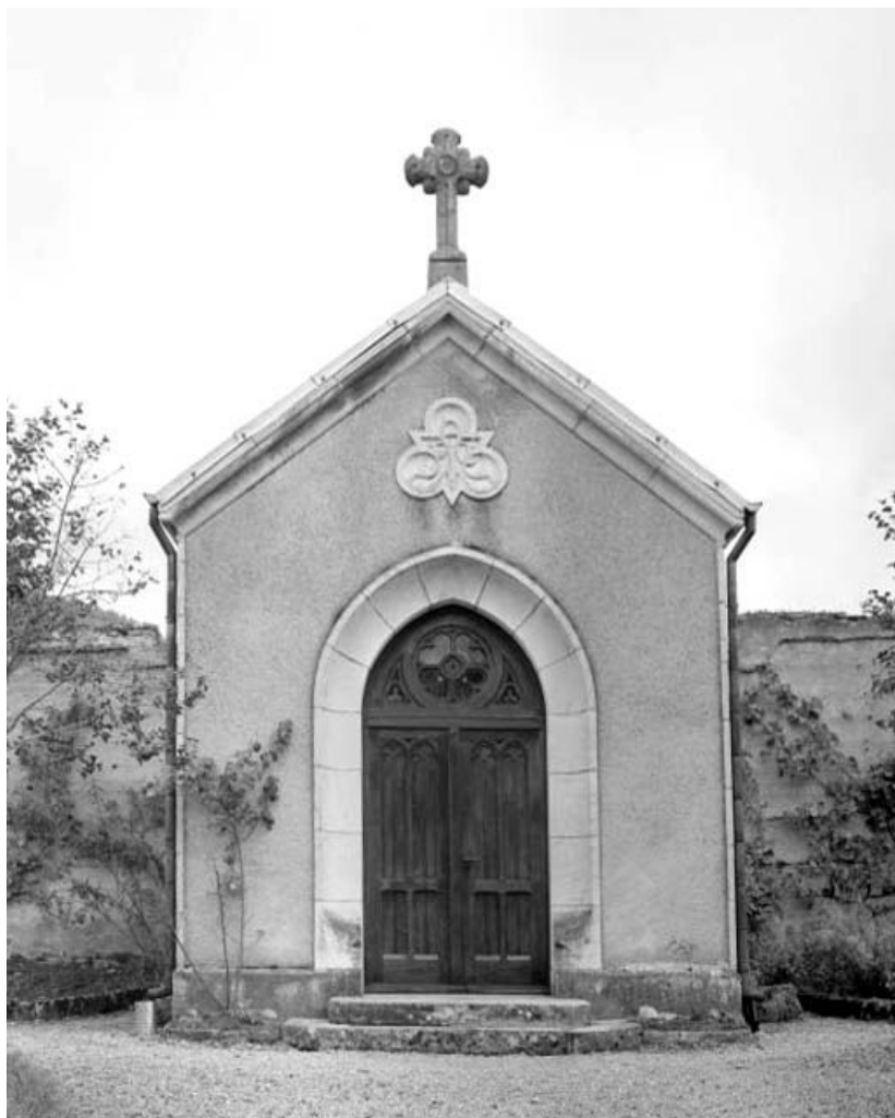
Chapelle adossée au mur d'enclos nord.
