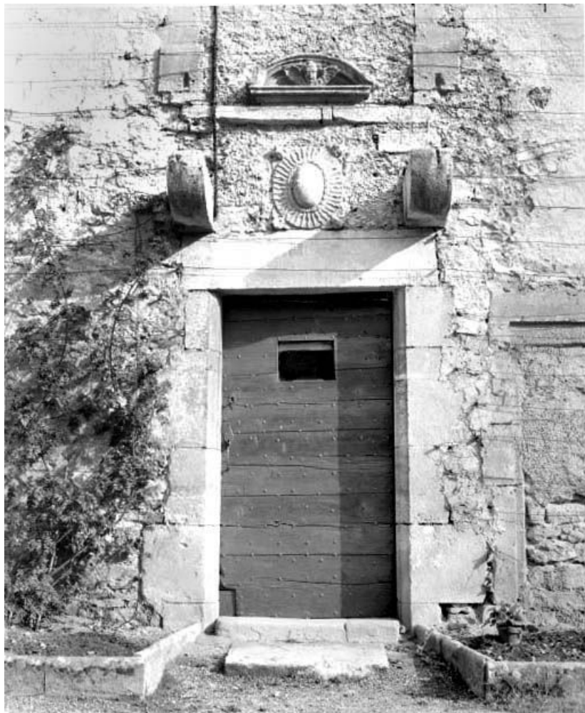
La porte d'entrée de l'ancienne hôtellerie. 25, Ornans, 7 rue Edouard Bastide
