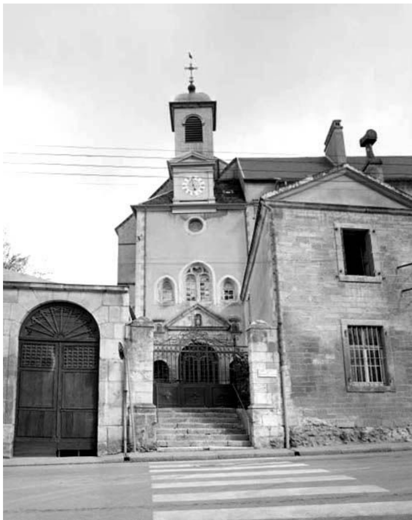
Façade antérieure de la chapelle.
