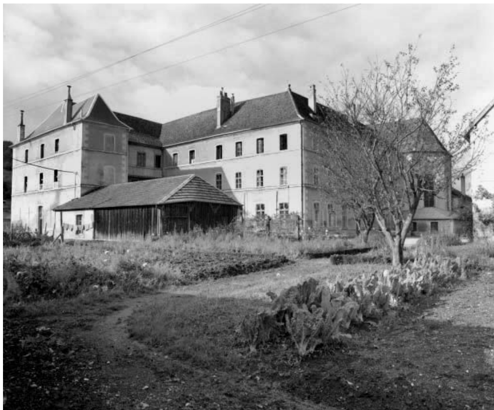
Vue d'ensemble des bâtiments depuis l'angle nord-est.
