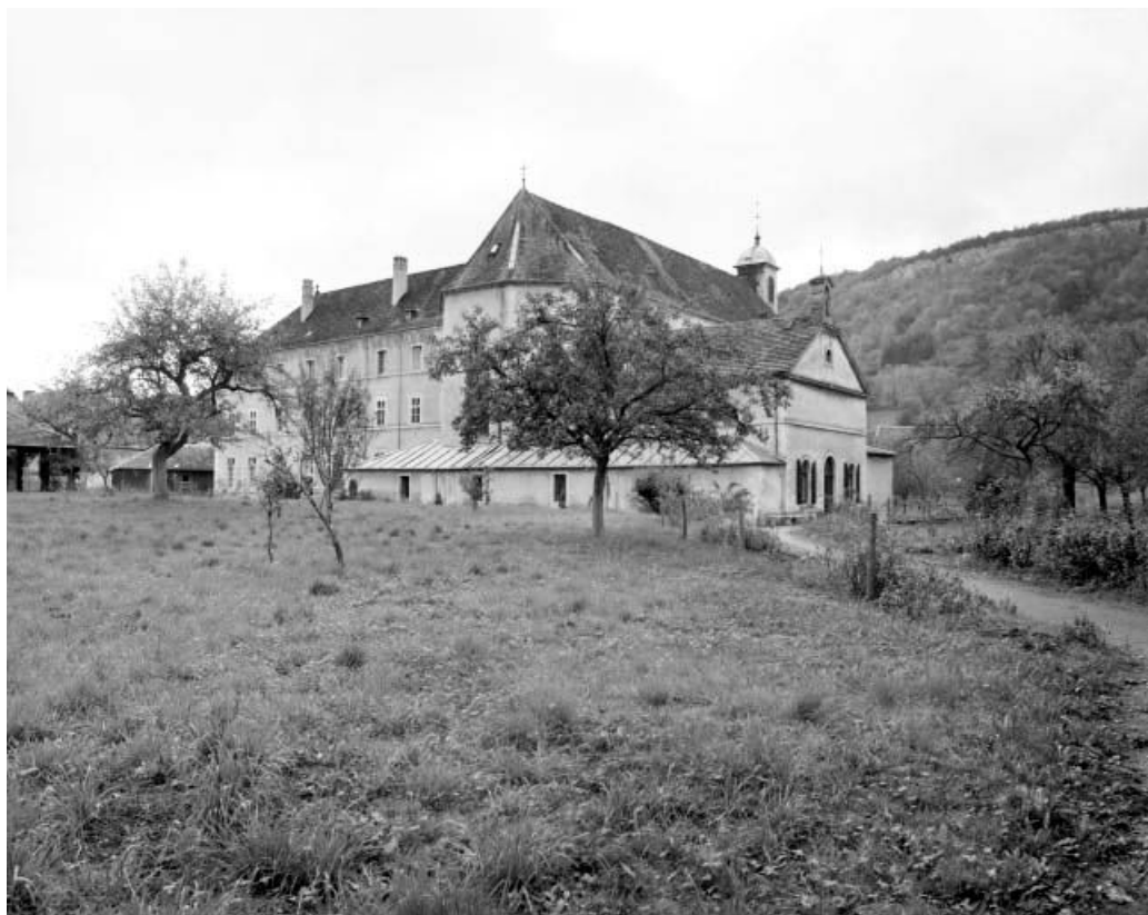
Vue générale depuis le verger, angle nord-ouest.
