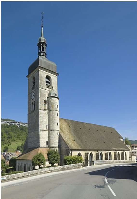
Vue de la tour-clocher.
