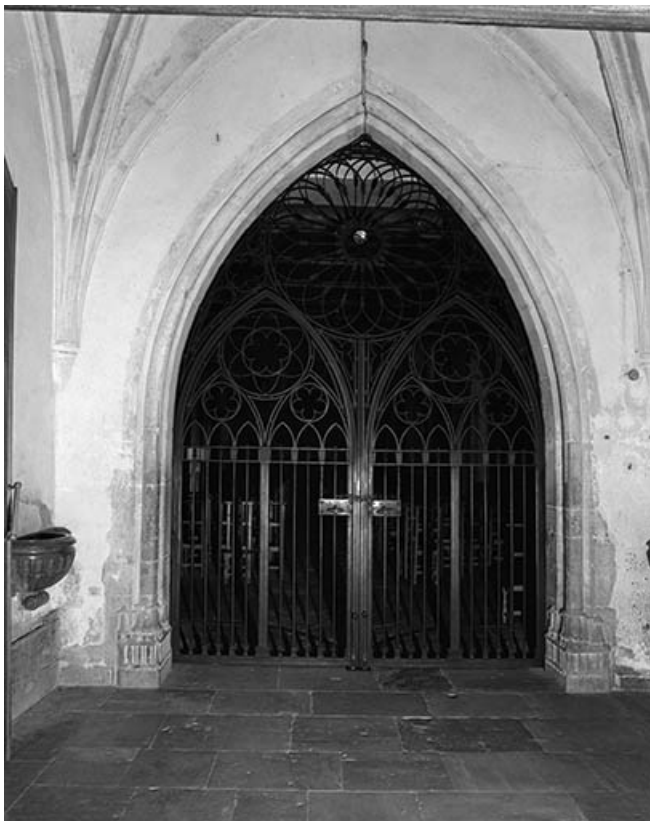
Intérieur : vue d'ensemble de la grille fermant la nef.
