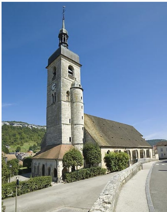
Vue de la tour clocher.
