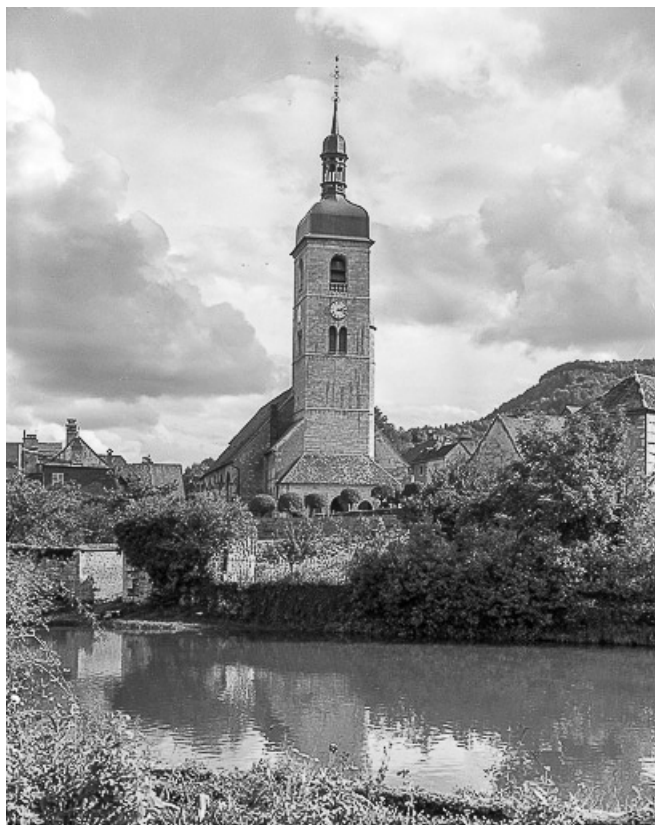
Vue générale depuis la rive droite de la Loue. 25, Ornans rue Saint-Laurent
