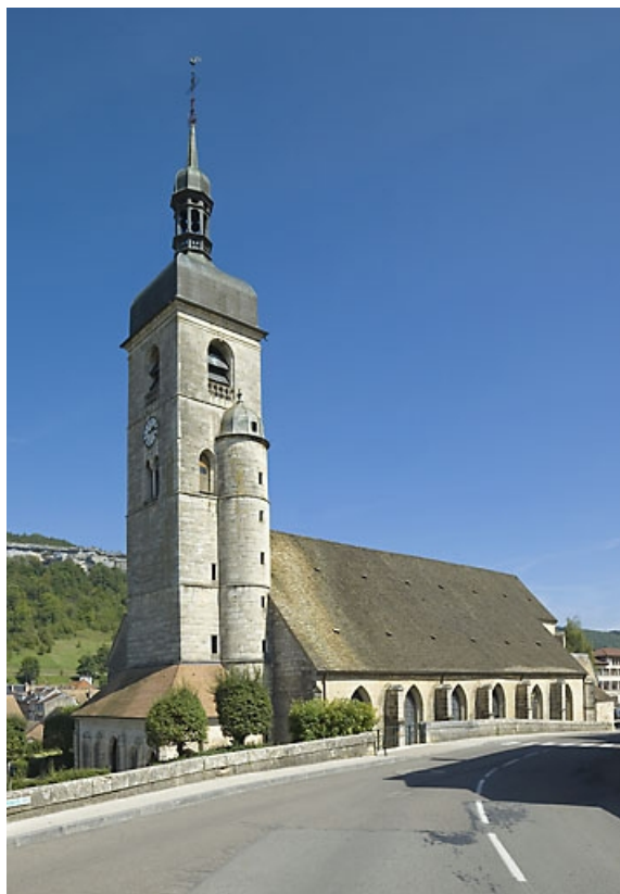
Vue de la tour-clocher.
