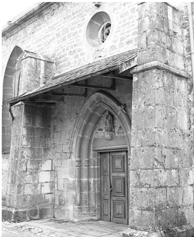
Face latérale gauche, porte et oculus, vus de trois quarts gauche. 25, Ornans rue Saint-Laurent
