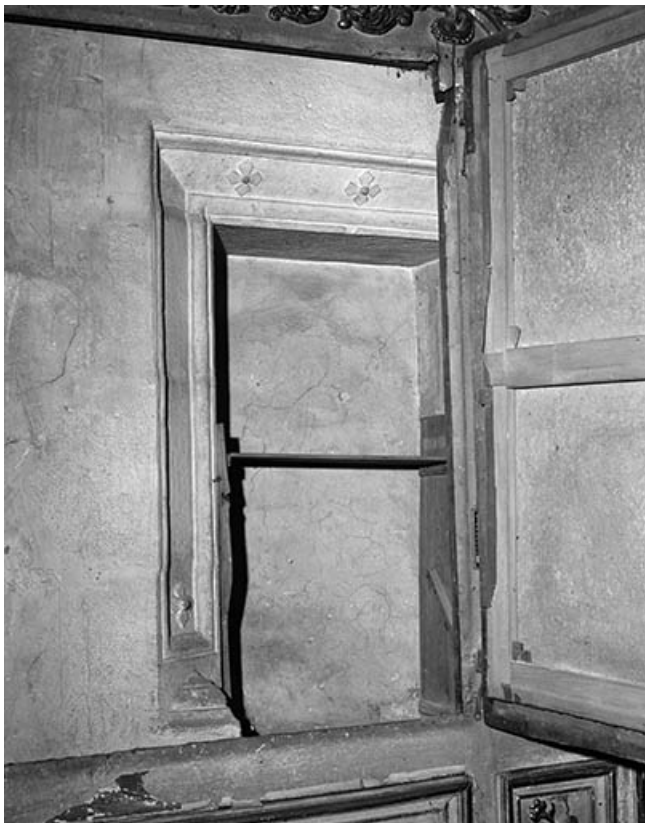
Intérieur, détail : niche du choeur.
