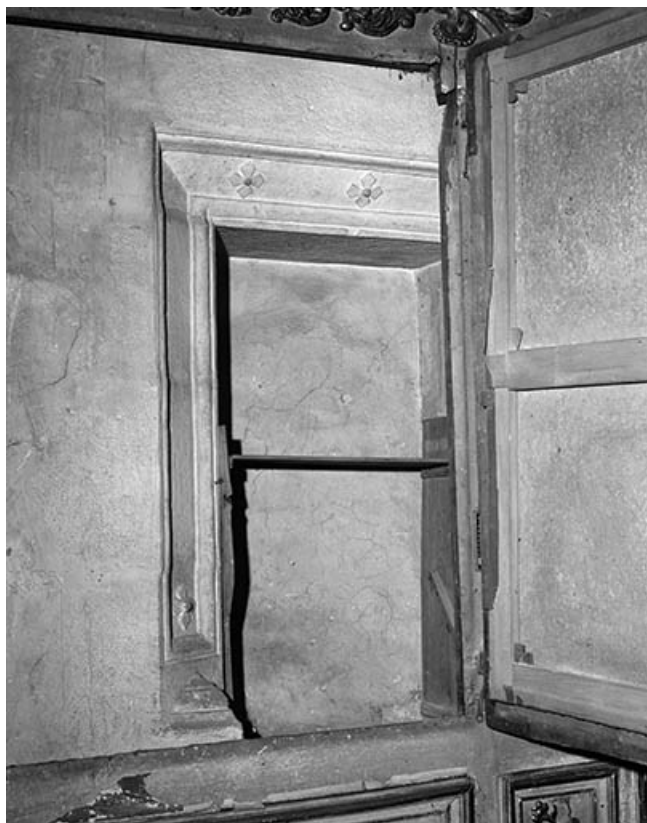
Intérieur, détail : niche du choeur.
