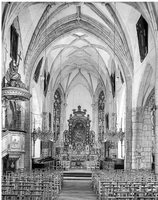
Intérieur : le chœur vu depuis la nef.
