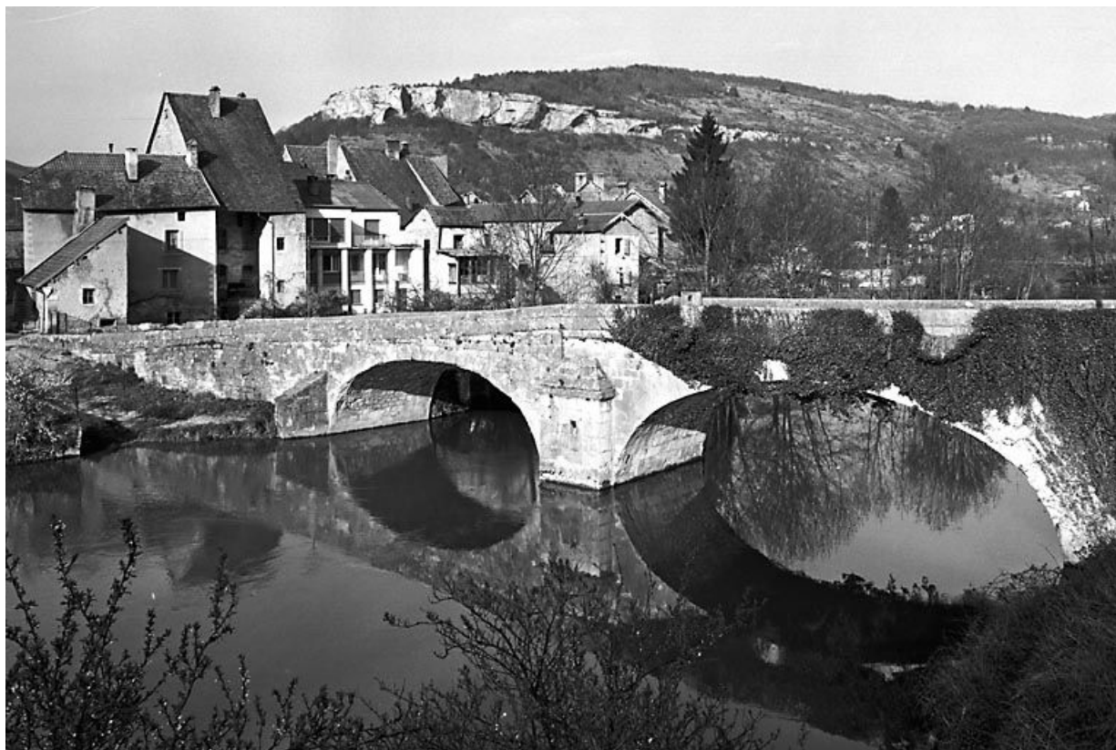
Vue générale de trois quarts depuis la rive gauche. 25, Ornans
