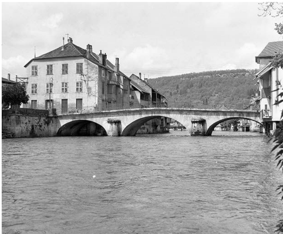
Vue de trois quarts depuis la rive droite. 25, Ornans
