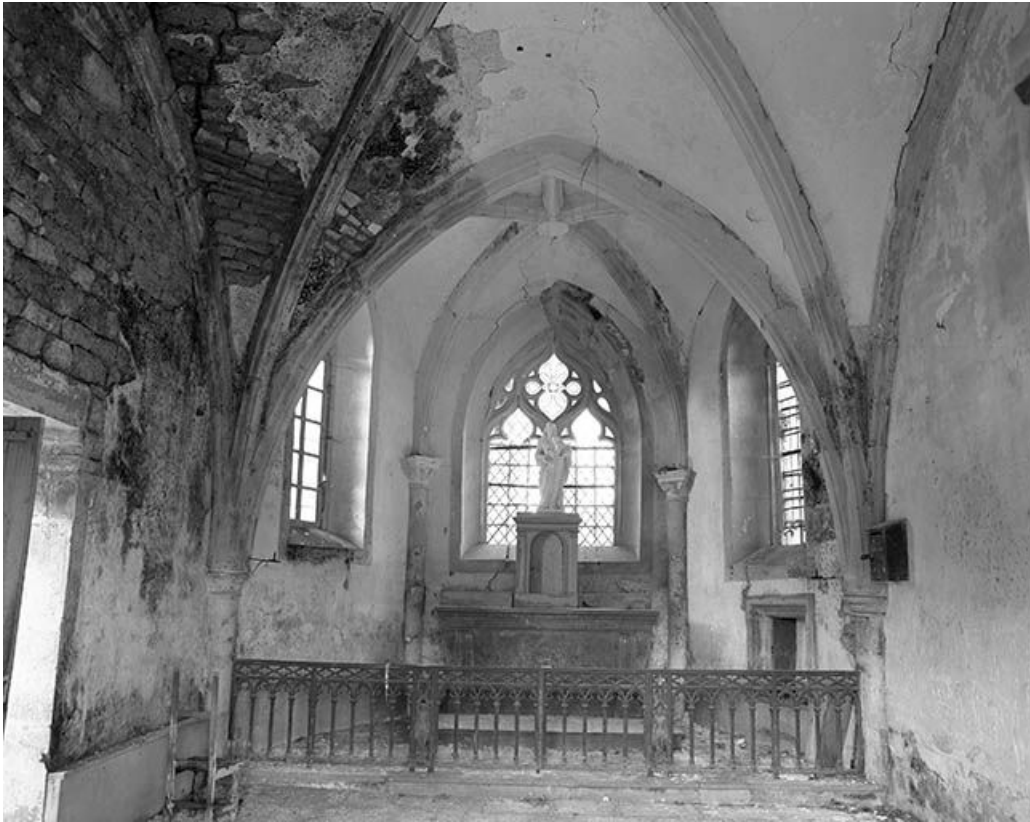
Intérieur de la chapelle : le chœur.
