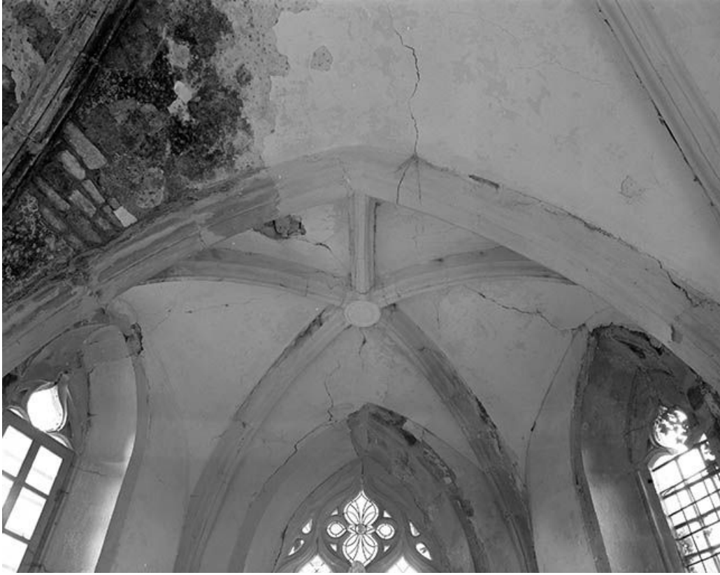
Intérieur de la chapelle : voûte du choeur.
