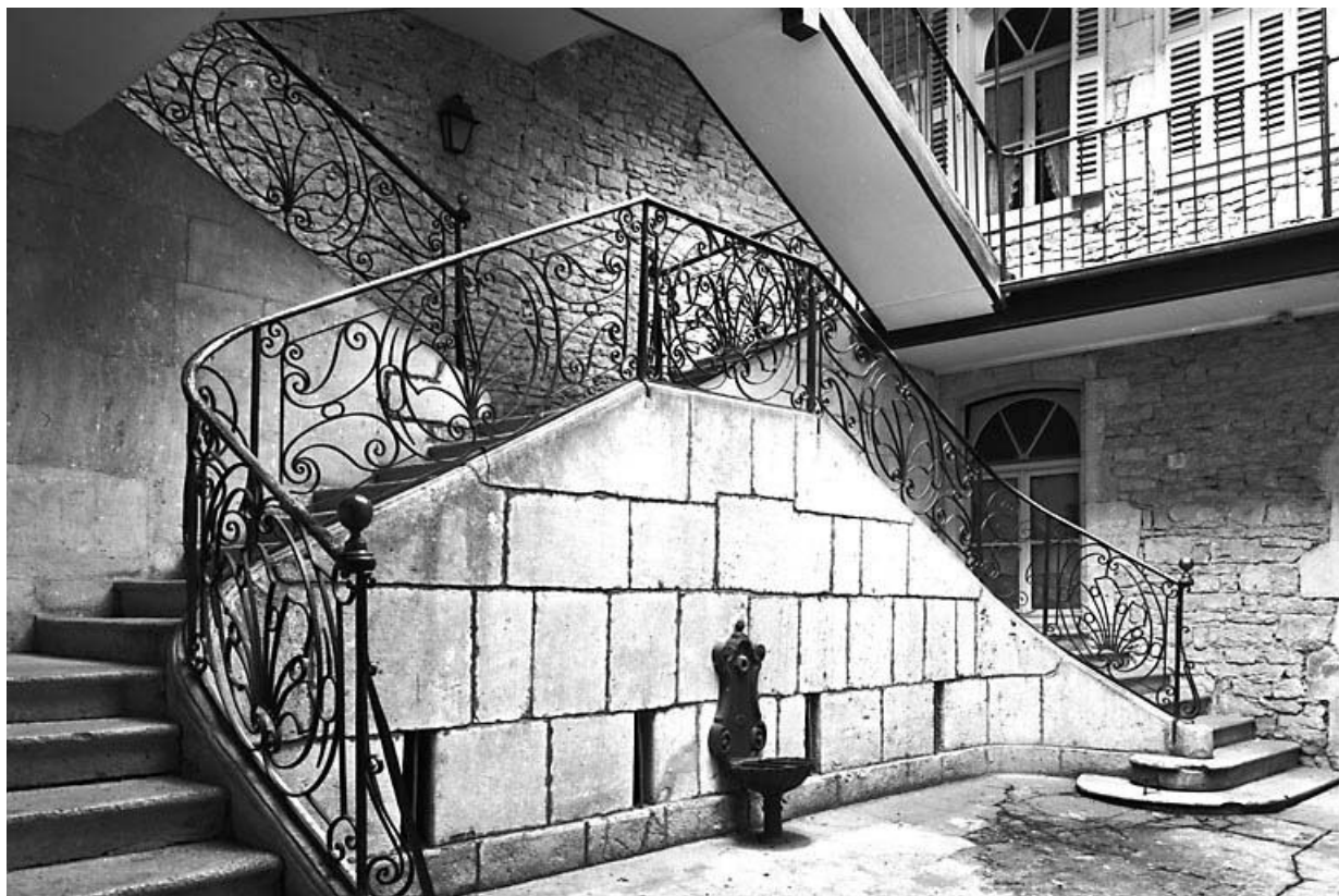
Les deux premiers niveaux de l'escalier sur cour.
