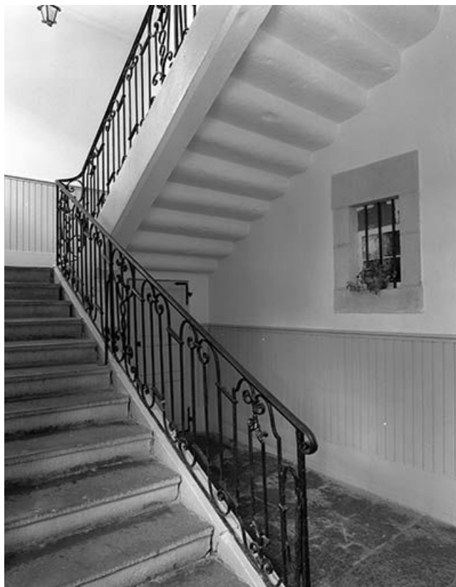
Intérieur, escalier : 1ère volée. 25, Ornans, 5 rue Pierre Vernier
