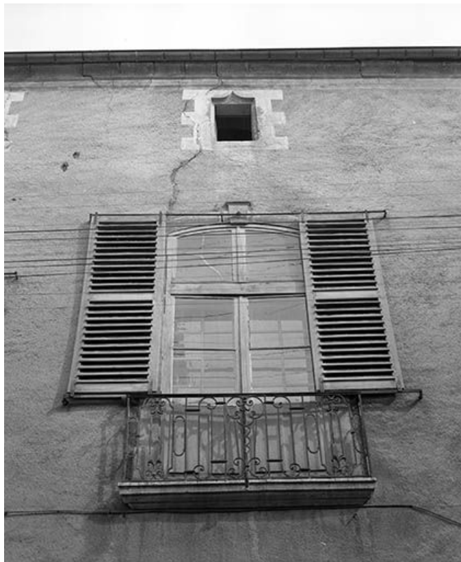
Face latérale gauche, détail d'une travée.
