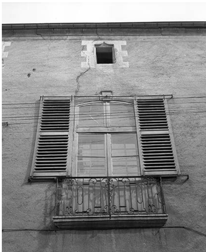
Face latérale gauche, détail d'une travée.
