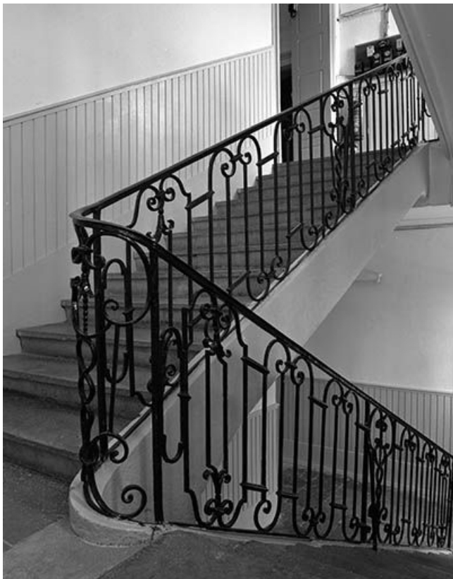
Intérieur, escalier : 2ème volée. 25, Ornans, 5 rue Pierre Vernier
