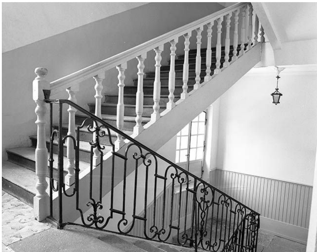
Intérieur, escalier : 3ème volée. 25, Ornans, 5 rue Pierre Vernier
