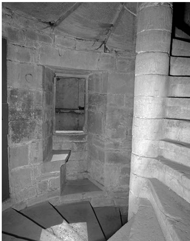
Intérieur : escalier baie du 1er étage avec volet fermé.
