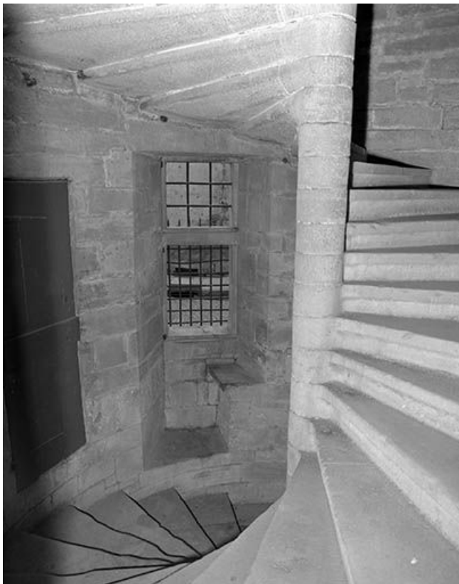
Intérieur : escalier baie du rez-de-chaussée.
