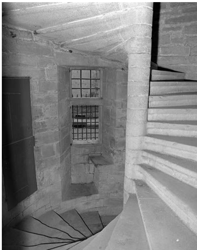
Intérieur : escalier baie du rez-de-chaussée.
