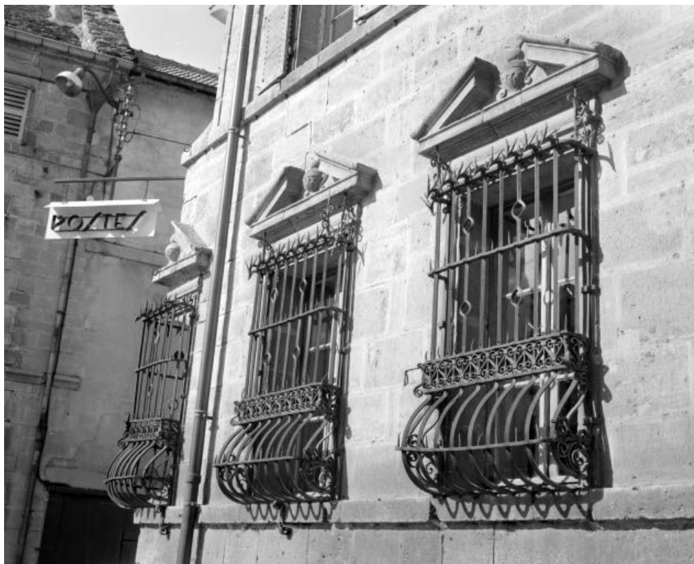
Façade antérieure, détail : baies du rez-de-chaussée, vue de trois quarts droit. 25, Ornans, 26 rue Saint-Laurent
