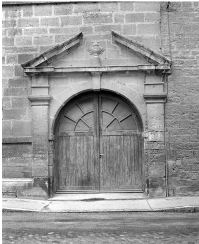
Façade antérieure : porte cochère.
