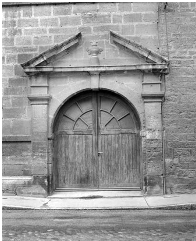
Façade antérieure : porte cochère.
