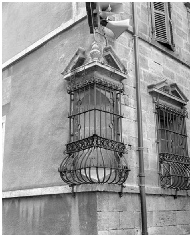
Façade antérieure, détail : baie d'angle et 1ère baie du rez-de-chaussée. 25, Ornans, 26 rue Saint-Laurent
