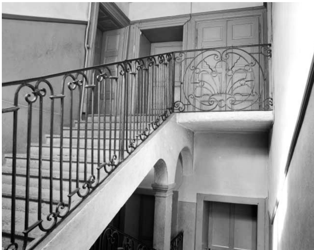
Intérieur : vue générale de l'escalier.
