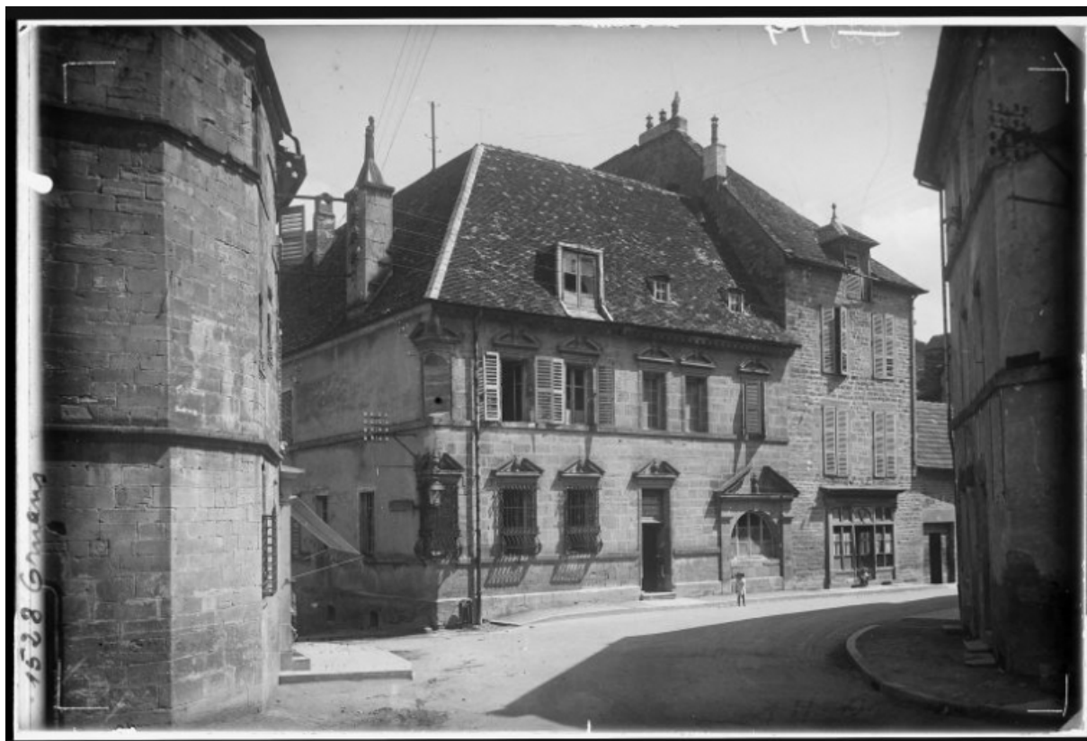
Façade antérieure et façade latérale gauche [1re moitié 20e siècle]. 25, Ornans, 26 rue Saint-Laurent
