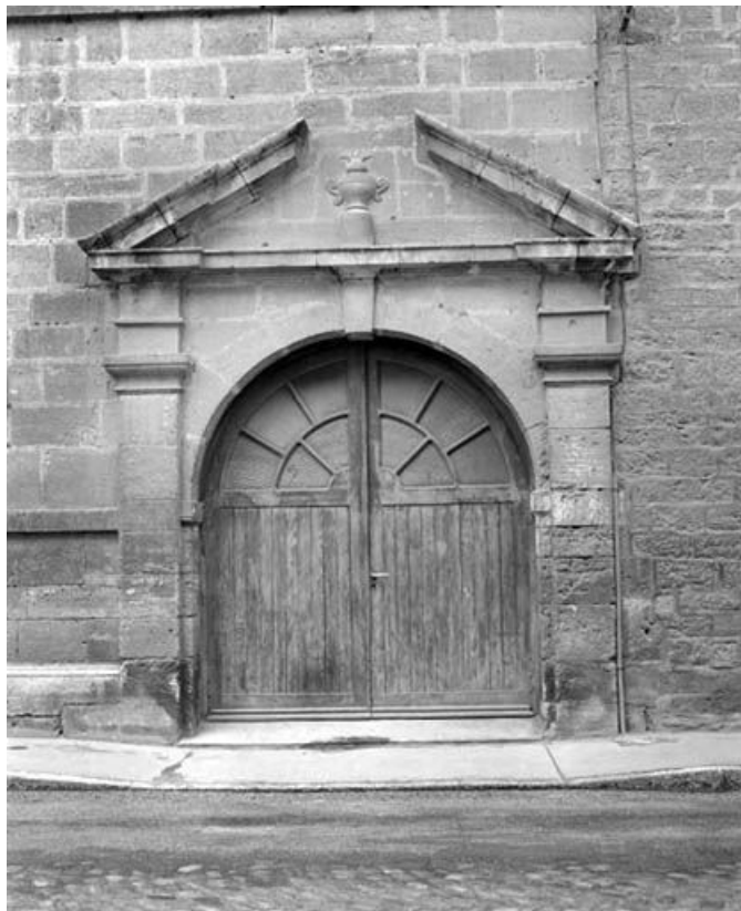
Façade antérieure : porte cochère.
