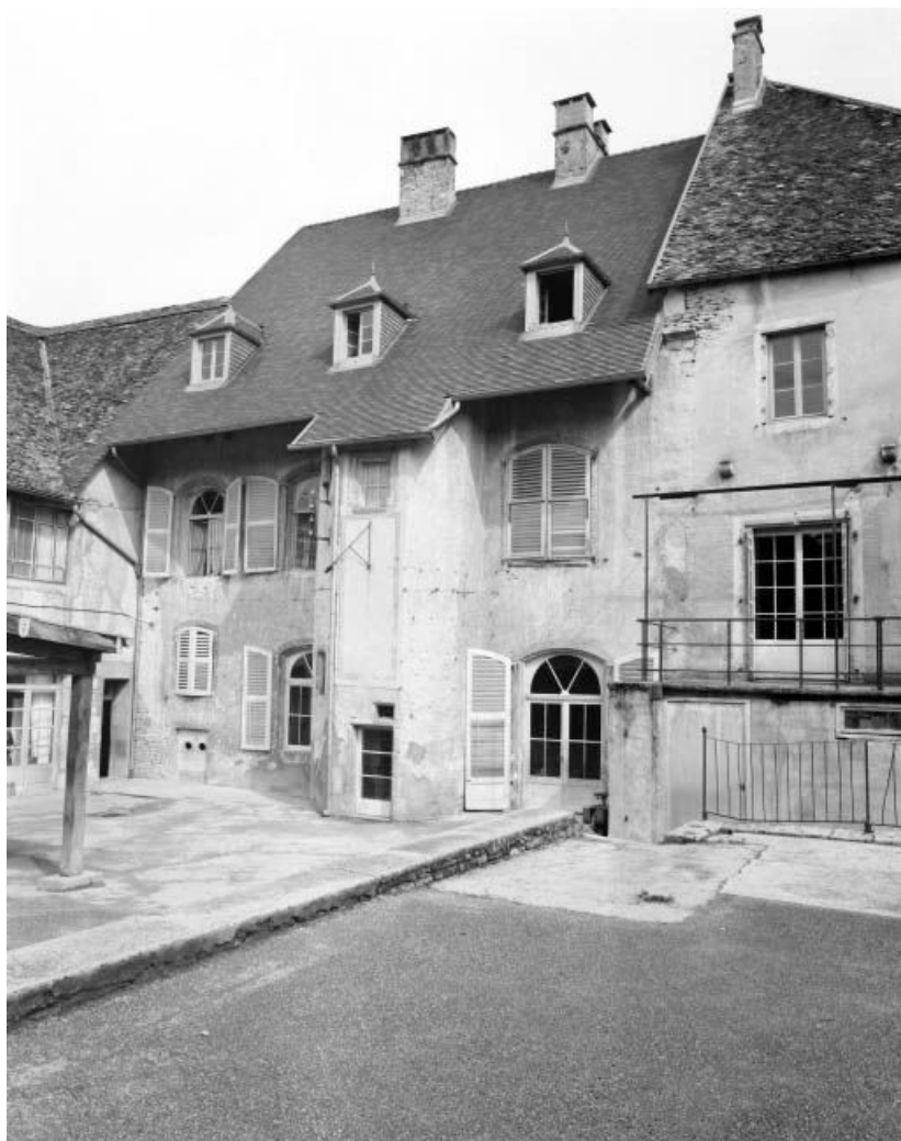
Façade postérieure, vue de trois quarts droit.
