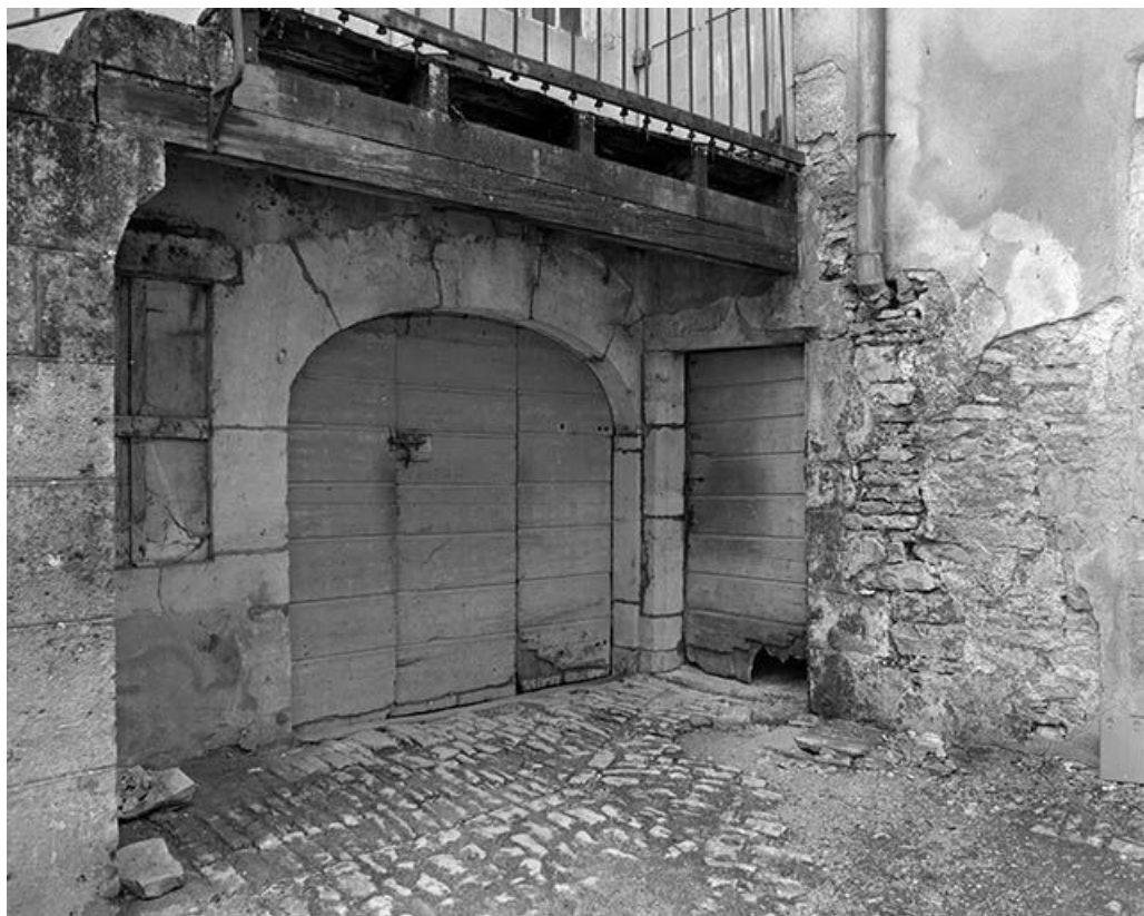
Façade sur cour : porte charretière et porte piétonne.
