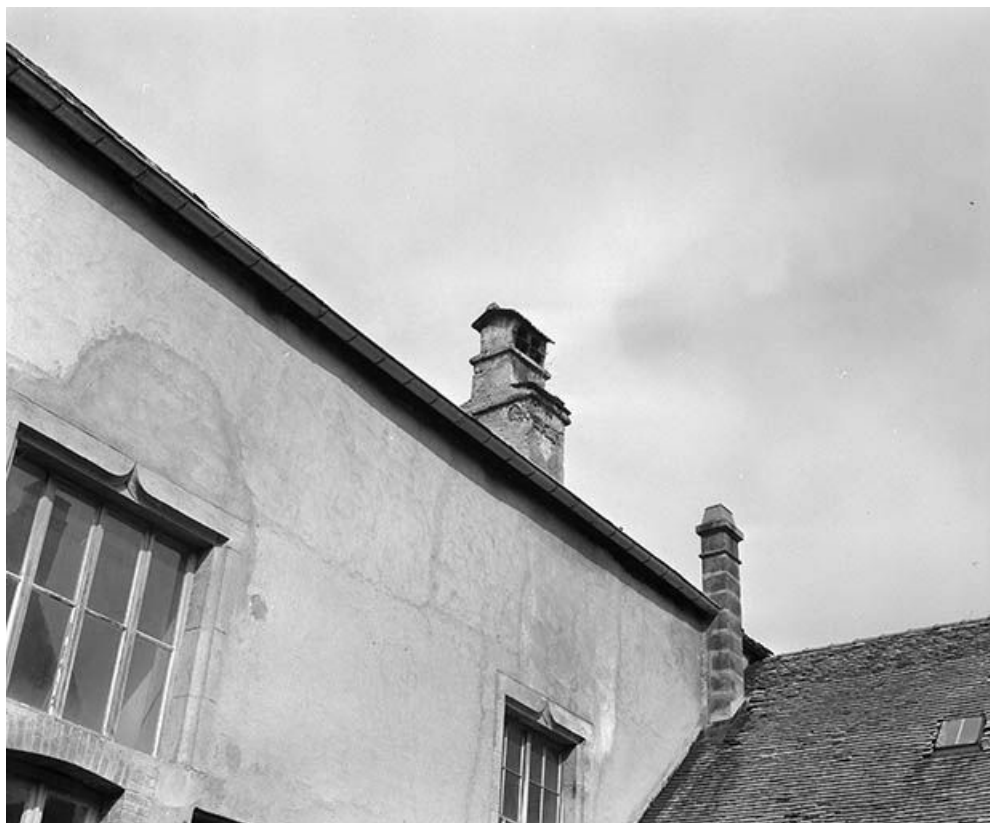
Façade sur cour, détail : cheminée.
