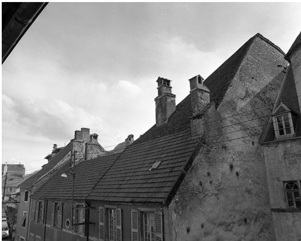
Façade antérieure, détail : cheminées.
