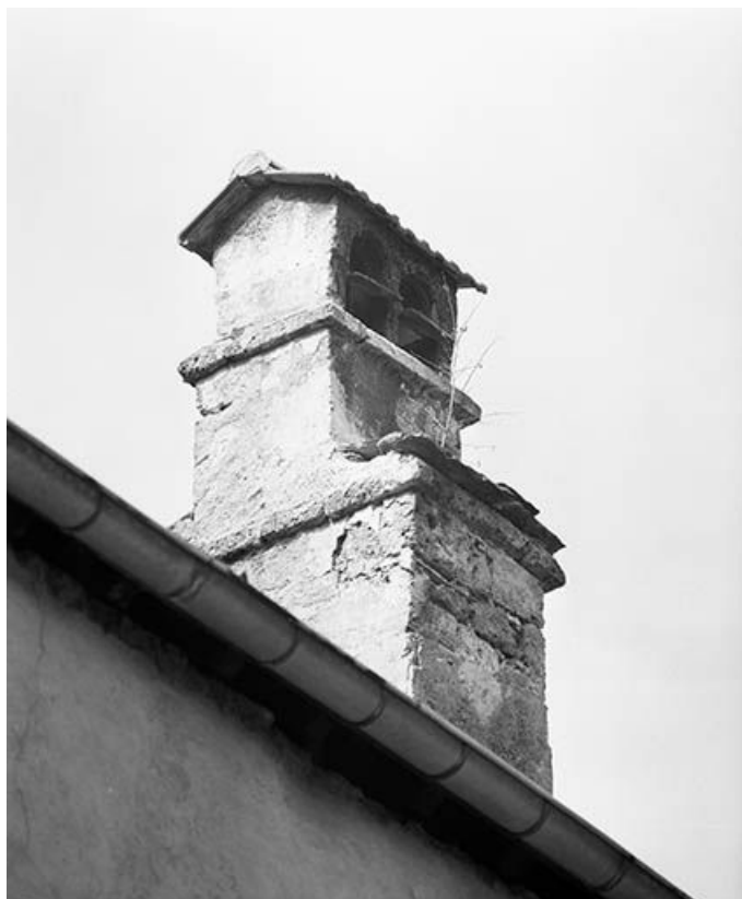
Façade sur cour, détail : cheminée vue en contre-plongée.
