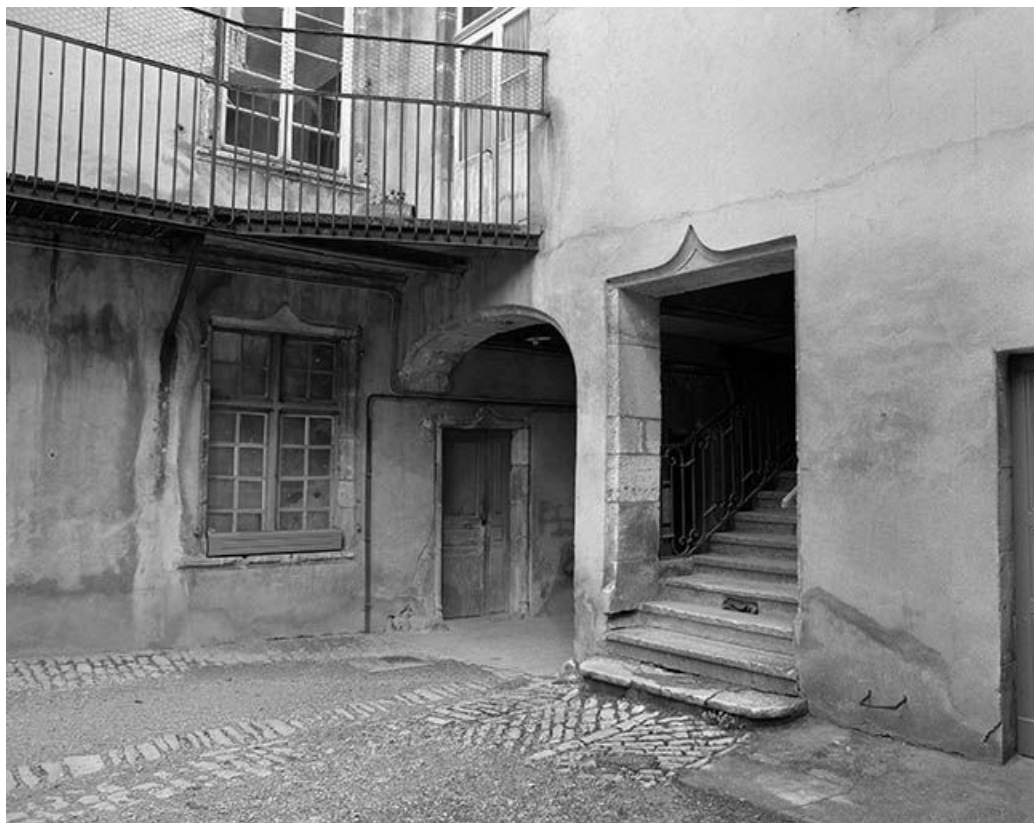
Façade postérieure, passage couvert et entrée de l'escalier. 25, Ornans, 5 rue Saint-Laurent
