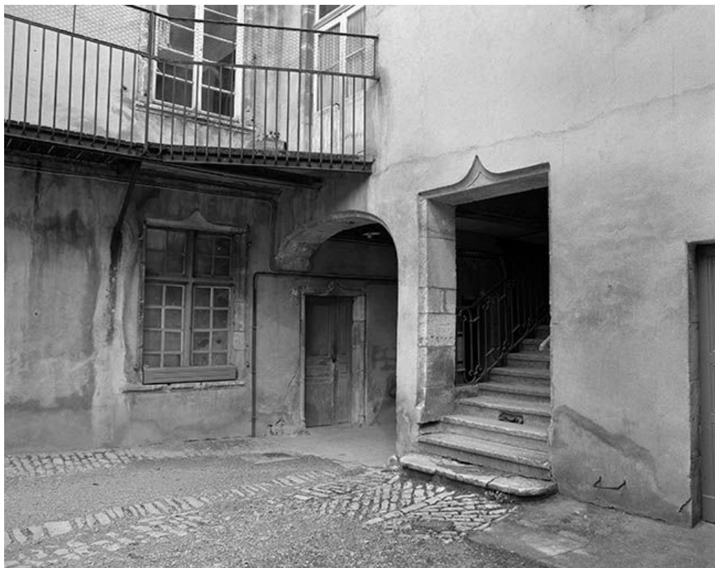
Façade postérieure, passage couvert et entrée de l'escalier.
