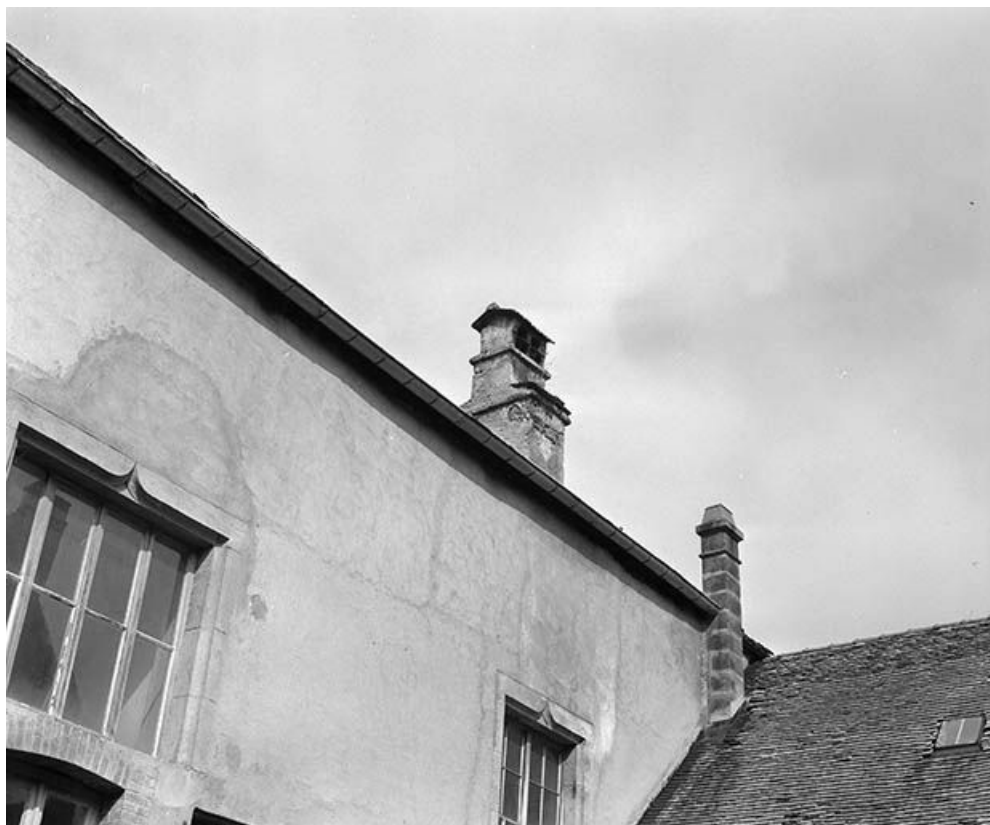
Façade sur cour, détail : cheminée.
