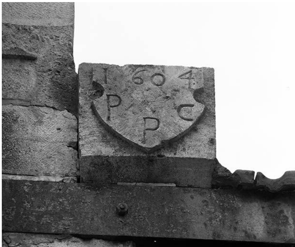
Façade antérieure, détail : pierre portant l'inscription PPC et la date 1604, vue en contre-plongée. 25, Ornans, 5 rue du Moulin
