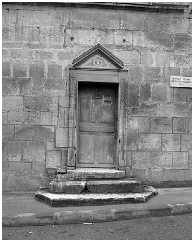
Façade antérieure : porte d'entrée.
