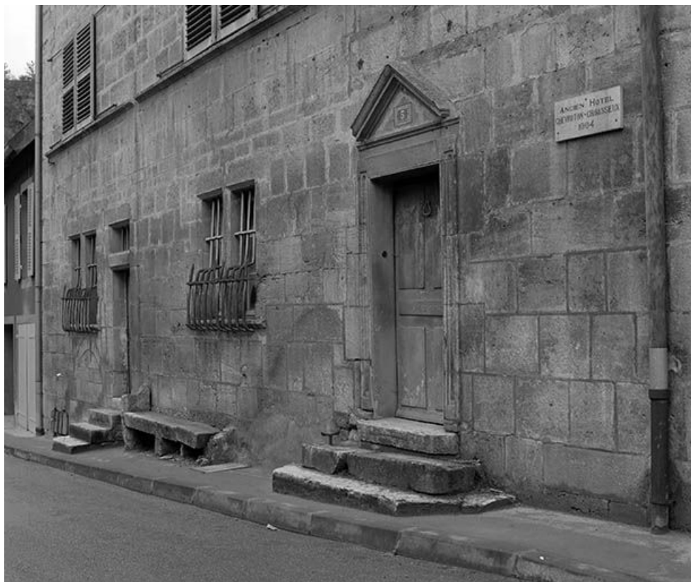
Façade antérieure : le rez-de-chaussée. 25, Ornans, 5 rue du Moulin
