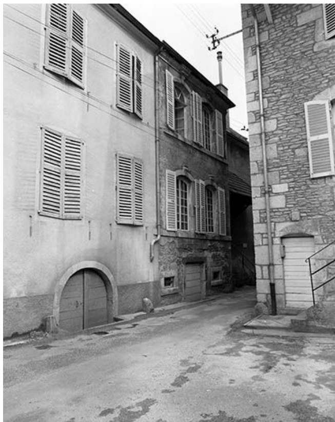
Façade antérieure vue de trois quart gauche.
