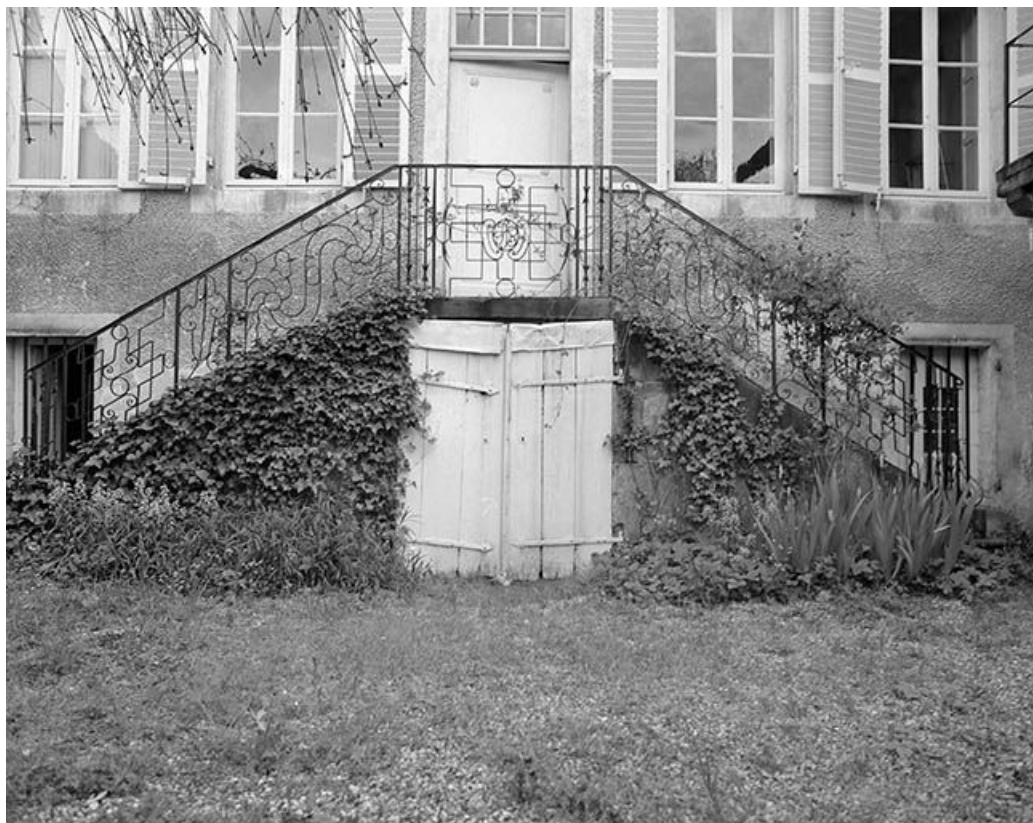
Façade antérieure, escalier vu de face.
