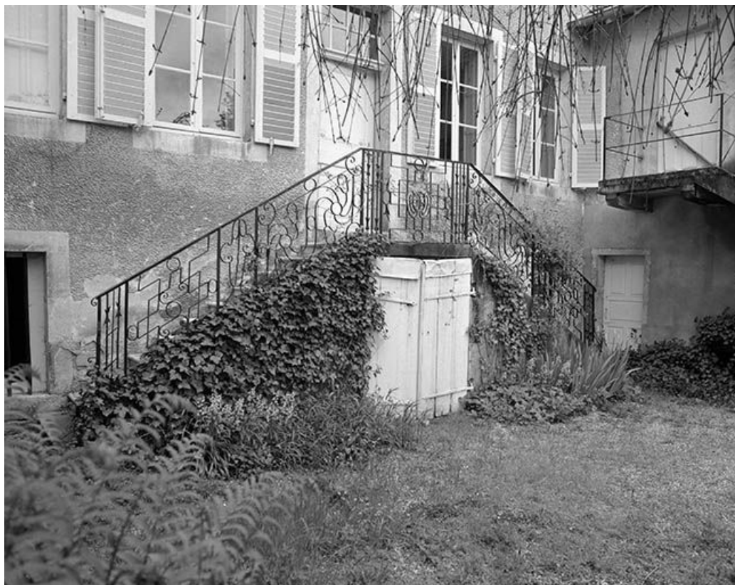
Façade antérieure, escalier vu de trois quarts gauche.
