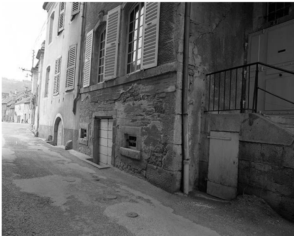
Façade antérieure : le rez-de-chaussée et le sous-sol.
