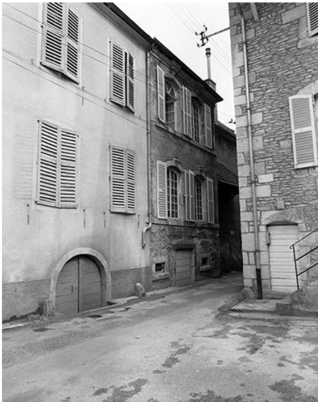
Façade antérieure vue de trois quart gauche.
