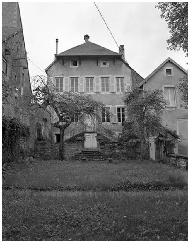
Façade antérieure depuis le jardin.
