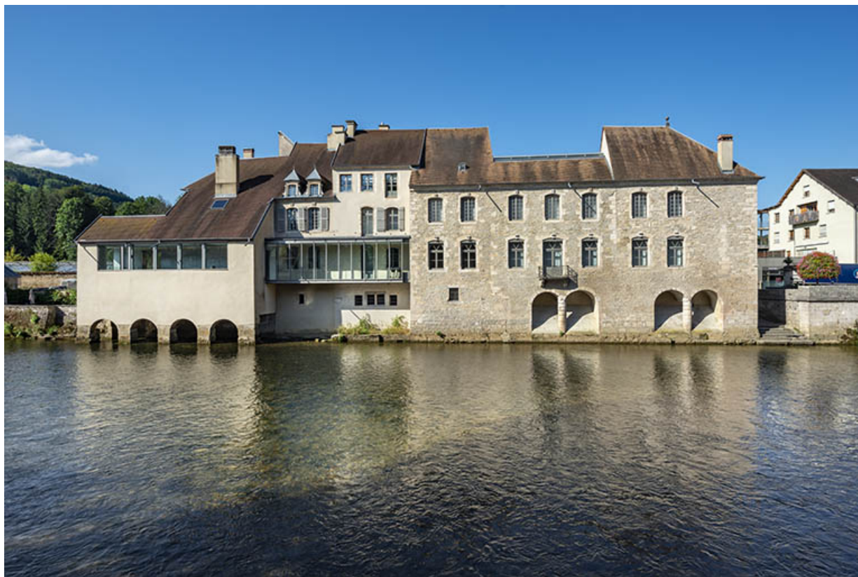
Façade postérieure en 2019.
