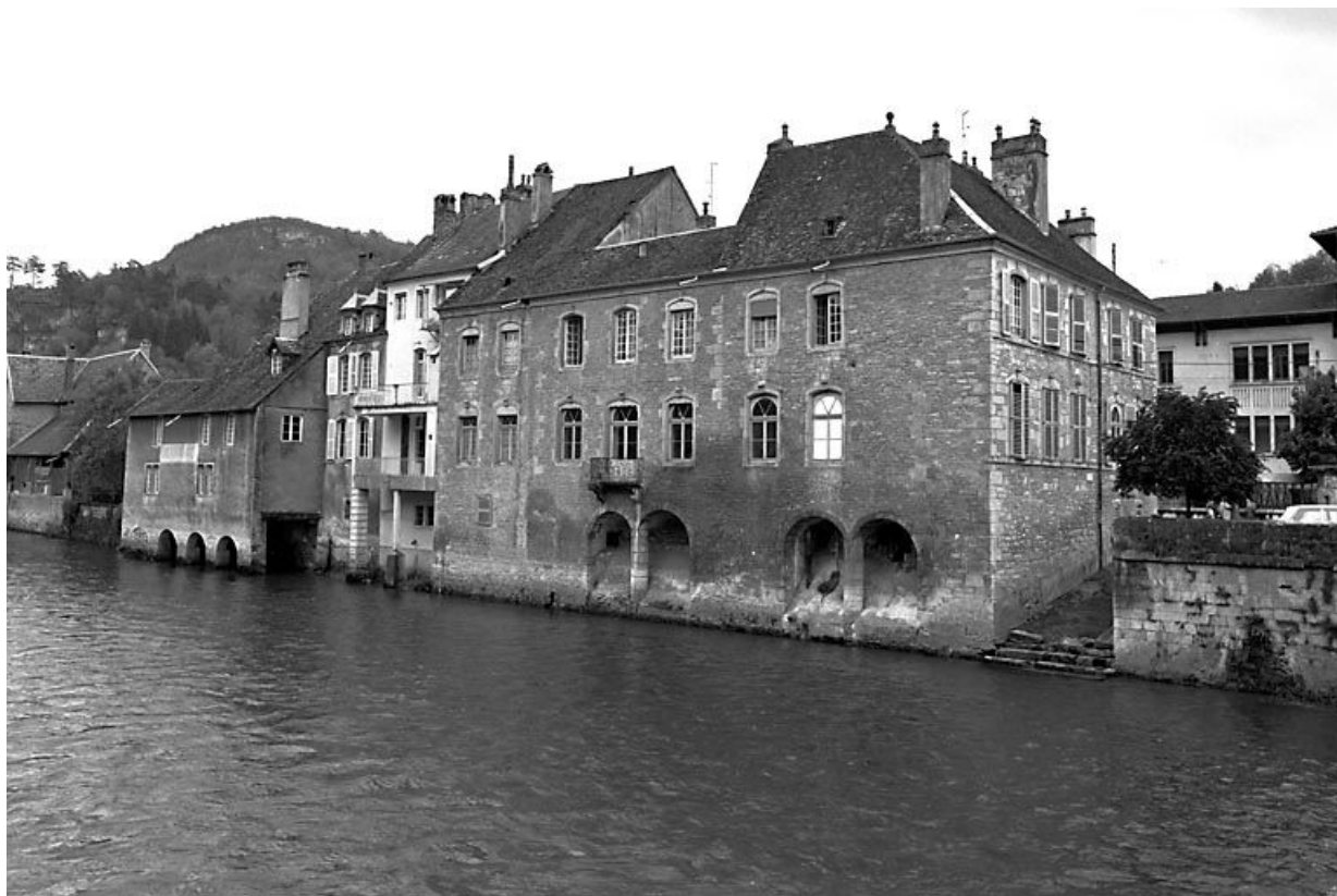
Façade postérieure et façade latérale gauche.
