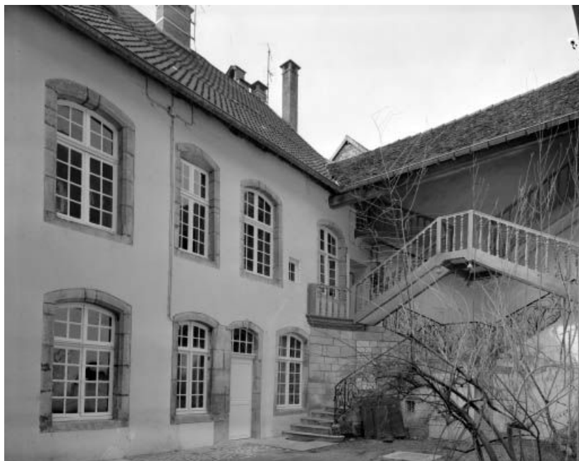
Façade postérieure, vue de trois quarts gauche.
