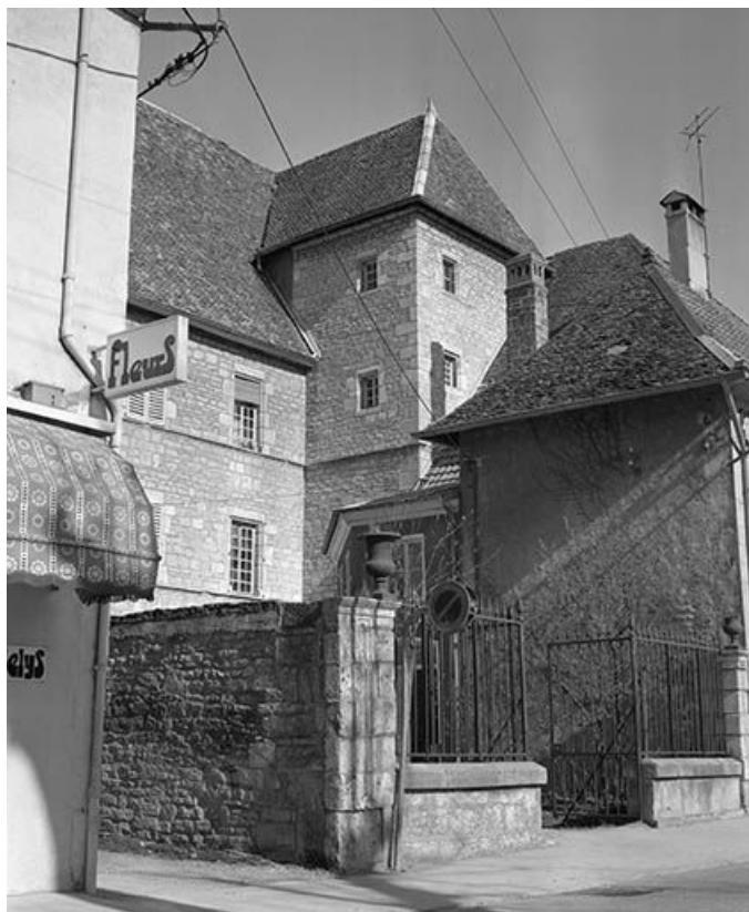
Façade antérieure : vue de trois quarts gauche.
