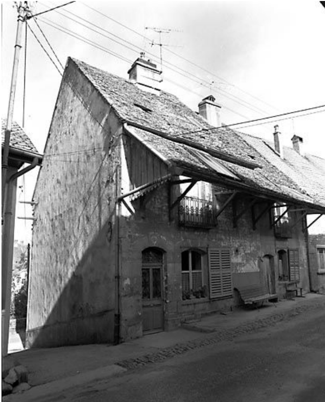
Façade antérieure et face latérale gauche. 25, Ornans
