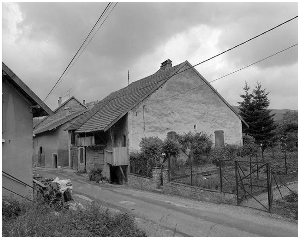
Façade antérieure et face latérale droite.
