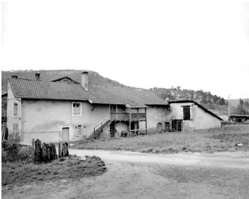
Maison située 9 rue du Viaduc. 25, Ornans
