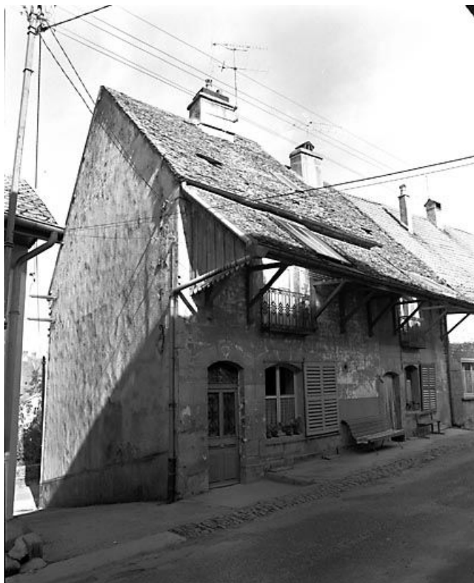
Façade antérieure et face latérale gauche. 25, Ornans
