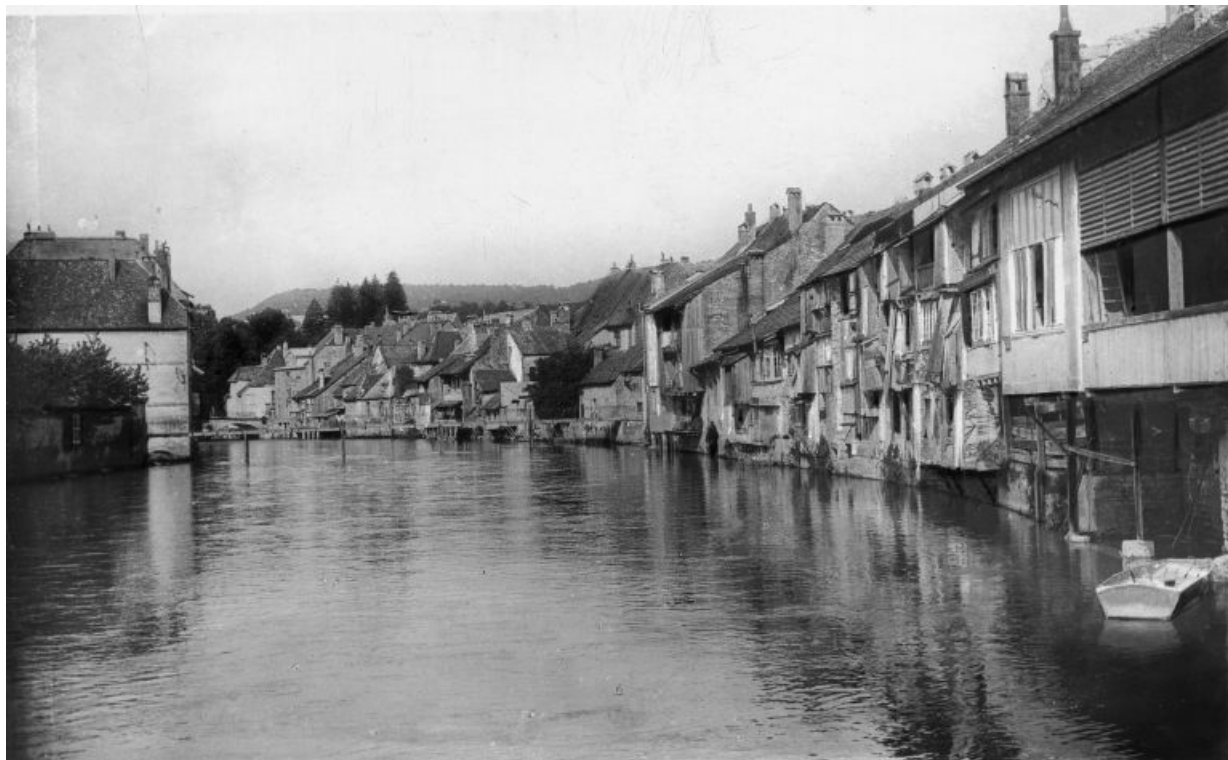
Maisons au bord de la Loue : façades postérieures, donnant sur la rivière [1re moitié 20e siècle]. 25, Ornans
