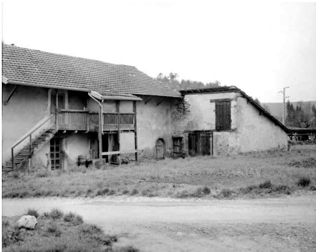
Maison située 9 rue du Viaduc. 25, Ornans
