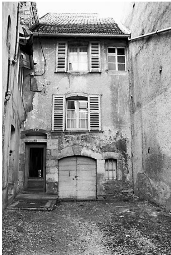
Façade antérieure sur cour.
