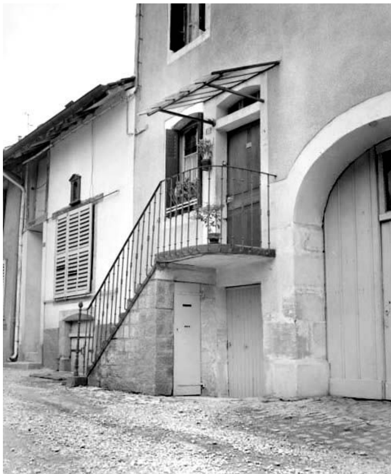
Maison située 13 rue des Martinets. 25, Ornans
