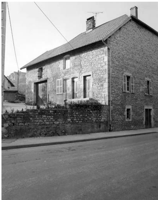
Fig. 12 : Ferme située 2 rue du Viaduc. 25, Ornans
