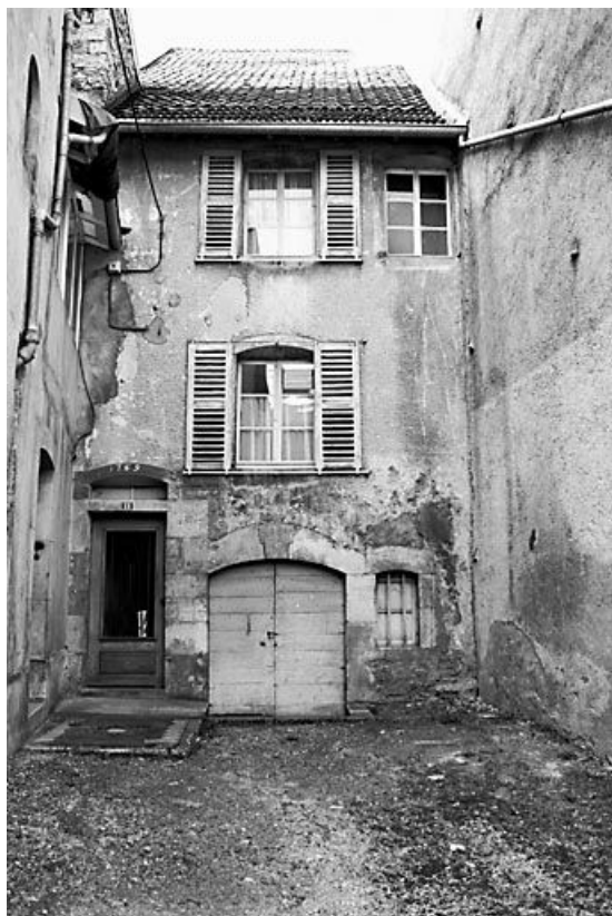
Façade antérieure sur cour.
