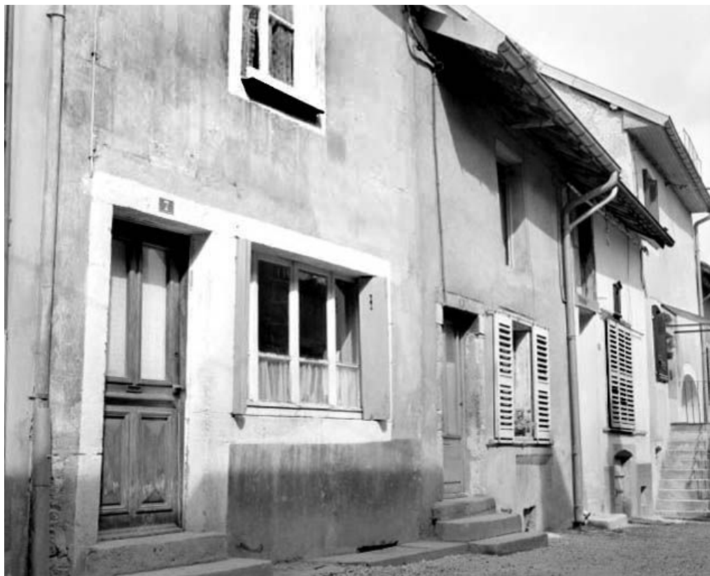
Maisons situées 7 et 9 rue des Martinets. 25, Ornans
