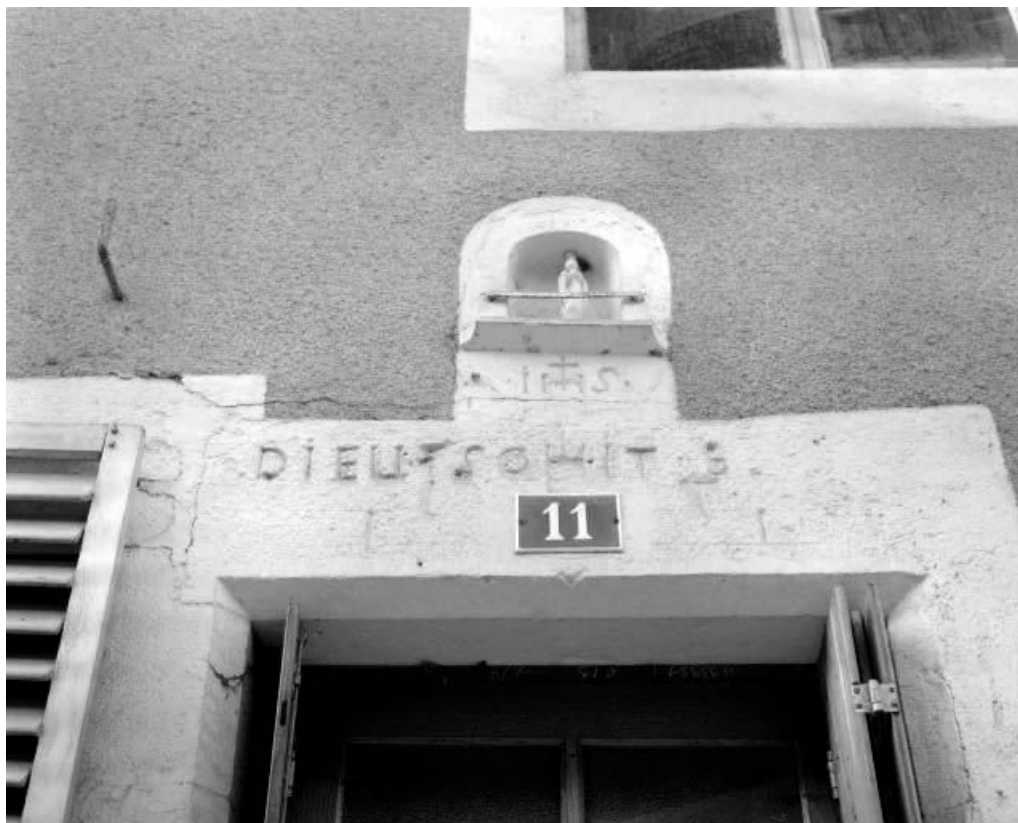
Maison située 11 rue du Moulin : inscription sur le linteau de la porte piétonne. 25, Ornans
