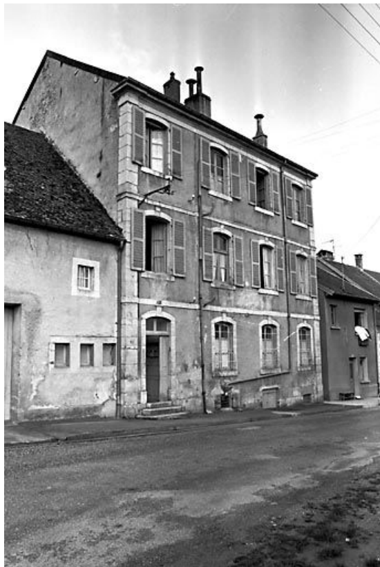
Façade antérieure de trois quarts gauche. 25, Ornans
