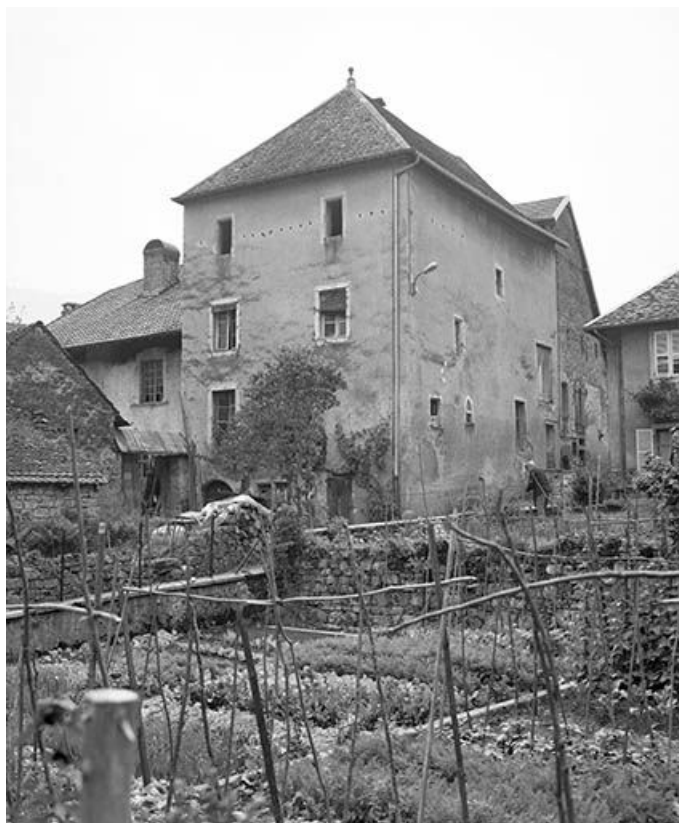
Façade antérieure et face latérale droite.
