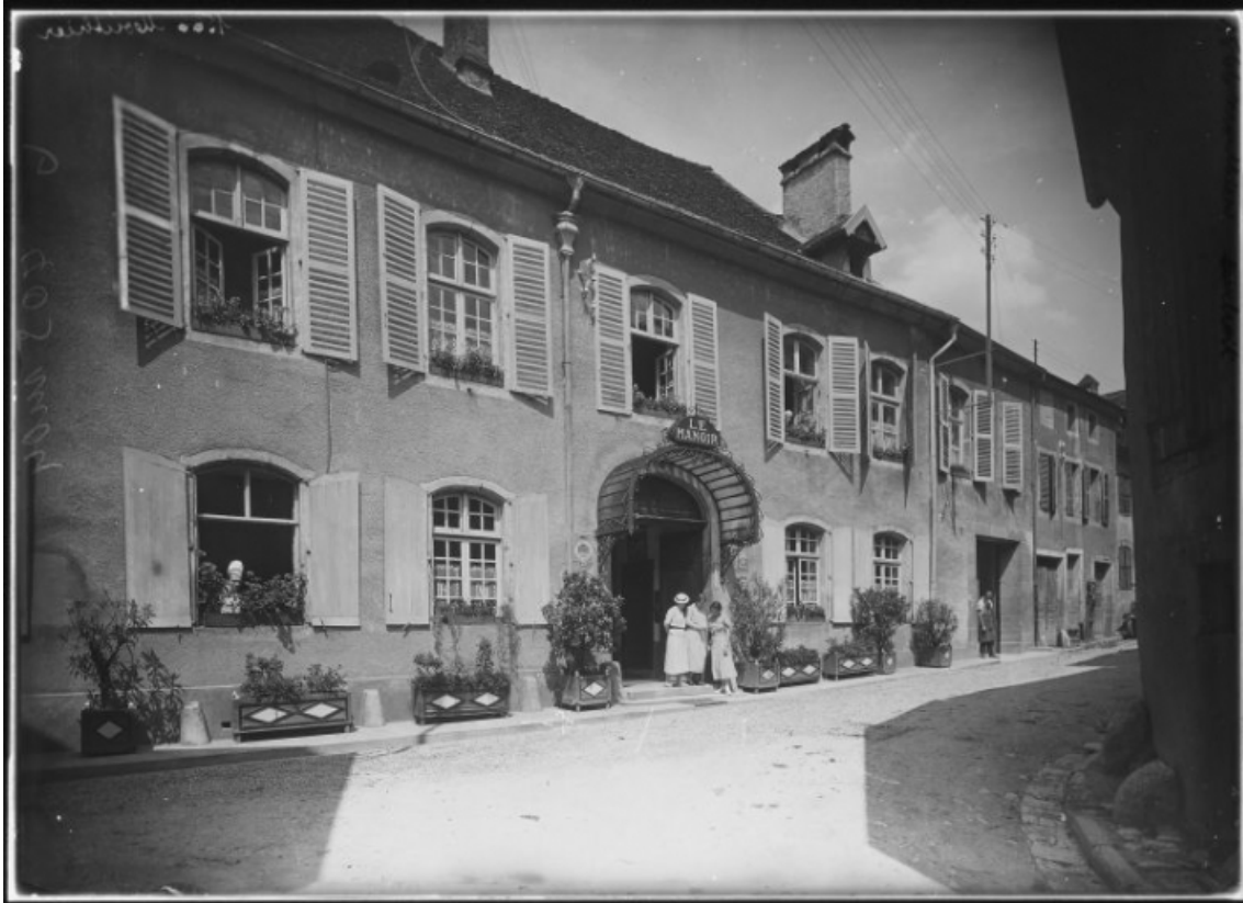
Façade antérieure vue de trois quarts gauche [1re moitié 20e siècle]. 25, Mouthier-Haute-Pierre, 25 Grande Rue
