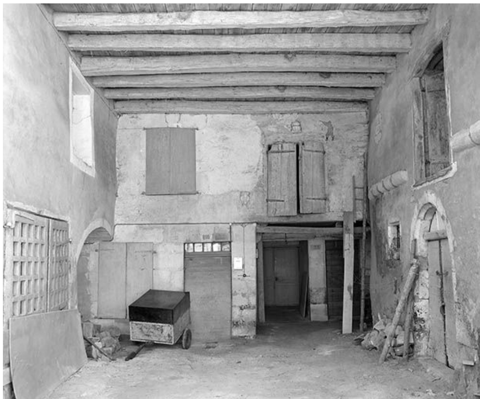
Façade antérieure : le passage plafonné.
