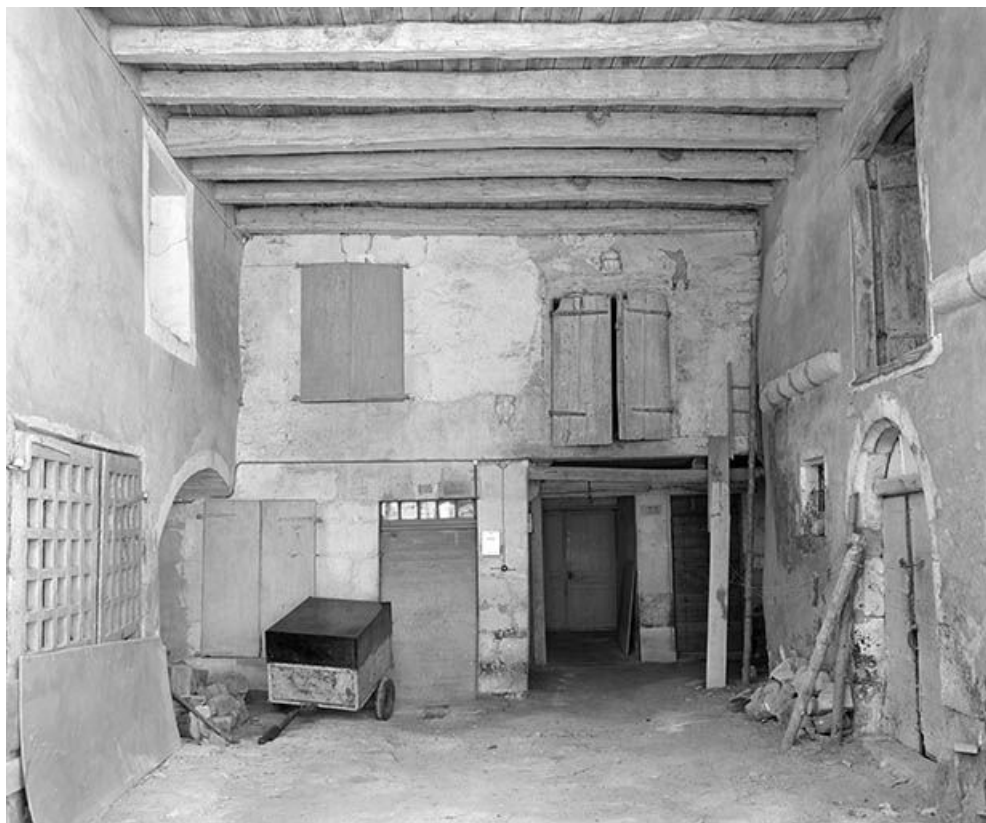
Façade antérieure : le passage plafonné.
