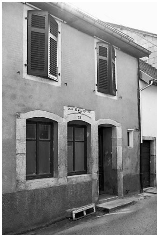
Façade antérieure vue de trois quarts gauche. 25, Mouthier-Haute-Pierre, 21 rue Robert Dame
