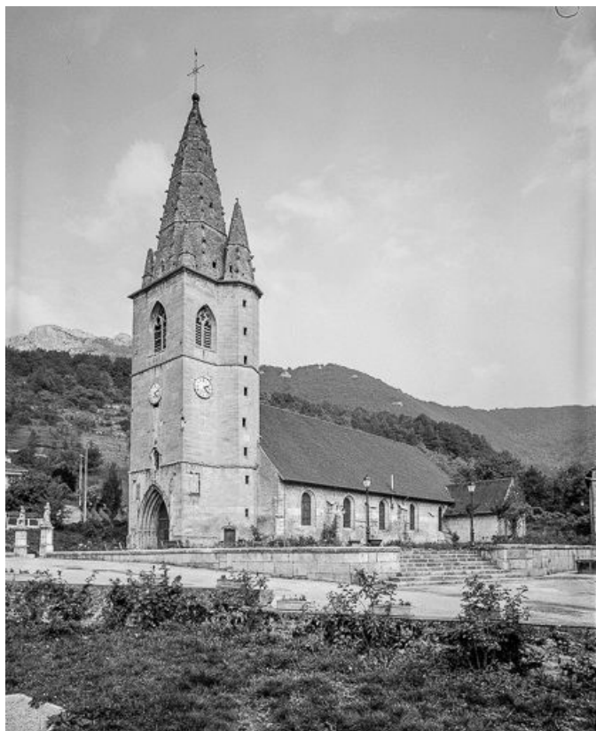
Façade antérieure et face latérale droite.
