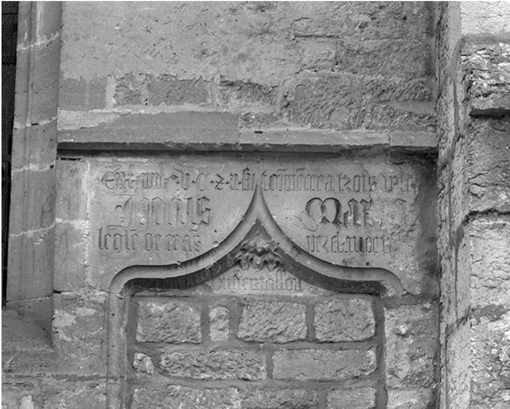
Détail de la face latérale droite : linteau de l'ancienne porte.
