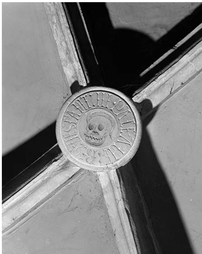
Intérieur : 1ère travée du collatéral gauche, clef annulaire de la chapelle consacrée aux défunts. 25, Mouthier-Haute-Pierre place Césaire Phisalix
