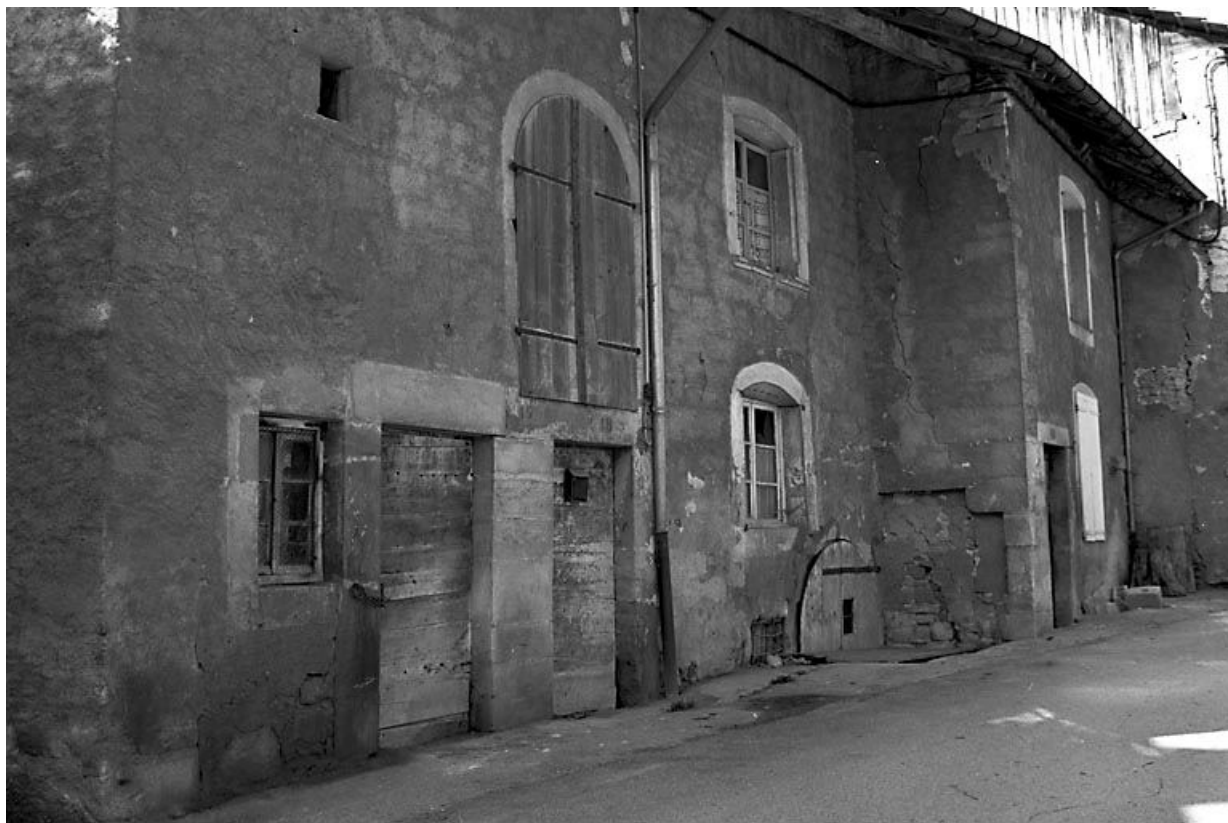
Façade antérieure vue de trois quarts gauche. 25, Mouthier-Haute-Pierre, 11 rue Robert Dame
