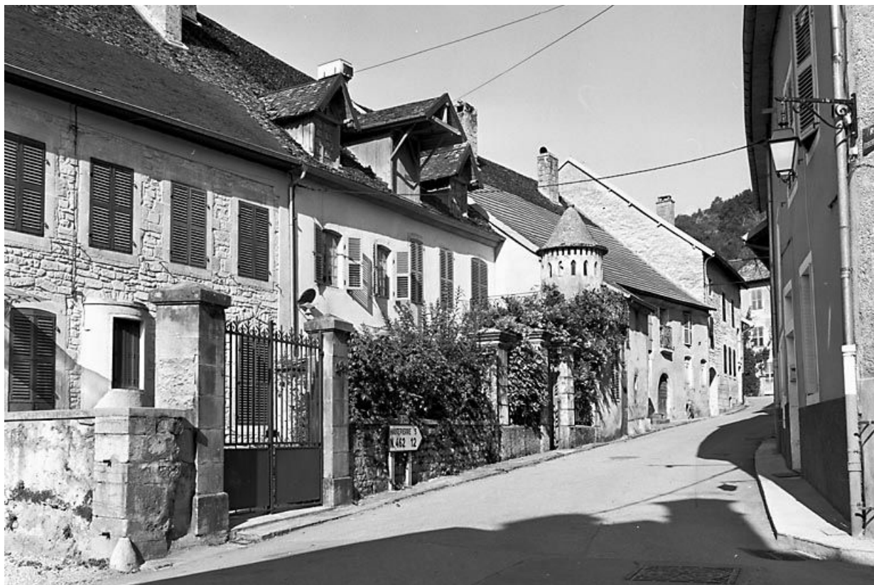
Façade antérieure vue de trois quarts gauche.
