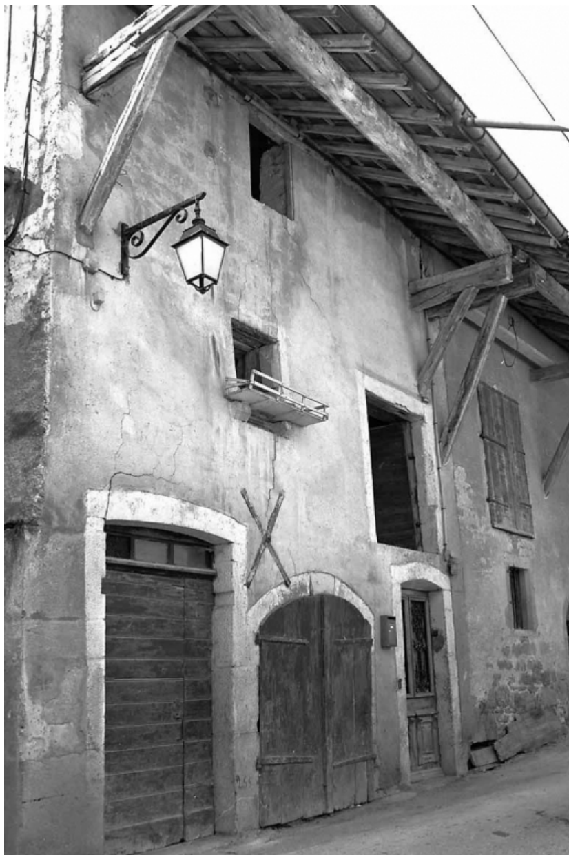
Façade antérieure vue de trois quarts gauche.
