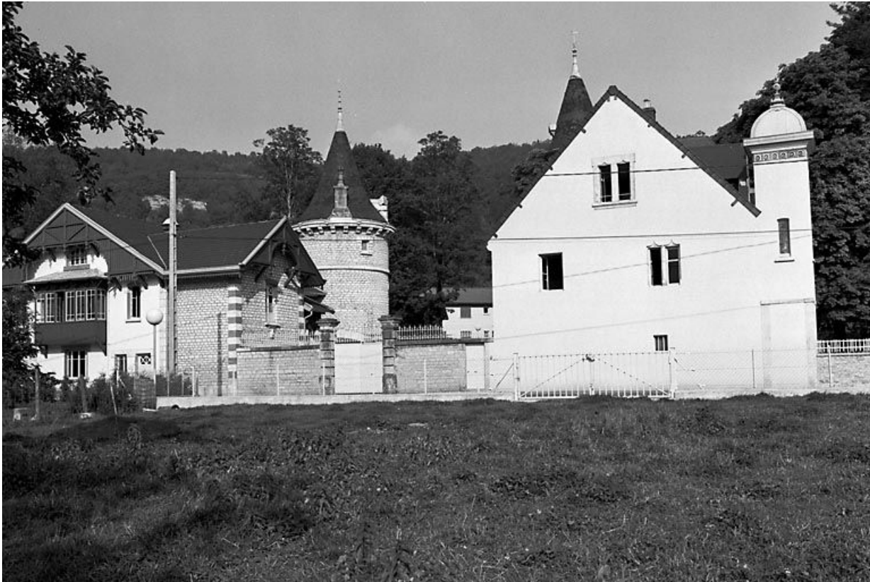
Vue d'ensemble depuis la rue du Mont d'Oeil. 25, Montgesoye
