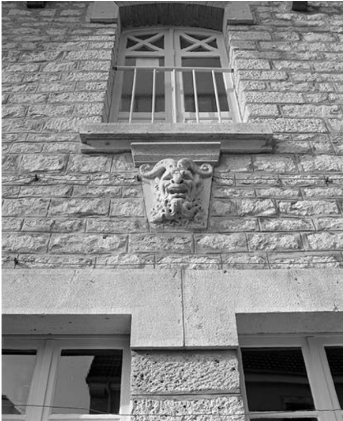
Culot au-dessous de la baie du 1er étage des communs.
